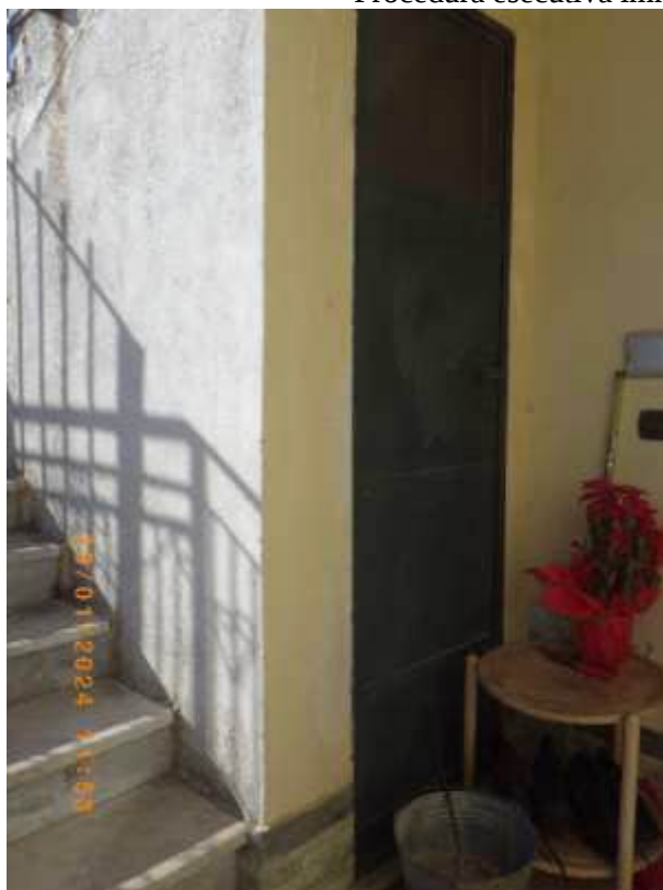
Foto 26. Vano sottoscala esterno
