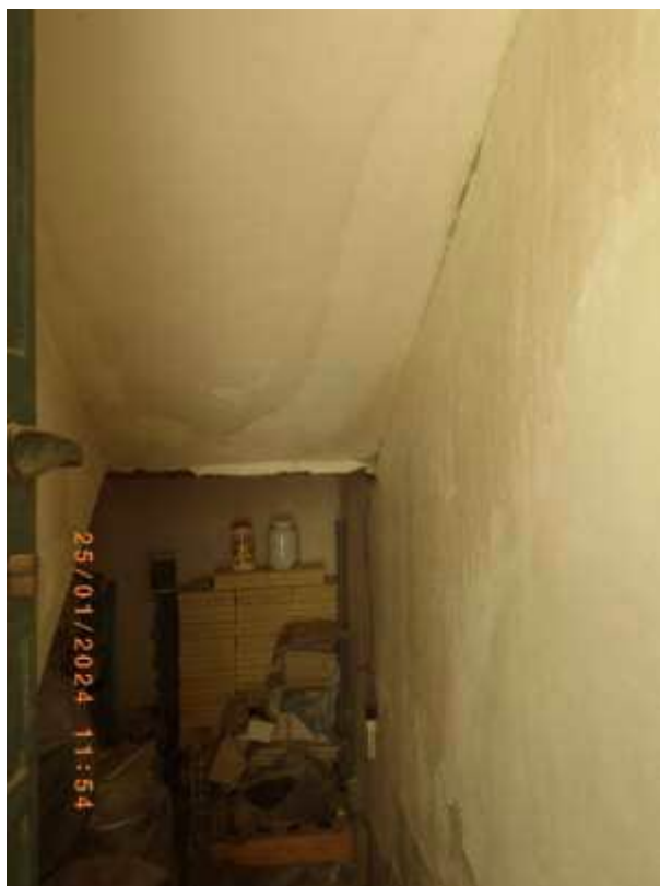
Foto 27. Vano sottoscala interno
