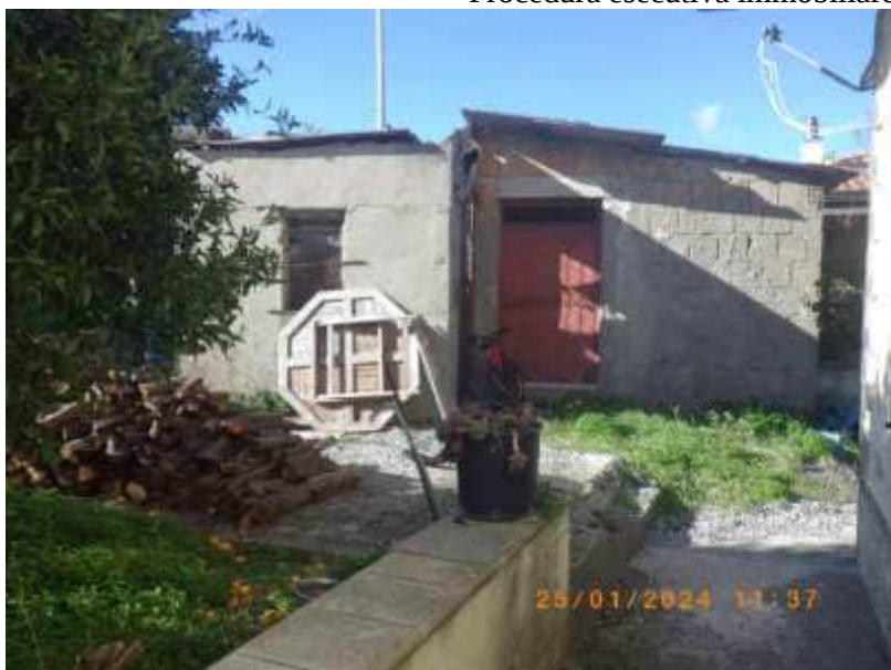
Foto 19. Manufatti realizzati in assenza di titolo edilizio
