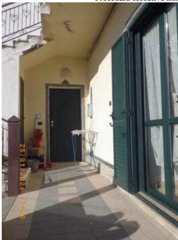
Foto 17. Porta d'ingresso e porta-finestra Cucina
