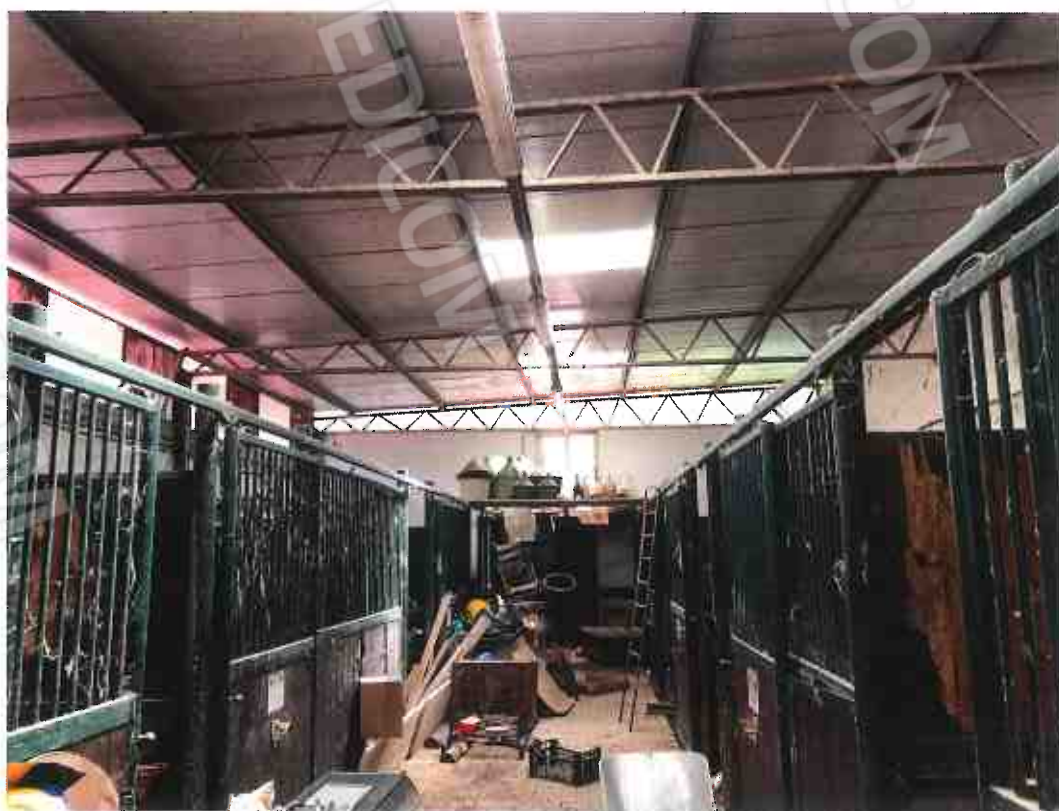
Foto 85 – Terreno con fabbricati in Argusto (lotto n. 10): interno stalla
