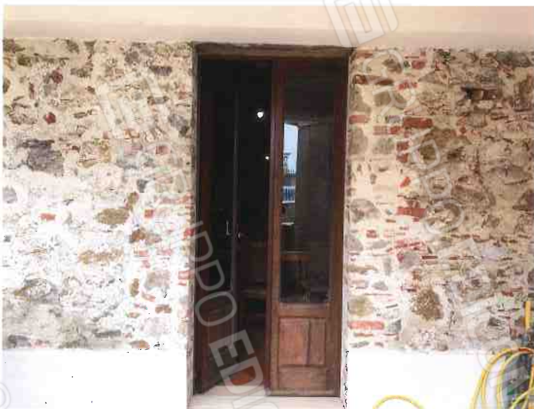
Foto 68 – Unità adibita a sala pranzo - fg. 34 part. 211 sub 6: porta d'ingresso (lotto n. 9)
