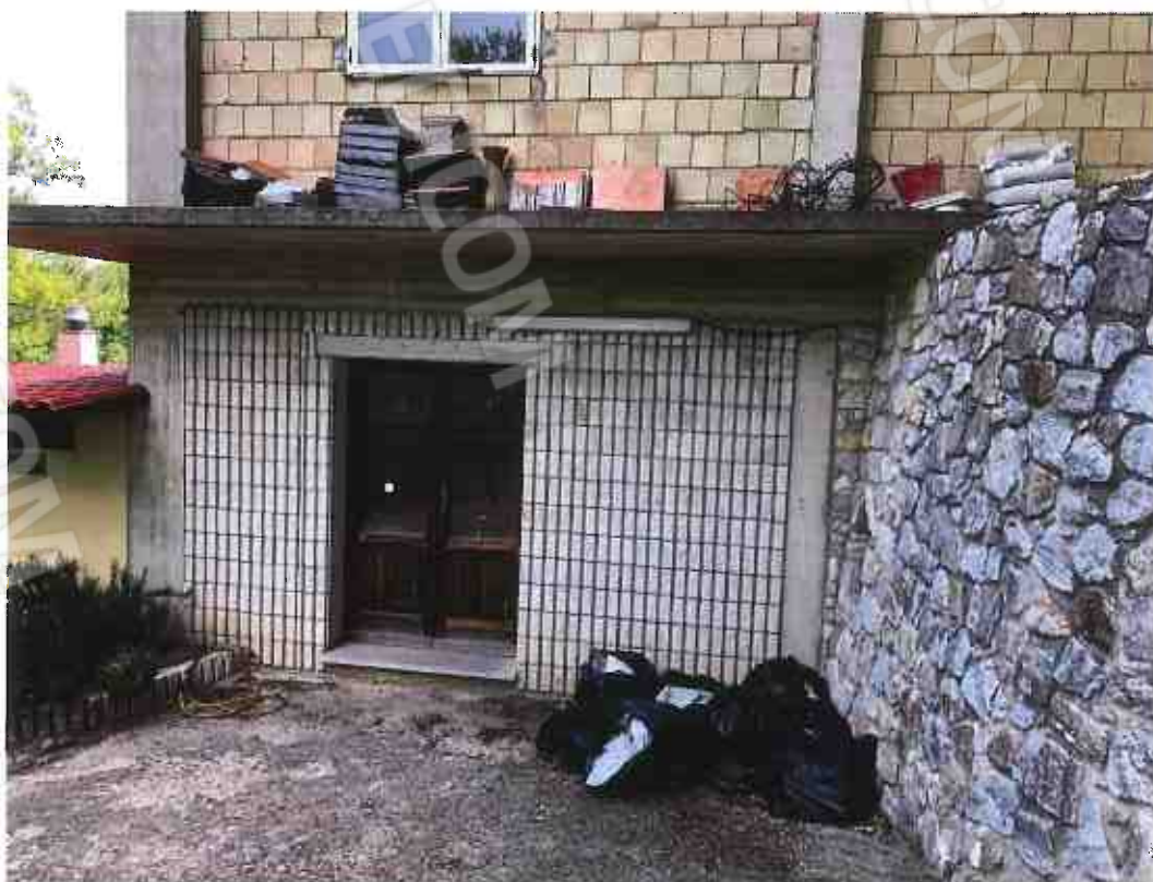
Foto 77 – Terreno con fabbricati in Argusto, loc. Castagnara” (lotto n. 10): ingresso p. S1 edificio in corso di costruzione
