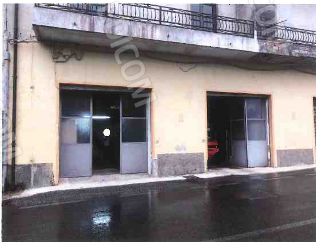
Foto 45 – Deposito sulla via Nazionale: fg 34 part. 235 sub 3 (lotto di vendita n. 4)
