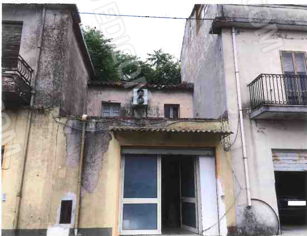
Foto 27 – Immobile in Chiaravalle C.le (via Nazionale) uso magazzini / deposito: fg 34 part. 717 - corpo avanzato, part. 563 - corpo su due livelli retrostante (lotto di vendita n. 2)
