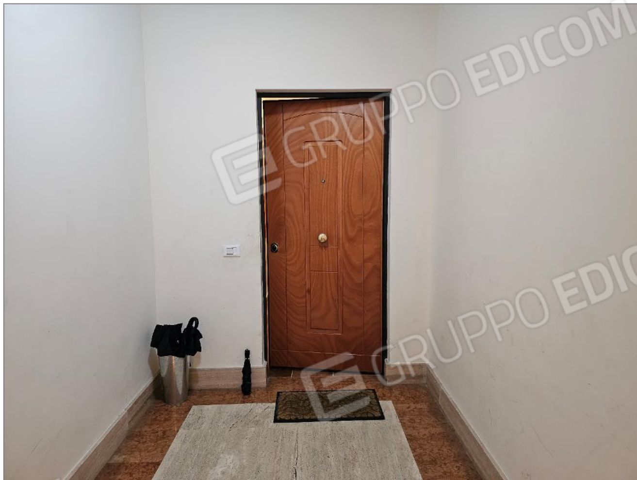
Foto 4, 5 – Portoncino di ingresso unità immobiliare e ingresso
