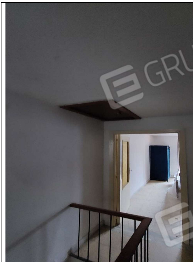
Foto 5- CORRIDOIO AL PIANO PRIMO
