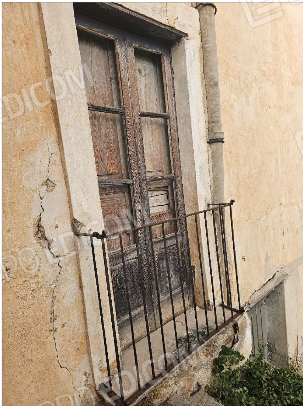
Foto 36, 37 – Particolare stato di degrado della facciata, dove sono presenti due canne fumarie in eternit e dei balconi
