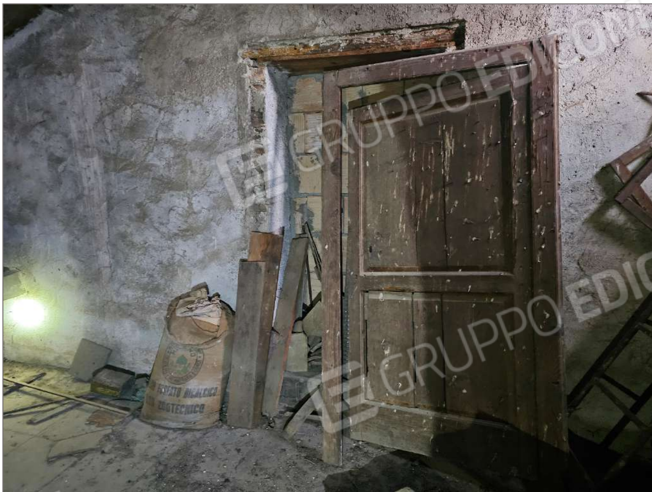
Foto 53, 54— Particolare porta murata nel sottotetto di un'altra unità immobiliare confinante che consentiva l'accesso al sub 25
