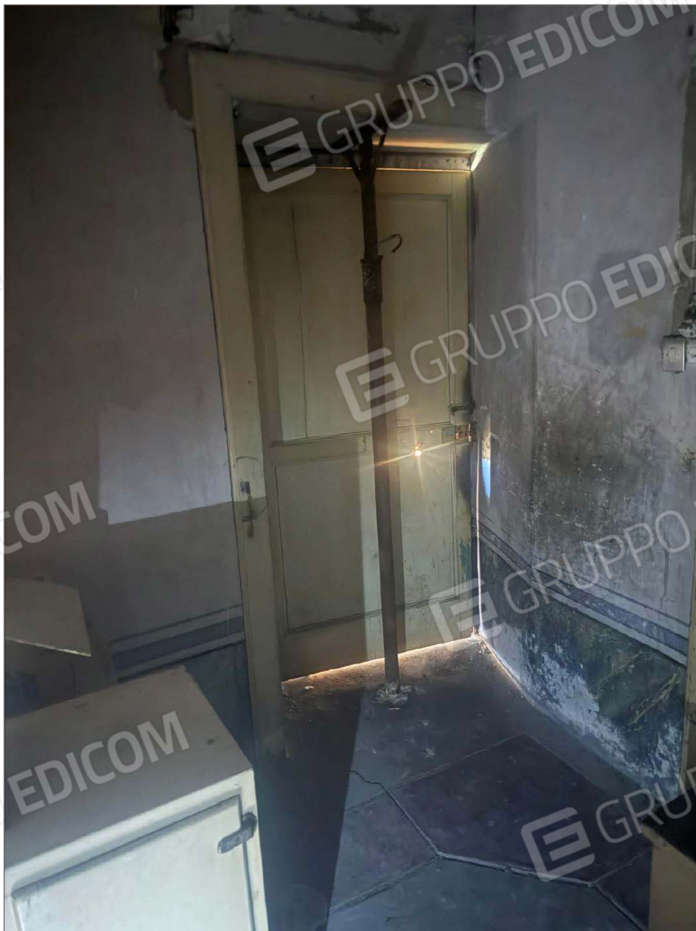
Foto 59 – Particolare intervento di tamponamento in corrispondenza delle bucare nella muratura
