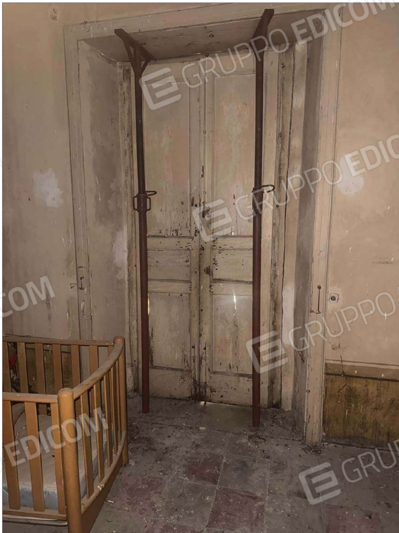
Foto 55 – Particolare intervento di tamponamento in corrispondenza delle bucaure nella muratura
