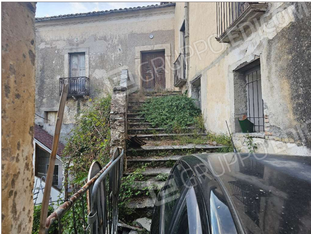
Foto 34, 35 – Condizioni di dissesto del parapetto e della scala esterna dalla quale si accede al sub 25
