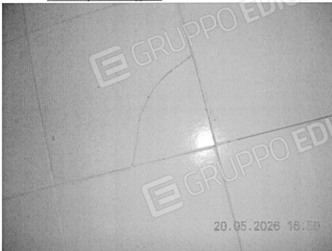
Foto n. 20 – Particolare pavimento soggiorno – piastrella sollevata
