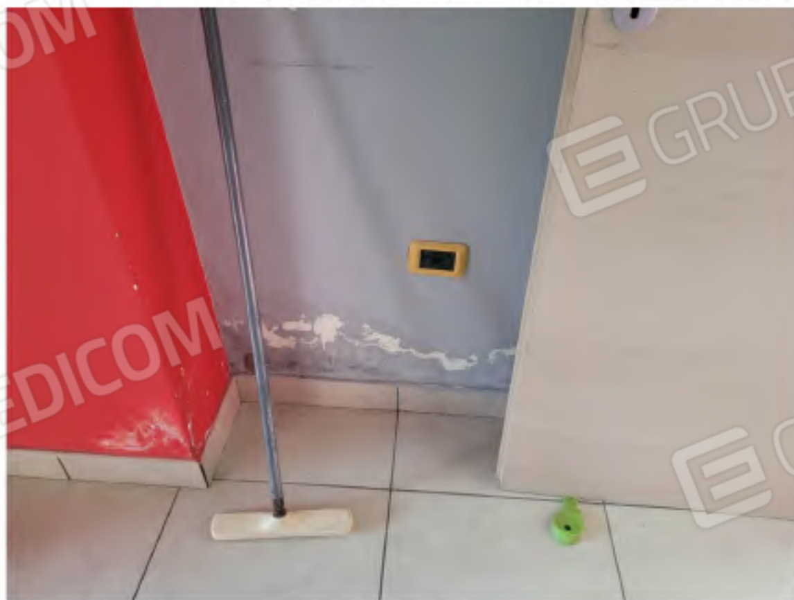
Foto nn. 41 e 42. Immobile al secondo piano individuato al Catasto Fabbricati dal subalterno 9 particella 516 foglio 10: balcone vano letto e distacchi della tinteggiatura con macchie sulle pareti
