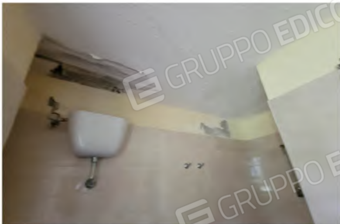
Foto nn. 24bis e 25. Immobile al primo piano individuato al Catasto Fabbricati dal subalterno 7 particella 516 foglio 10: bagno (con macchie e distacchi della tinteggiatura su pareti e soffitto) e corridoio
