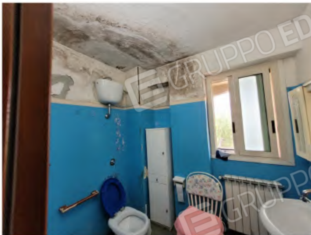
Foto nn. 34 e 35. Immobile al primo piano individuato al Catasto Fabbricati dal subalterno 8 particella 516 foglio 10: bagno (con macchie di umidità e distacchi della tinteggiatura su pareti e soffitto) e balcone del vano letto (con caldaia)
