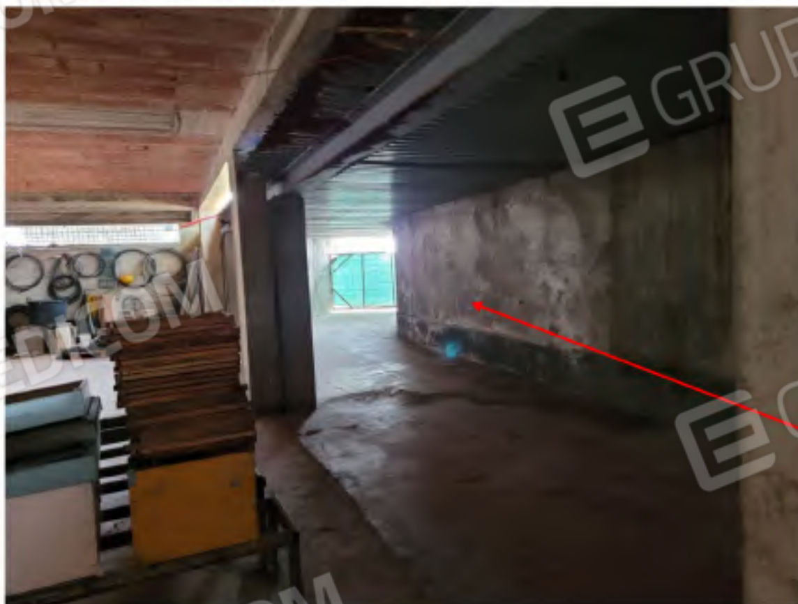
Foto nn. 56 e 57. Edificio individuato al Catasto Fabbricati dalla particella 516 foglio 10: piano seminterrato allo stato rustico (nella foto n. 57 a destra evidenziata dalla freccia rossa la struttura in cemento armato autonoma rispetto all'edificio principale realizzata in adiacenza mediante interposizione di giunto tecnico)
