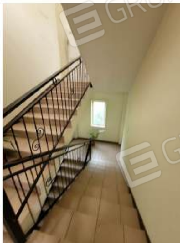
Foto nn. 50, 51 e 52. Edificio individuato al Catasto Fabbricati dalla particella 516 foglio 10: vano scala comune con macchie di umidità e rigonfiamenti della tinteggiatura sulle pareti esterne
