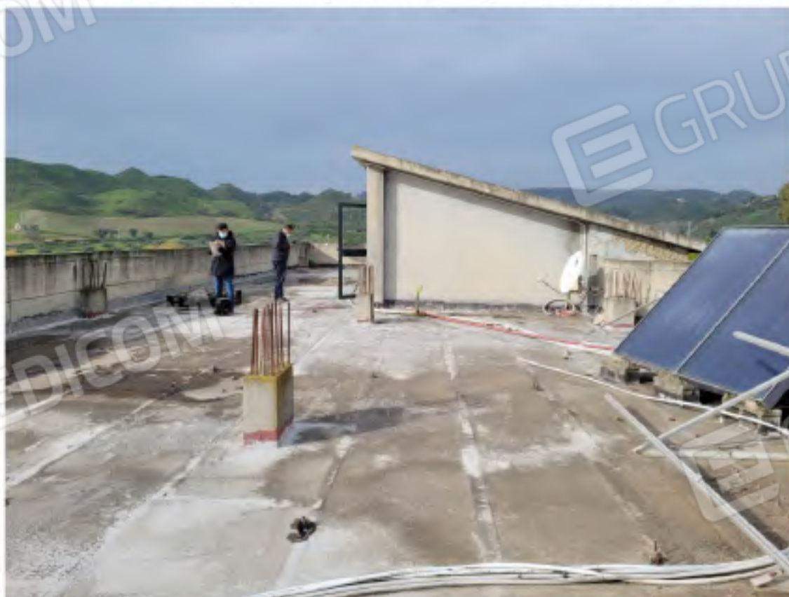
Foto n. 54 e 55. Edificio individuato al Catasto Fabbricati dalla particella 516 foglio 10: lastrico-solare di copertura con ristagni d'acqua sulla guaina impermeabilizzante del piano di calpestio, ferri per la ripresa del getto dei pilastri e pannelli dell'impianto solare termico
