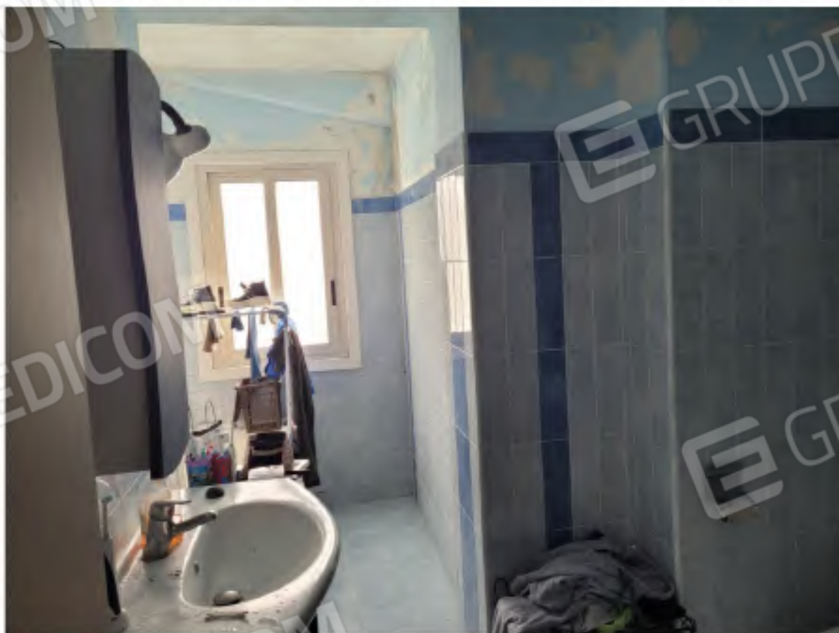
Foto nn. 39 e 40. Immobile al secondo piano individuato al Catasto Fabbricati dal subalterno 9 particella 516 foglio 10: vano letto e bagno (con distacchi e macchie sulla tinteggiatura delle pareti)
