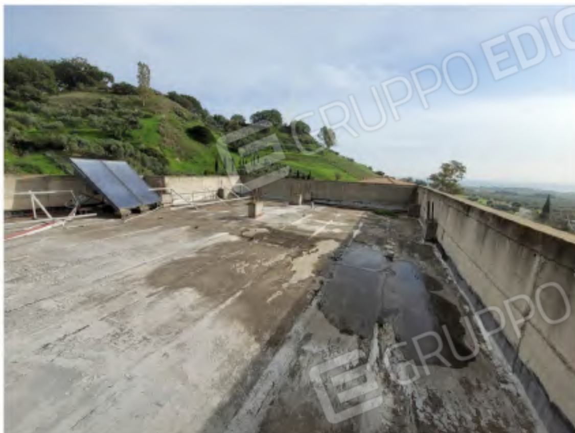
Foto n. 54 e 55. Edificio individuato al Catasto Fabbricati dalla particella 516 foglio 10: lastrico-solare di copertura con ristagni d'acqua sulla guaina impermeabilizzante del piano di calpestio, ferri per la ripresa del getto dei pilastri e pannelli dell'impianto solare termico
