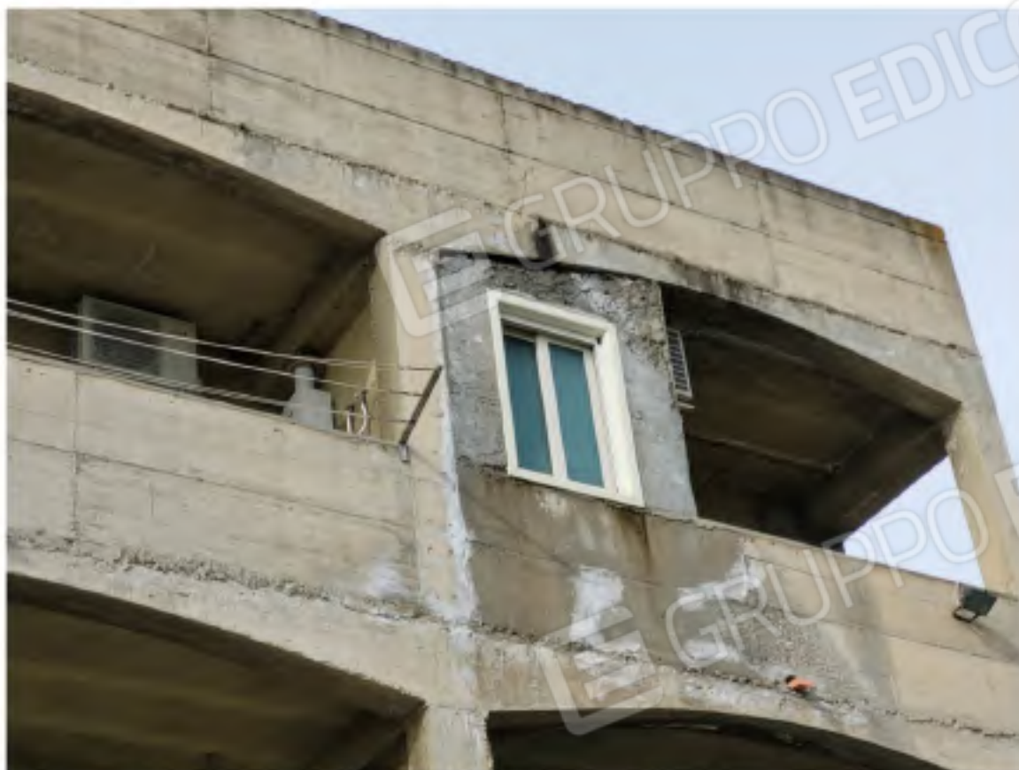
Foto nn. 35bis e 36. Immobile al secondo piano individuato al Catasto Fabbricati dal subalterno 9 particella 516 foglio 10: ampliamento del bagno sul balcone e ingresso (con citofono e quadro elettrico)
