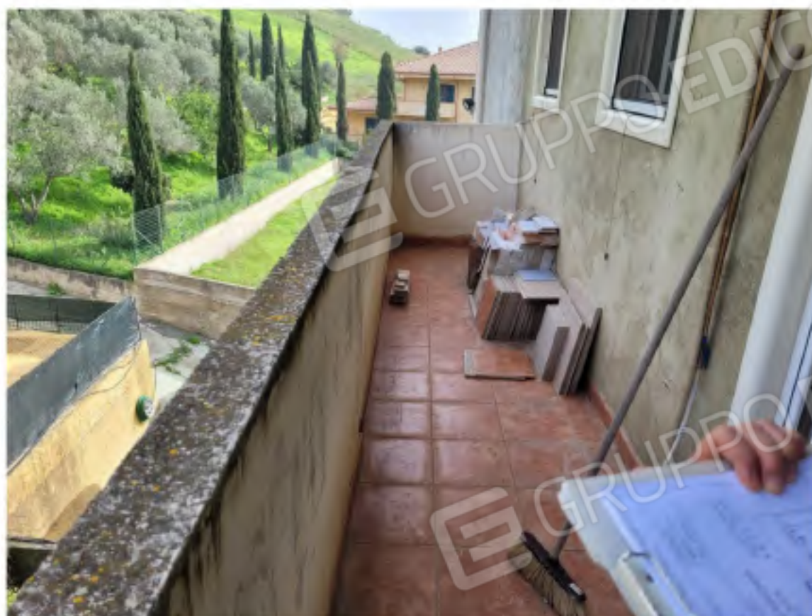
Foto nn. 41 e 42. Immobile al secondo piano individuato al Catasto Fabbricati dal subalterno 9 particella 516 foglio 10: balcone vano letto e distacchi della tinteggiatura con macchie sulle pareti
