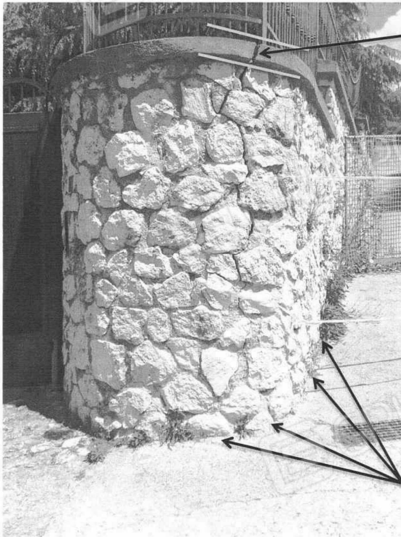
Foto 3 - Particolare della cinta muraria, del lato posto a confine della strada carrabile di Lottizzazione, dalla quale si evidenzia una lesione strutturale, causata non certamente da un cedimento di una parte della fondazione e/o della strada di Lottizzazione, in quanto sia alla base che alla testa del muro, non si evidenzia alcun abbassamento, tanto è che la soletta di coronamento in cls dello stesso muro, nel punto di lesione, non presenta una diversa posizione tra i due piani derivati dalla lesione della stessa soletta, il che implica che non ci sia al momento alcun cedimento/abbassamento di una parte della fondazione e/o della strada di Lottizzazione, ma bensì un accentuato principio di inclinazione/ribaltamento di questo tratto di muro, verso la strada carrabile di Lottizzazione.
