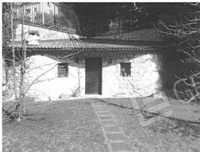
Foto 1 -Prospetto esterno della Legnaia realizzata ad un angolo della Corte a quota del Piano Terra della Villa.
