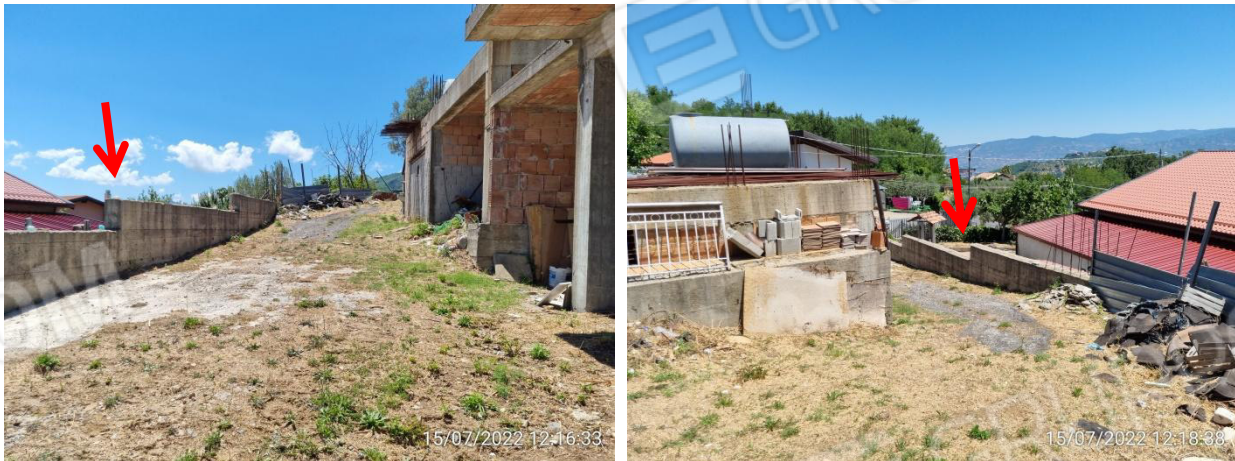
Foto 4.2_2 e 3 – Muro di sostegno in c.a
