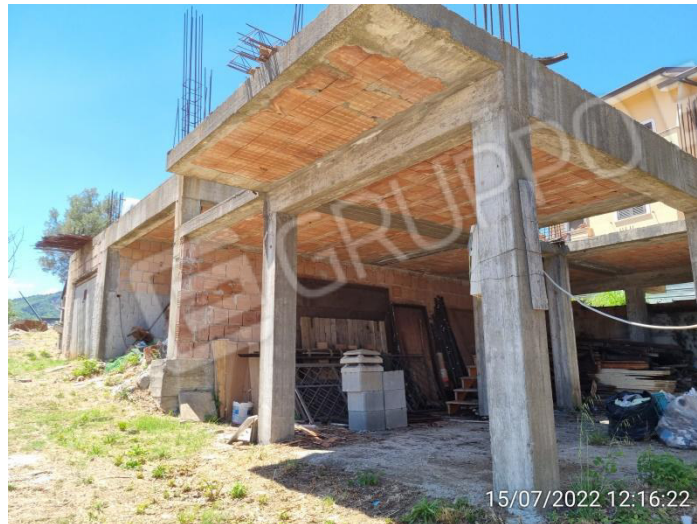
Foto 4.2_1 – Struttura in c.a.
