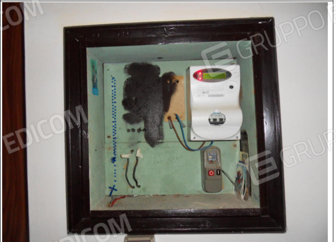
FOTO N. 10: Interni Bene Immobile
