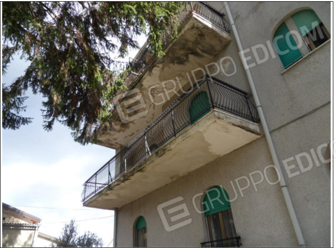
FOTO N. 3: Prospetto OVEST (Balcone Bene Immobile)
