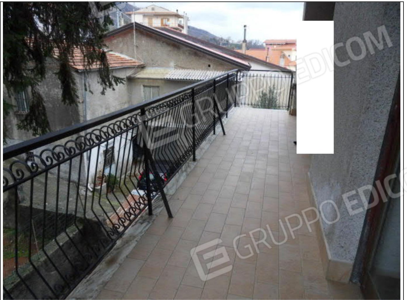
FOTO N. 41: Esterni (balcone) Bene Immobile
