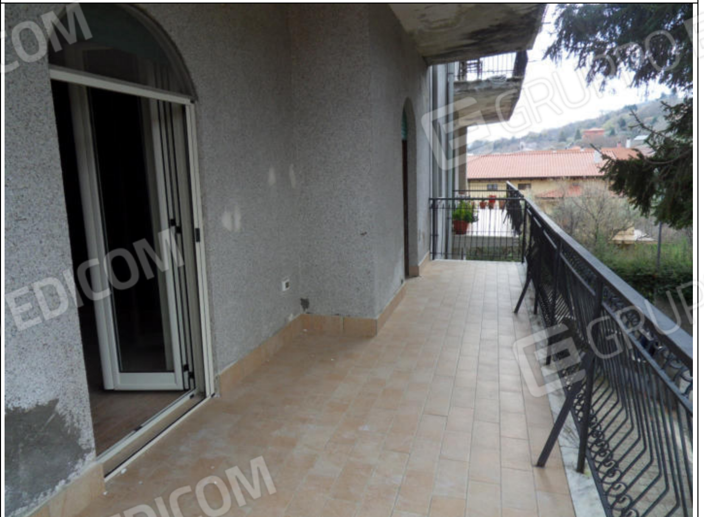
FOTO N. 38: Esterni (balcone) Bene Immobile
