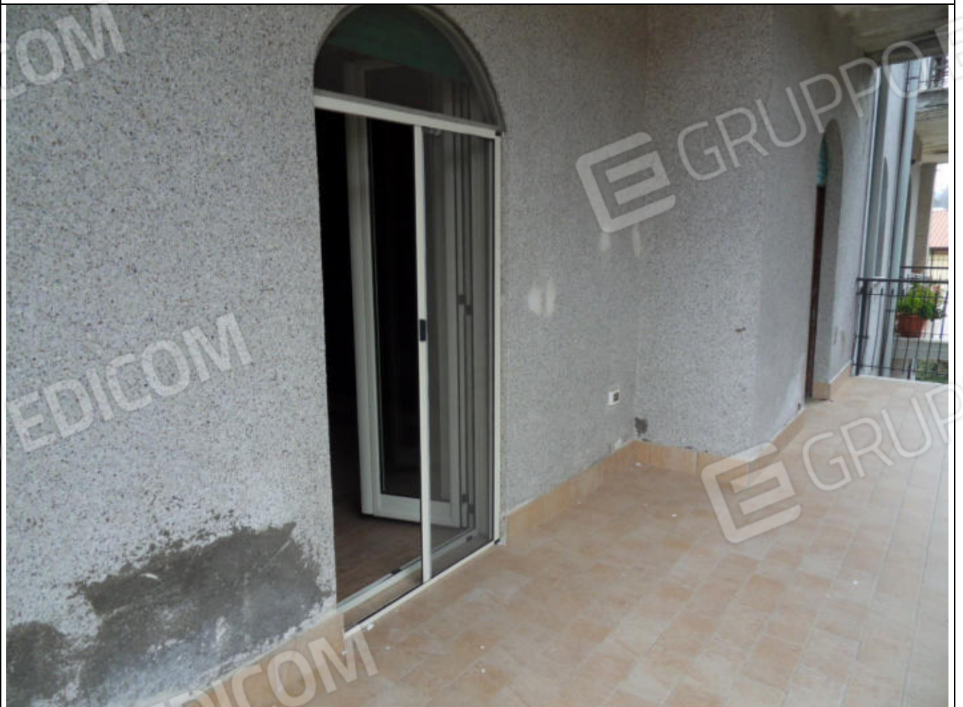
FOTO N. 40: Esterni (balcone) Bene Immobile
