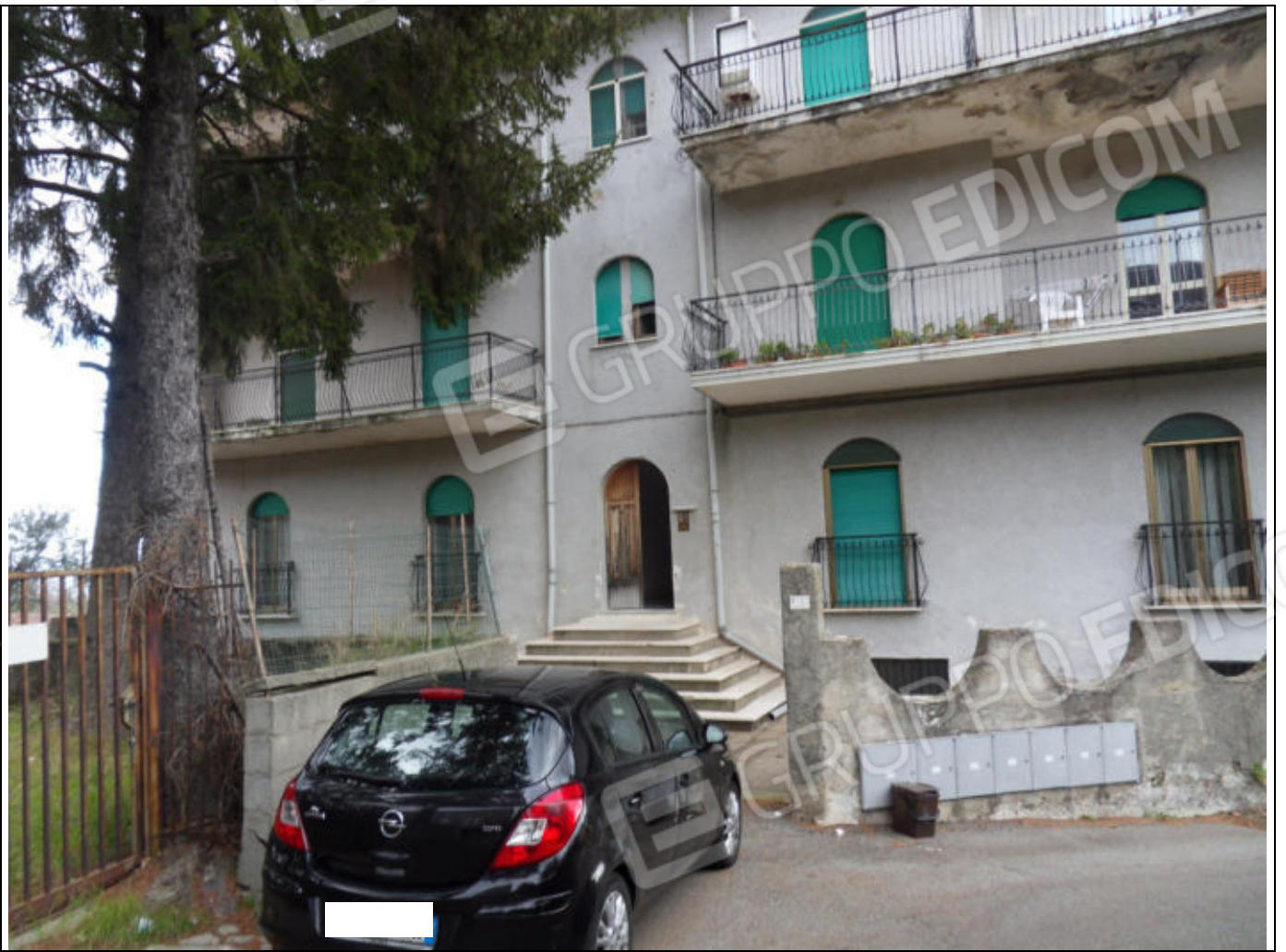
FOTO N. 1: Prospetto OVEST (Ingresso Fabbricato)
