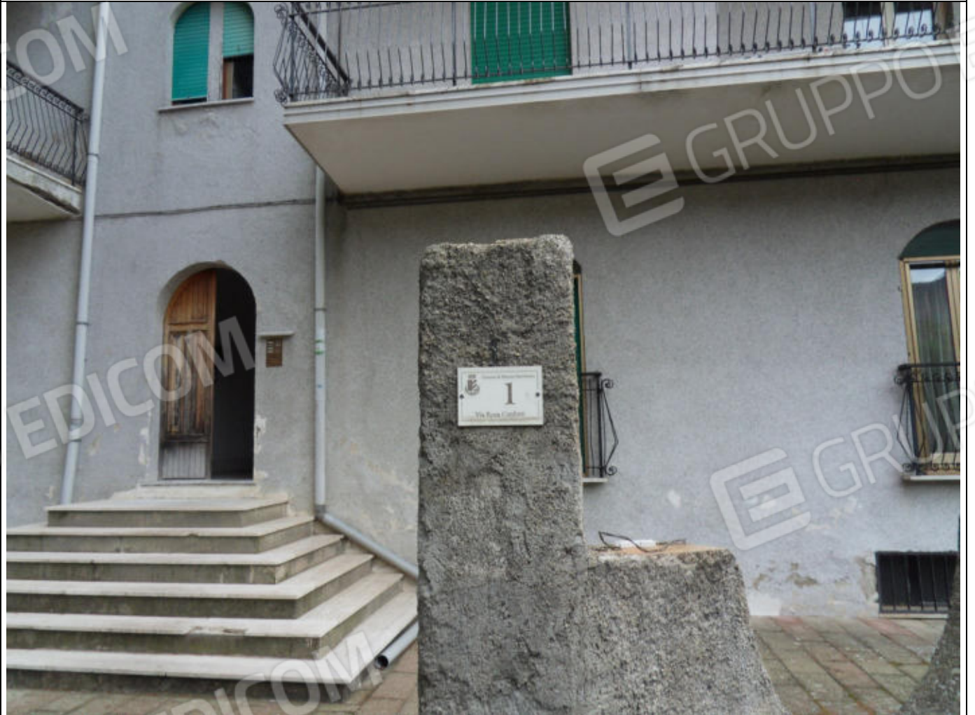
FOTO N. 2: Prospetto OVEST (Ingresso Fabbricato)
