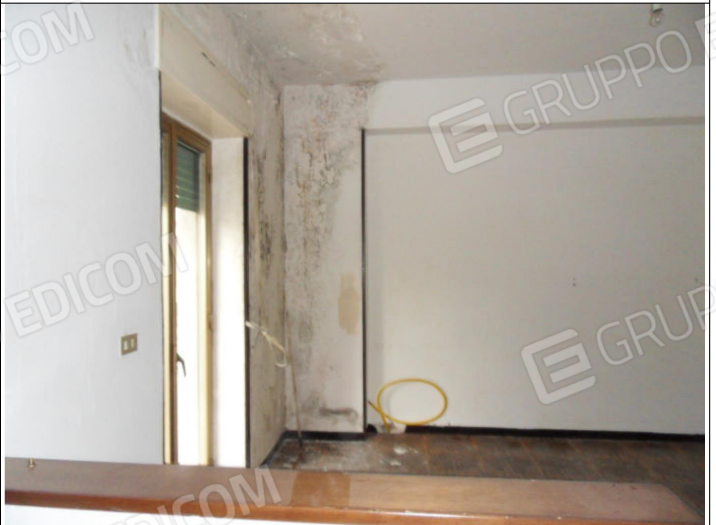
FOTO N. 20: Interni Bene Immobile
