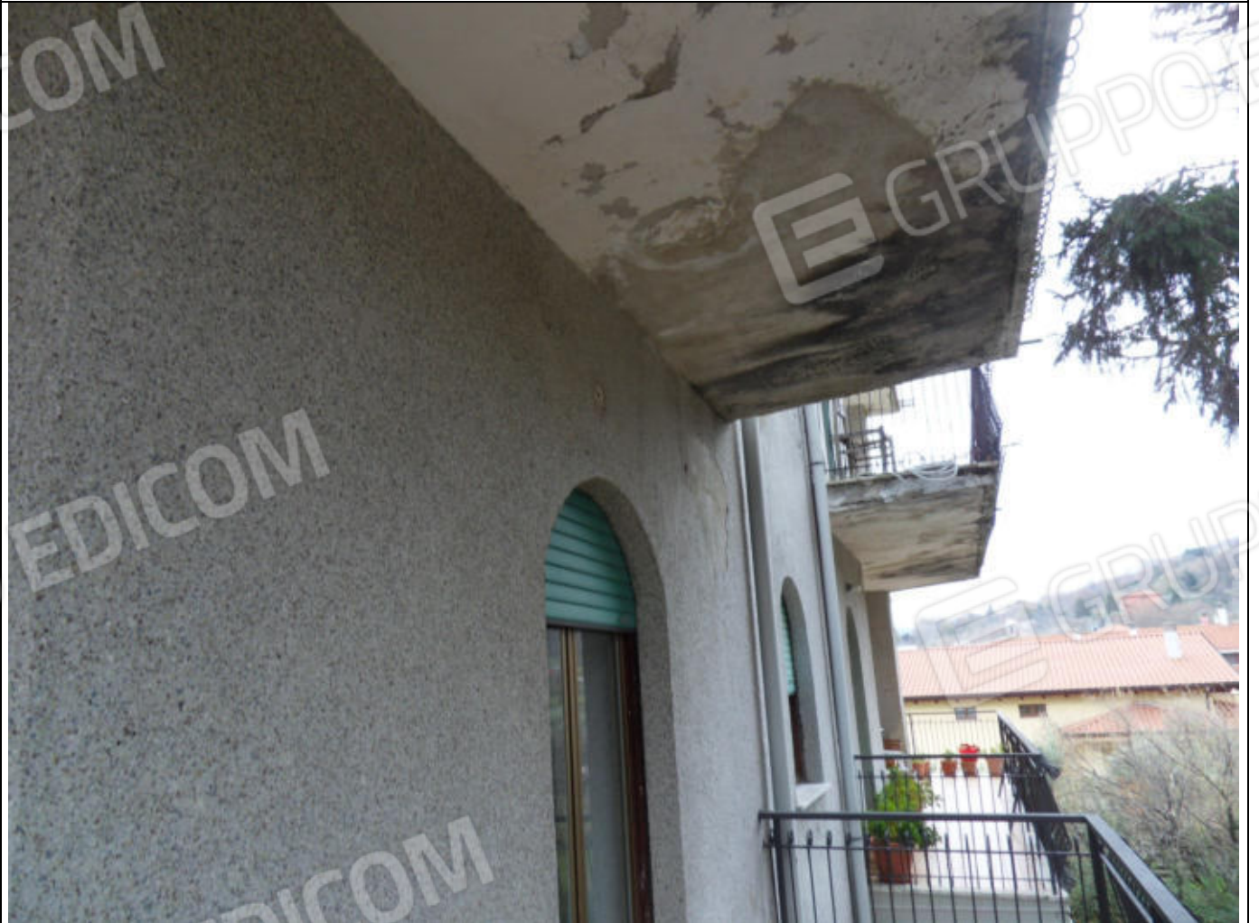
FOTO N. 42: Esterni (balcone) Bene Immobile
