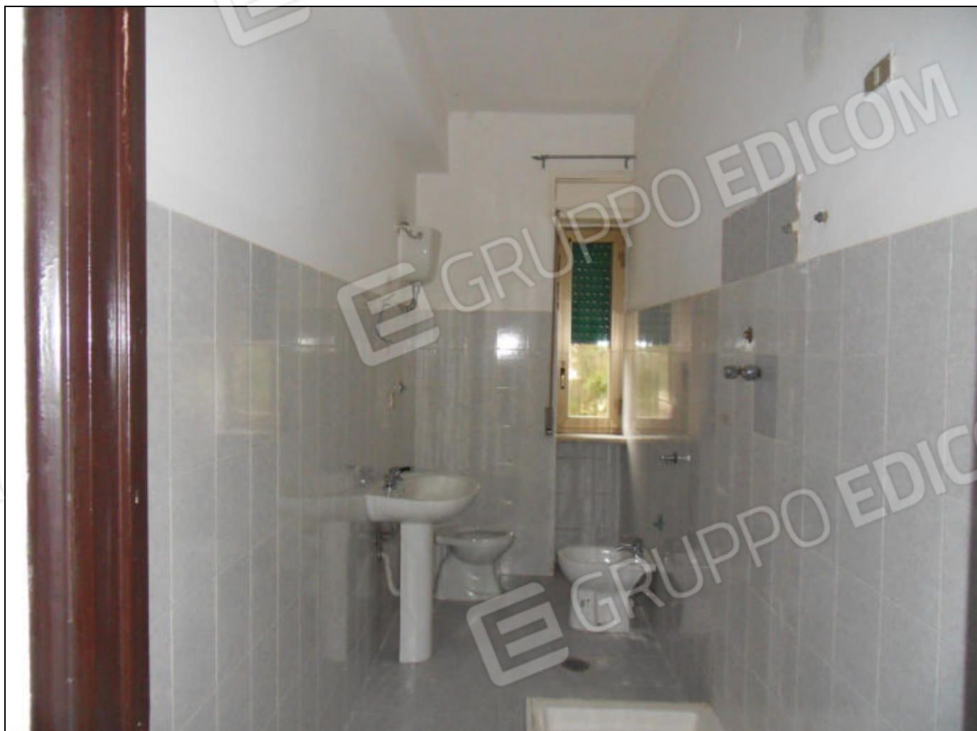
FOTO N. 15: Interni Bene Immobile
