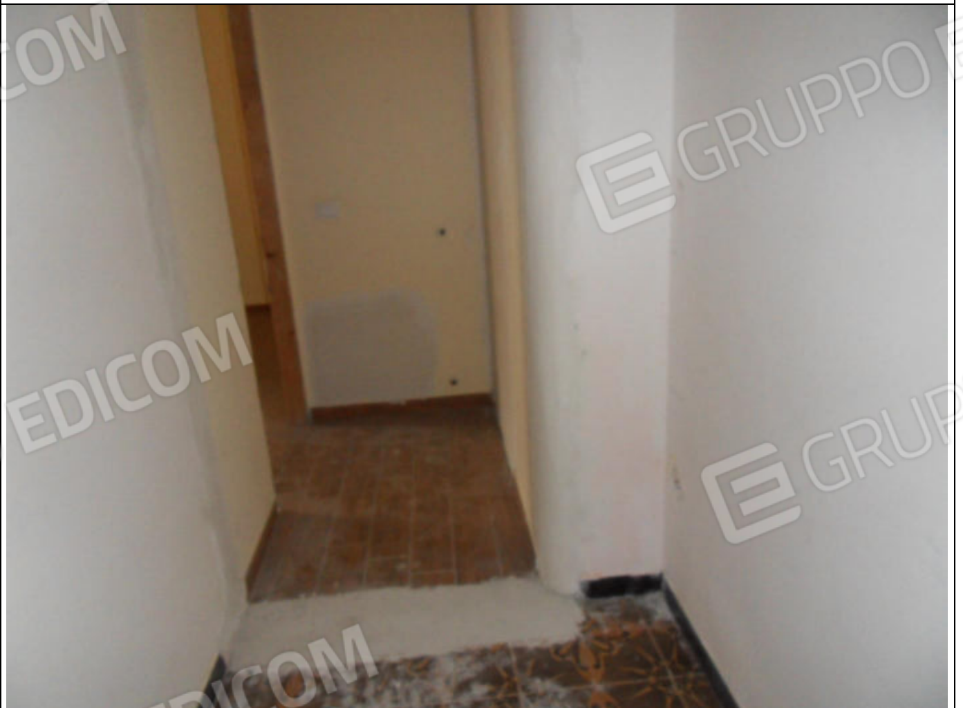
FOTO N. 36: Interni Bene Immobile
