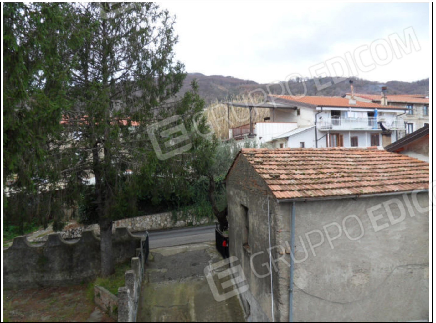
FOTO N. 47: Vista Ovest (da balcone Bene Immobile)
