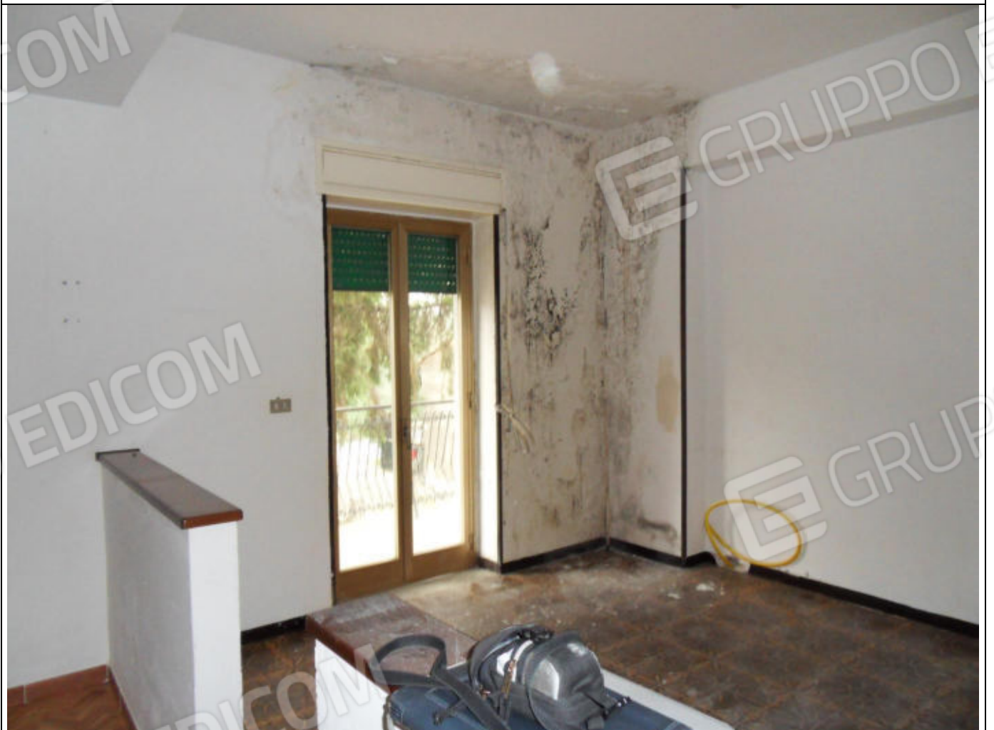
FOTO N. 18: Interni Bene Immobile
