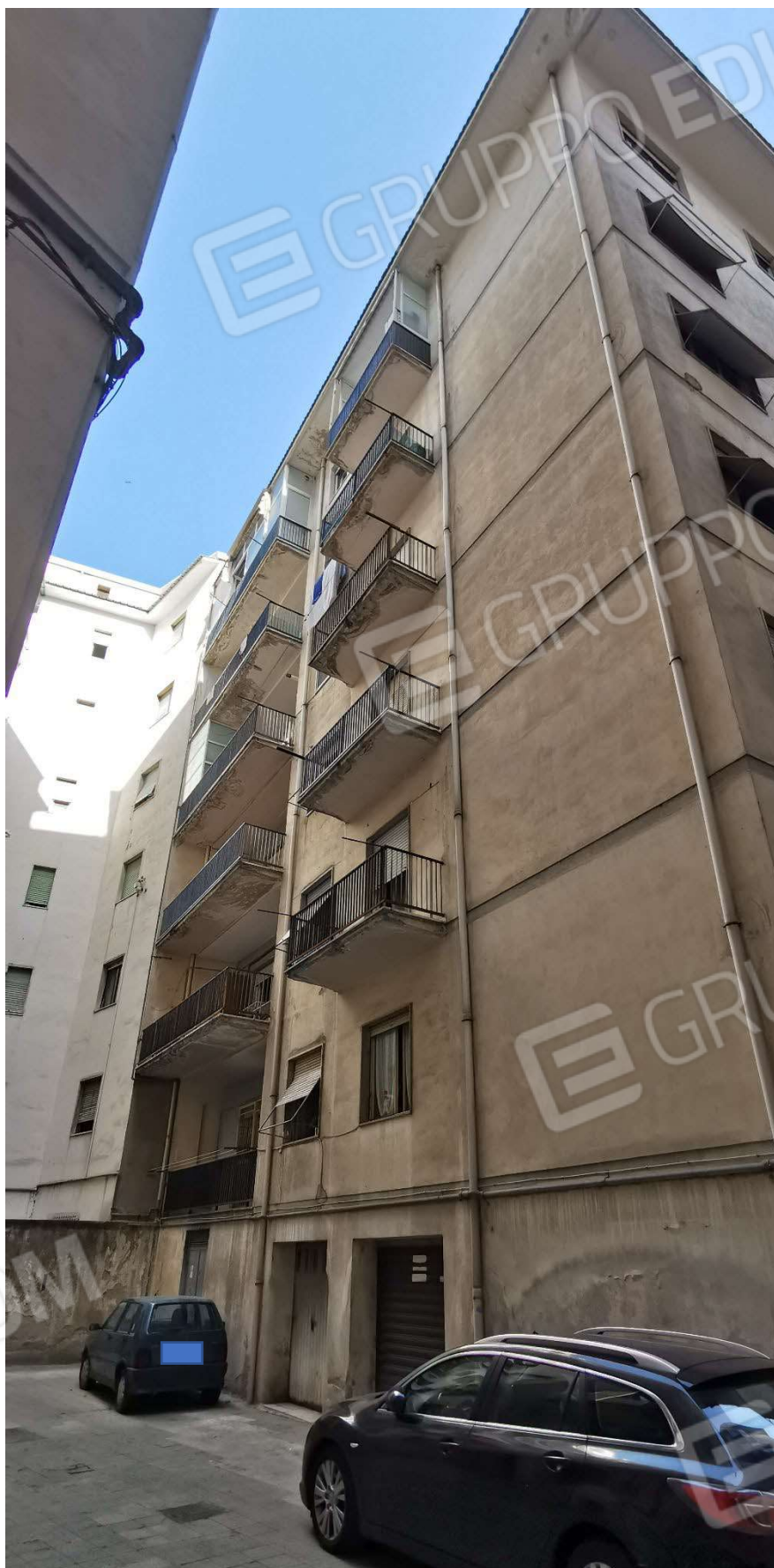
Foto 2: Vista esterna edificio lato sud.
