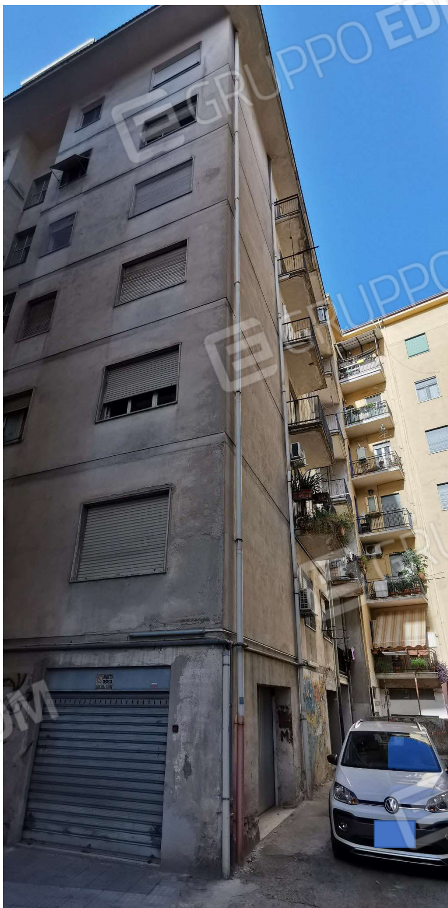
Foto 4: Vista esterna edificio lato sud.
