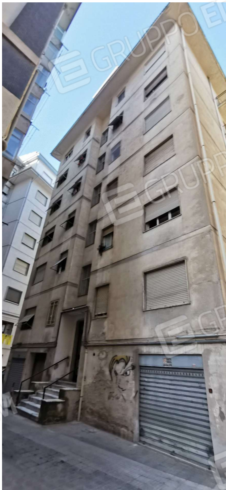
Foto 5: Vista esterna edificio ingresso - lato est.
