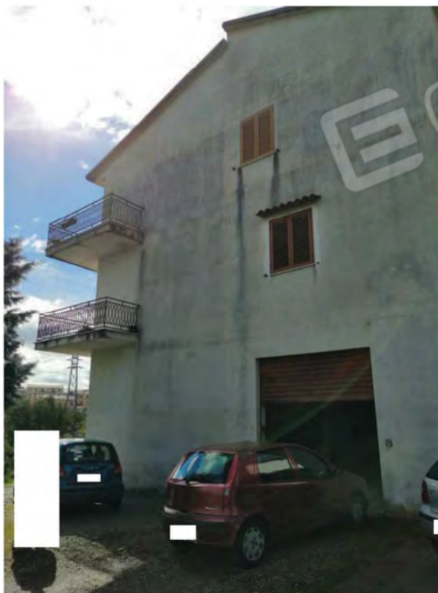
Foto 2 – Esterno lato Nord
