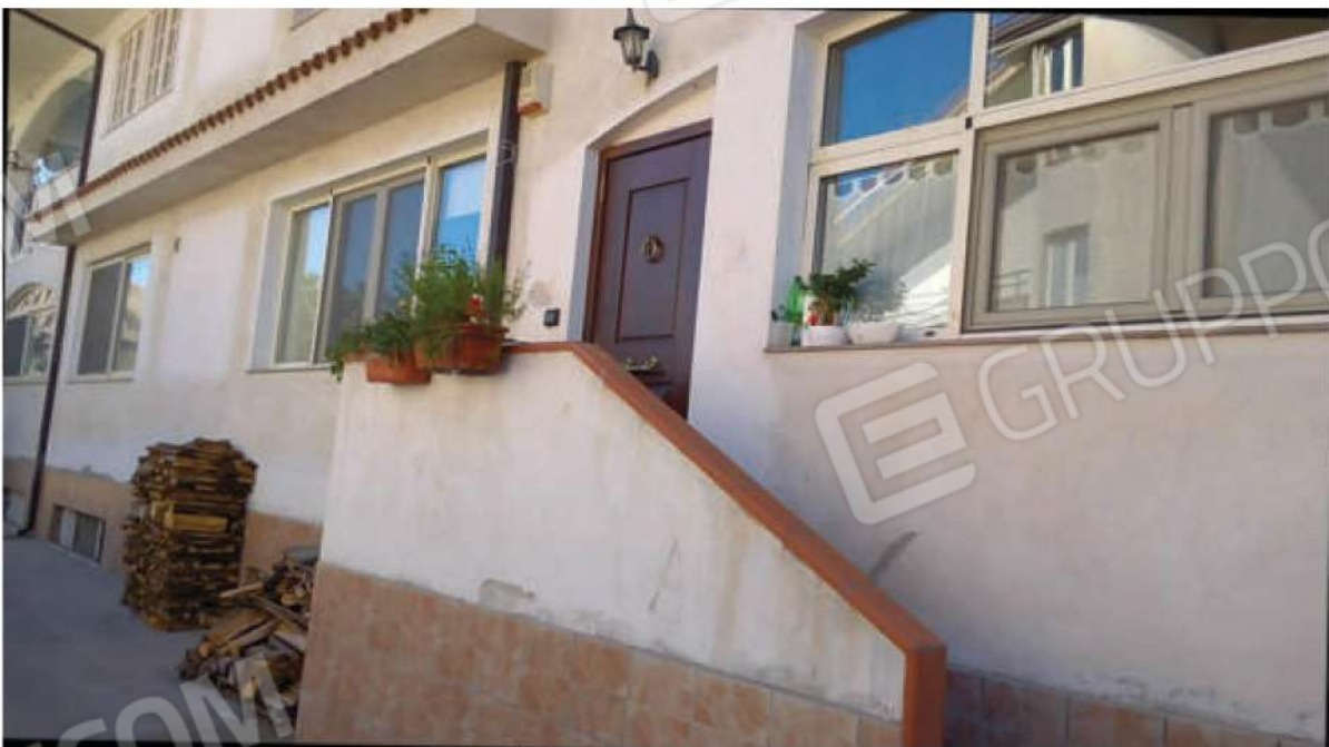
FOTO 17_Ingresso al Sub 9_Vista Nord
