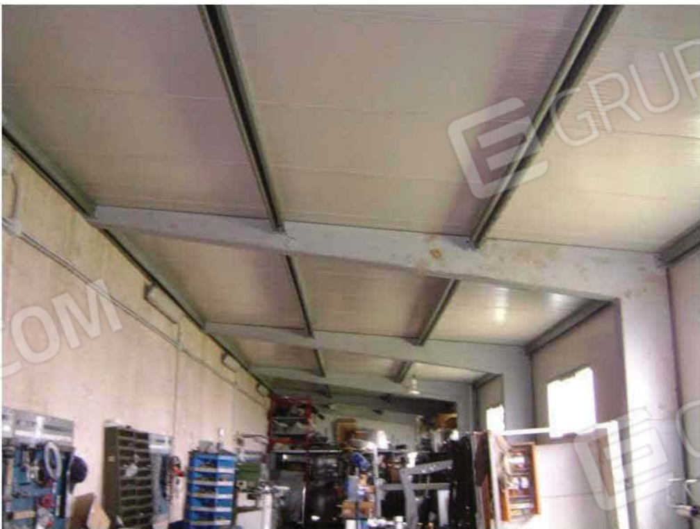
Vista Interna Tettoia
