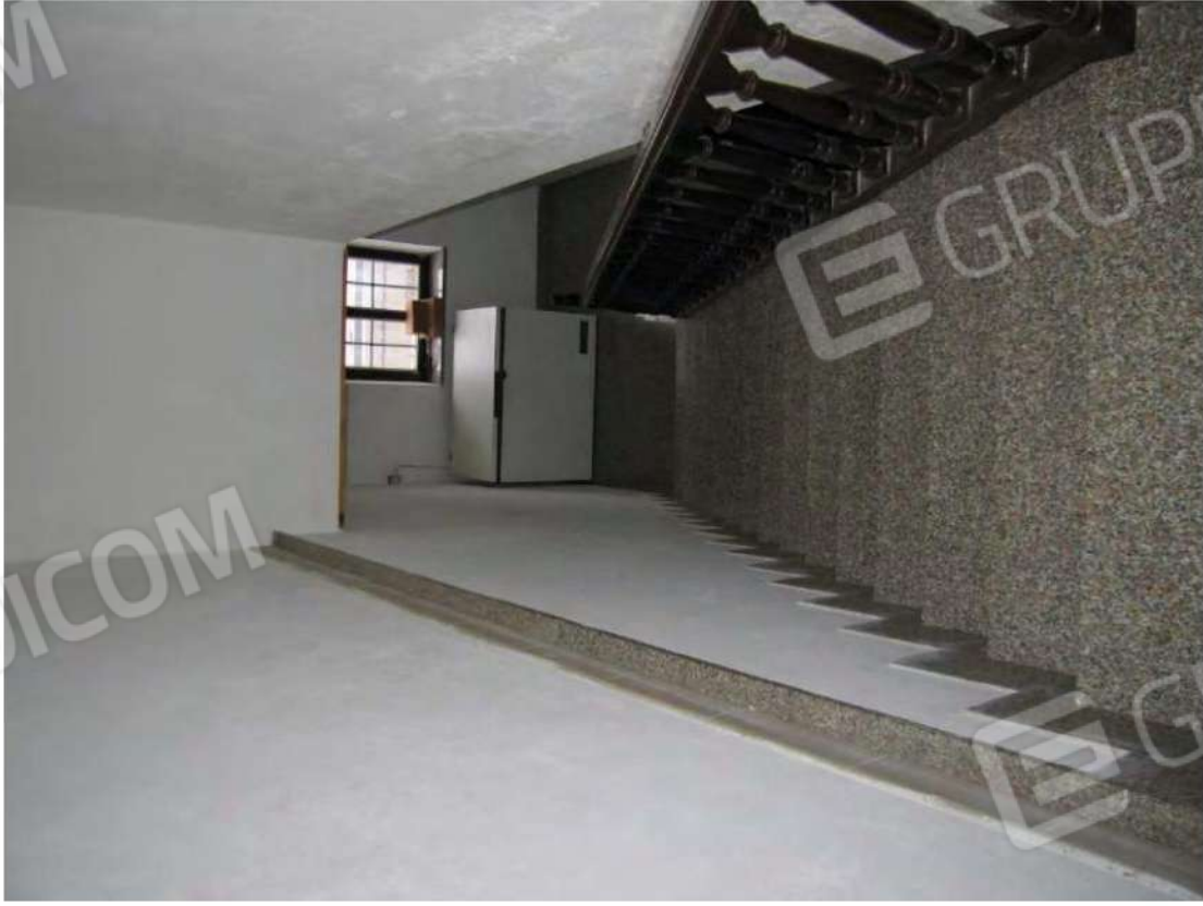
Foto n° 63 e 64 - Vano scala
