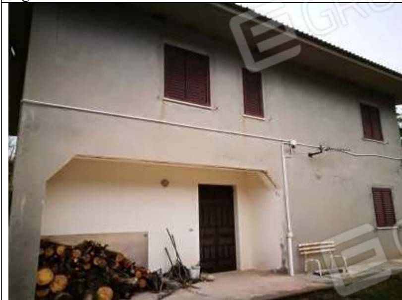
Figura 25 Fabbricato Facciata Nord Est
