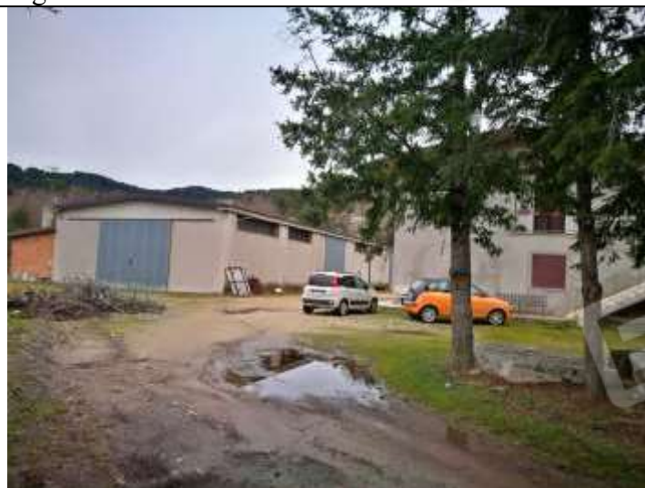
Figura 15 Capannone part 85 sub , 2 e 3
