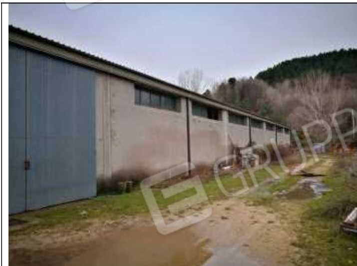
Figura 16 Capannone Industriale sub 3 Lato Nord-Ovest
