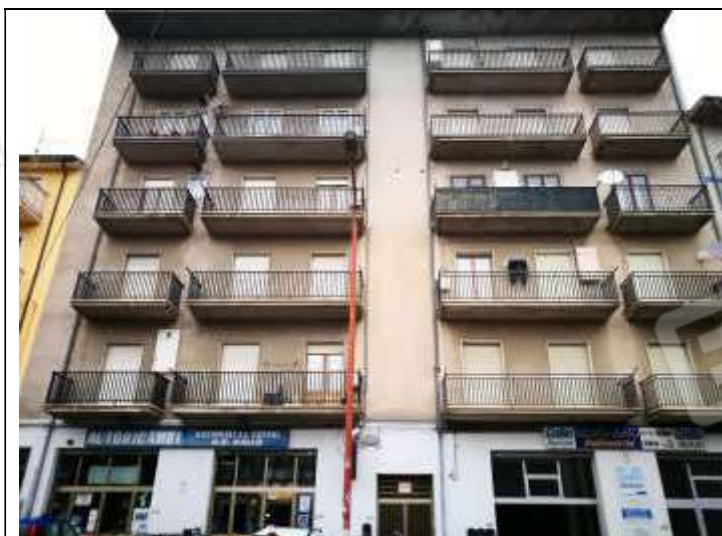
Figura 1 Vista frontale Palazzina Via panoramica 182
