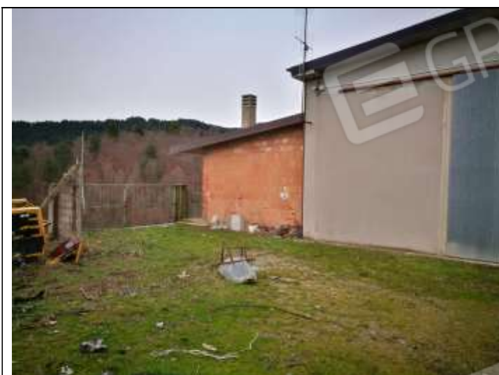
Figura 17 Capannone Industriale sub 3 Lato Sud-Ovest – visibile la costruzione annessa
