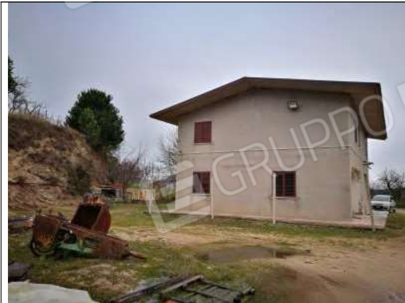
Figura 26 Fabbricato Facciata Sud Ovest
