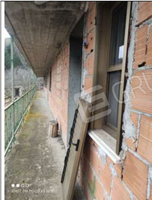
Figura 20 Edificio annesso al Capannone Industriale Lato Sud-Est
