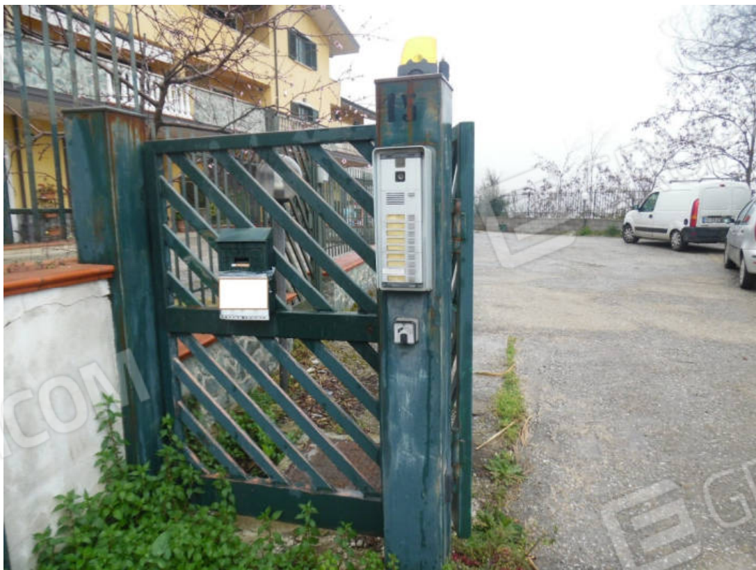
Foto 2: cancello pedonale d'ingresso al fabbricato
