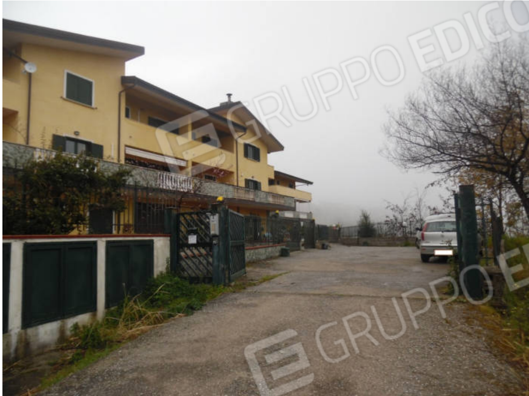
Foto 1: cancello d'ingresso al fabbricato
