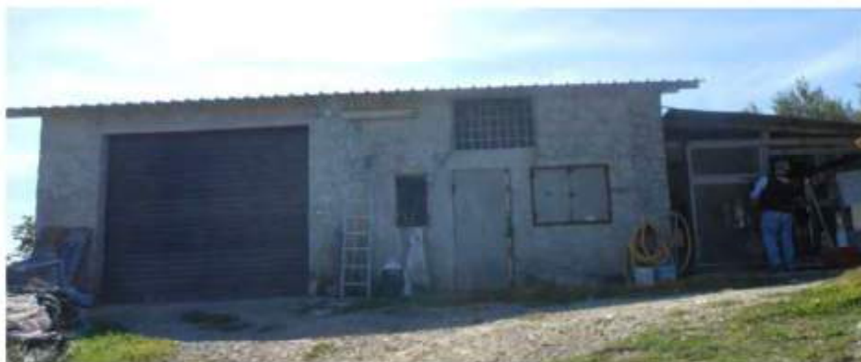
Figura 11: Unità collabente - Foglio 11 particella1398 sub 1.
