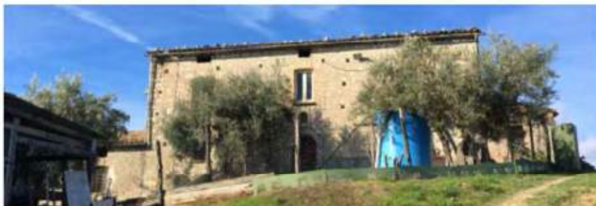
Figura 4: Unità collabente Foglio 11 particella1397 sub 1.
