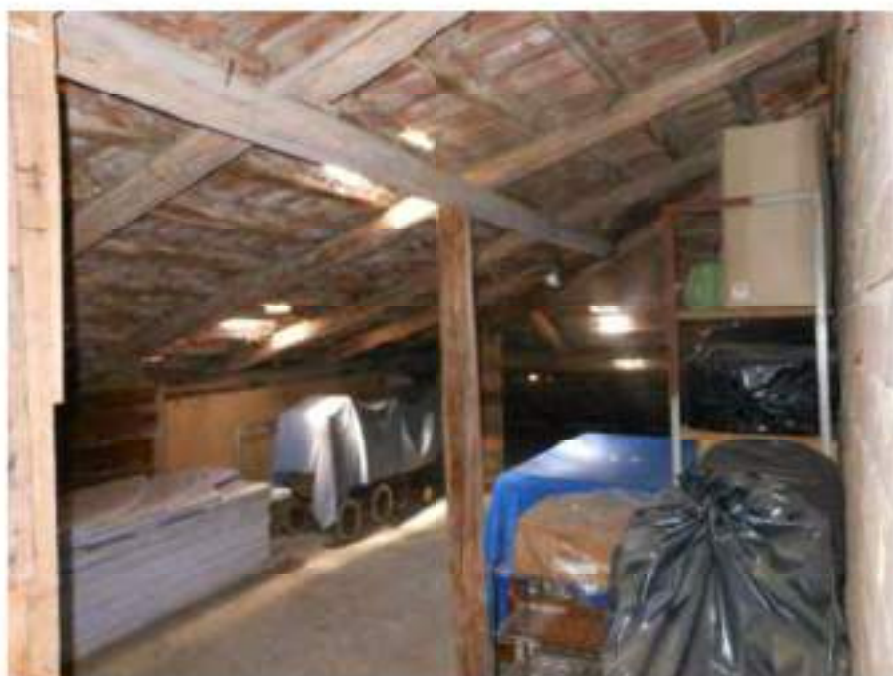
Figura 36: Magazzino f.11 particella 610 sub 4
