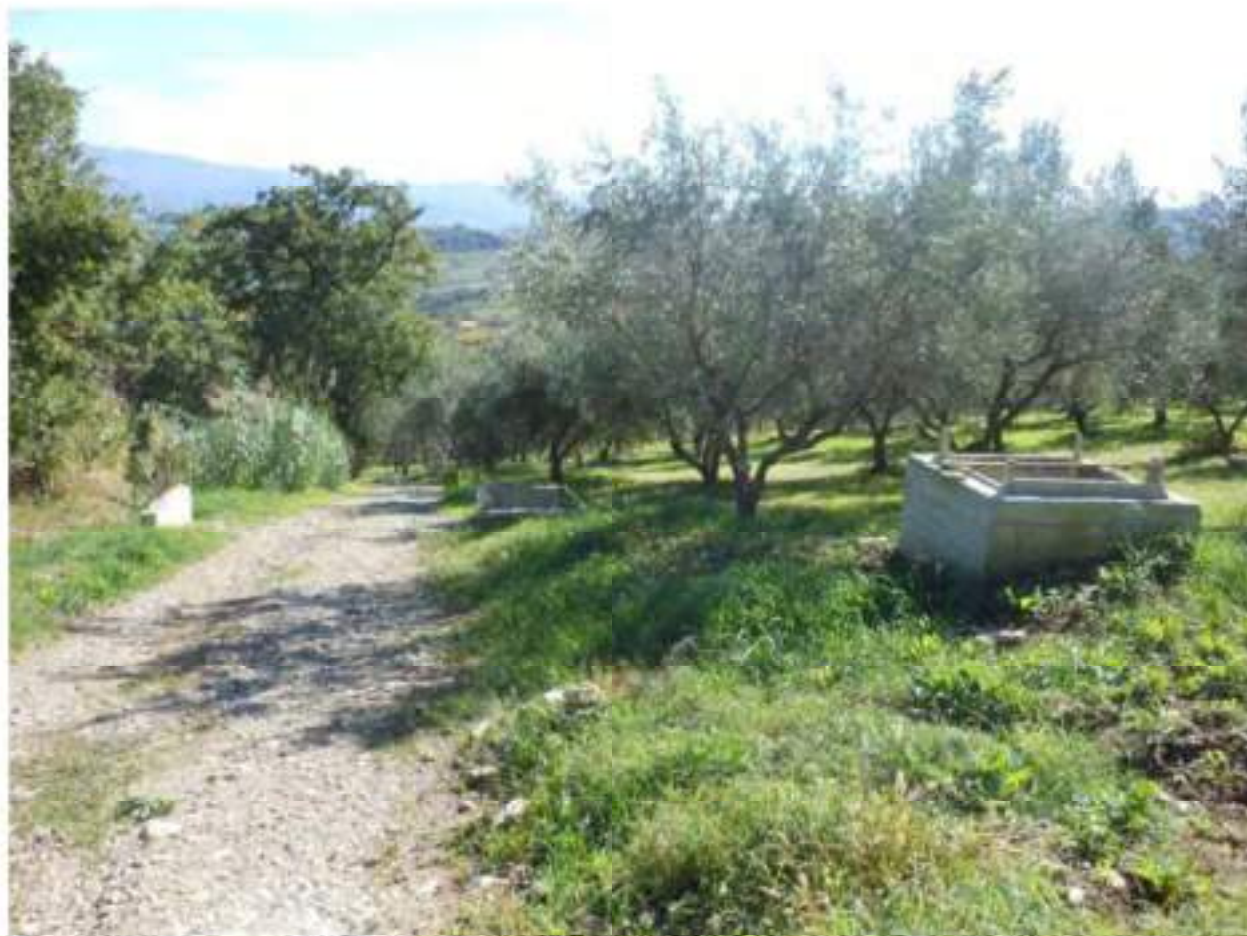
Figura 42: Stradina in terra battuta con sistema di regimentazione delle acque piovane presente lungo il lato nord della particella 848.
