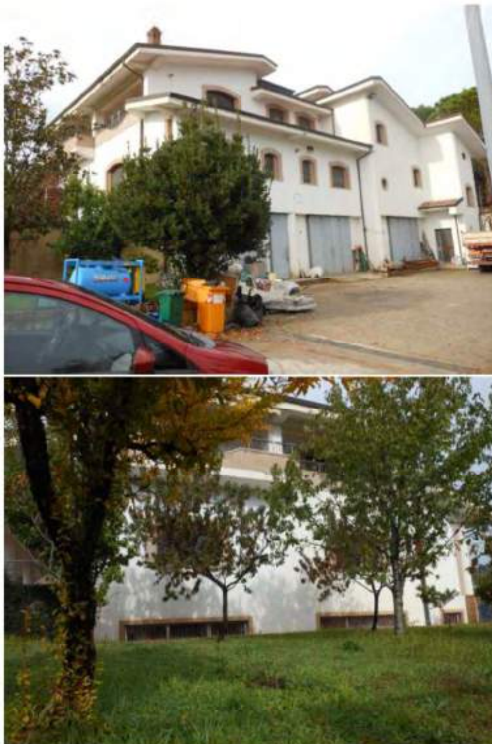
Figura 46: Viste esterne dell'edificio pignorato (foglio 11 particella 1186).
