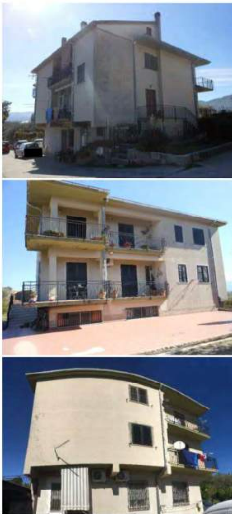
Figura 27: Viste esterne dell'edificio pignorato (foglio 11 particella 610).
