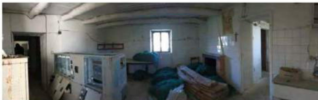
Figura 5: Unità collabente Foglio 11 particella1397 sub 1- Corpo centrale stanza a nord.
