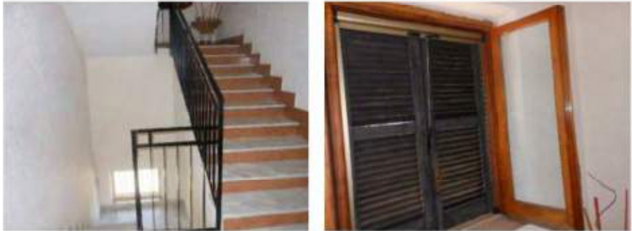
Figura 28: Viste interne della scala comune dell'edificio pignorato (foglio 11 particella 610).
