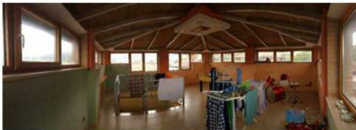
Figura 59: Appartamento f.11 particella 1186 sub 6- piano sottotetto.
