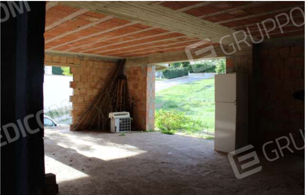
vista stato piano terra
