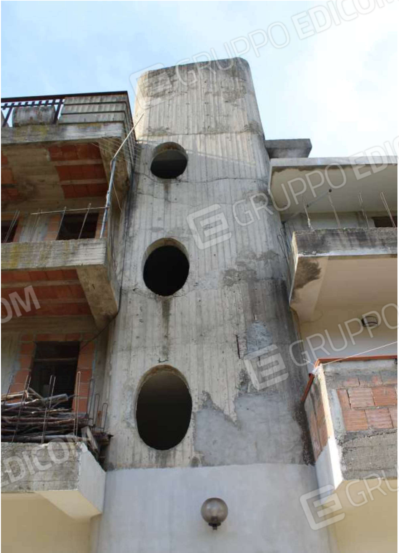
vista corpo scala
