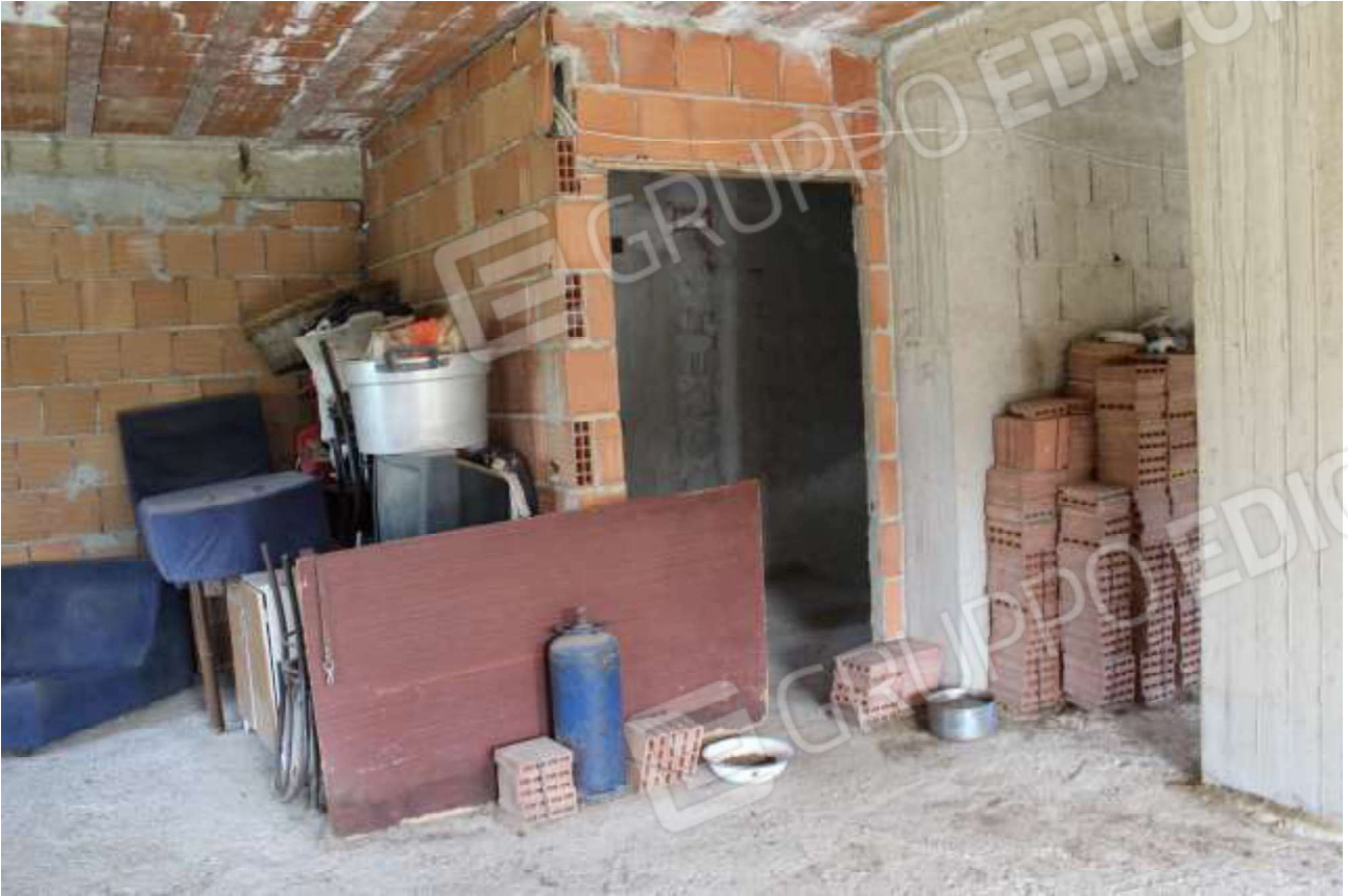
vista stato piano primo
