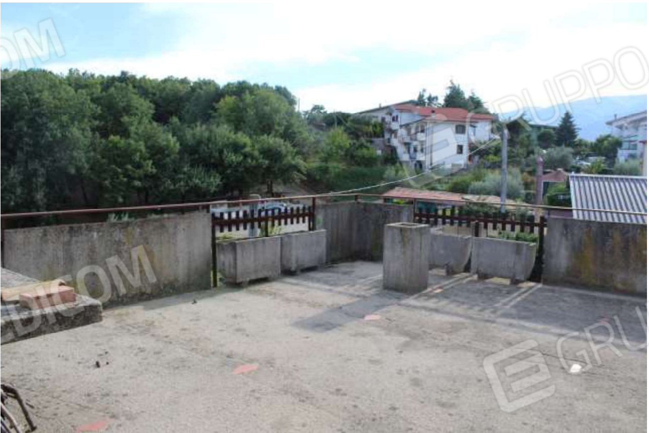
vista terrazzo piano sottotetto
