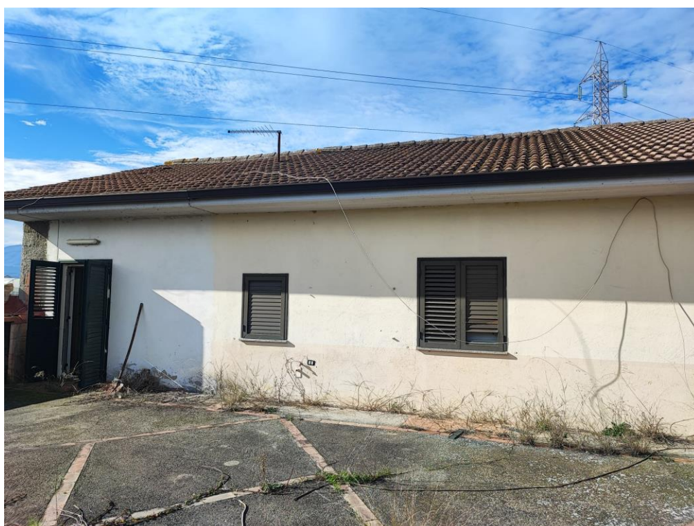
Foto n° 8 Prospetto posteriore e Corte esterna l'edifici
