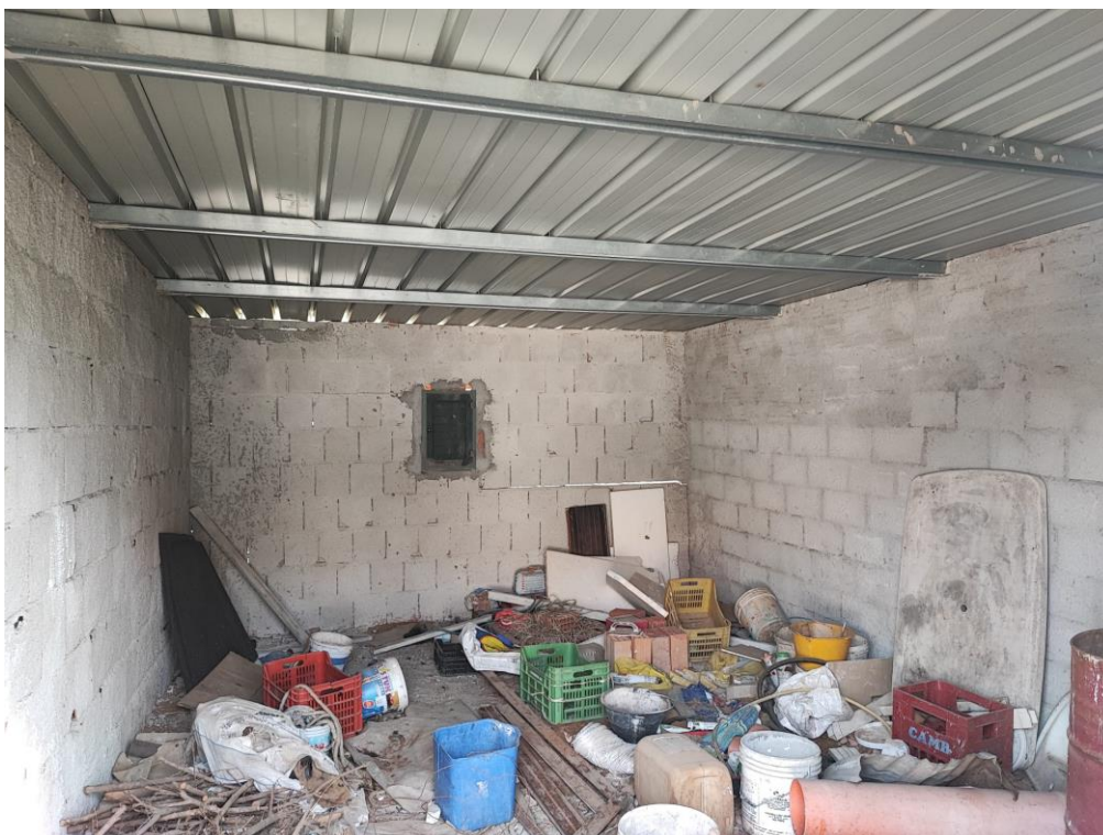
Foto n° 3 Interno magazzino attrezzi
