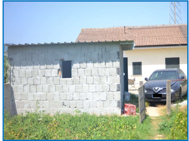
Foto n° 9 Magazzino attrezzi visto dall'esterno
