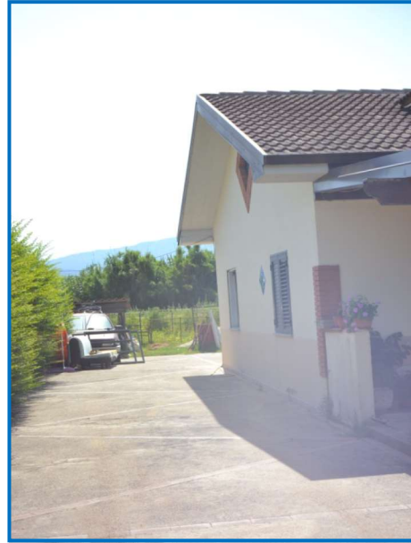
Foto n° 5 Corte cementata fronte laterale
