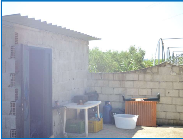
Foto n° 8 Magazzino attrezzi visto dall'esterno
