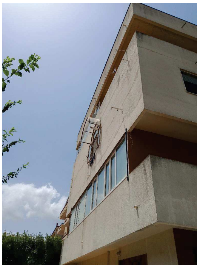
Foto 5. Facciata lato nord interno al cortile dello stabile.
