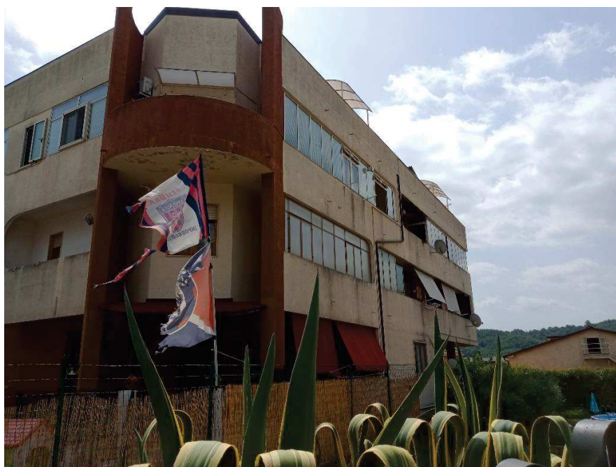
Foto 4. Facciata lato est.
