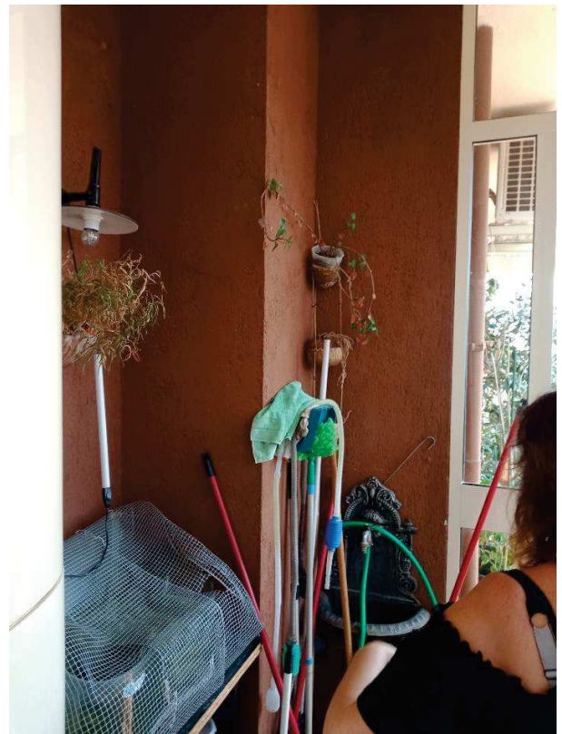
Foto 29. Muro esterno modifico per il box doccia.
