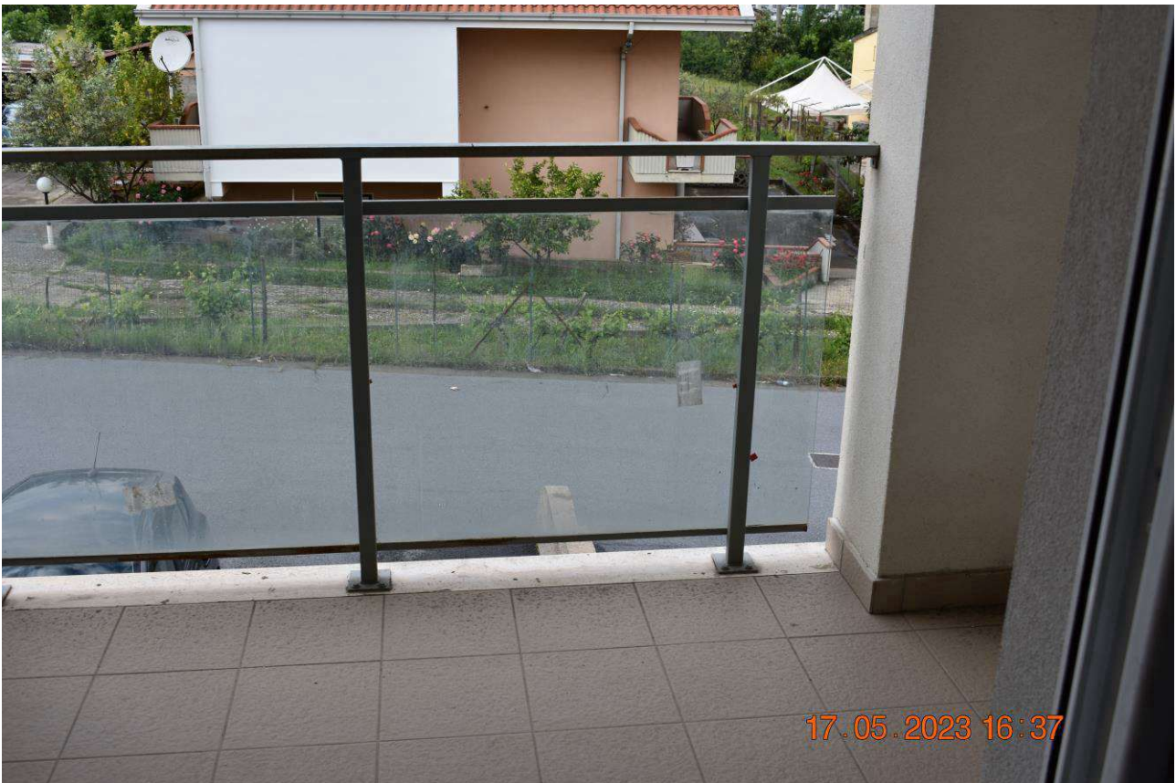
FOTO N.36: Balcone lato nord
