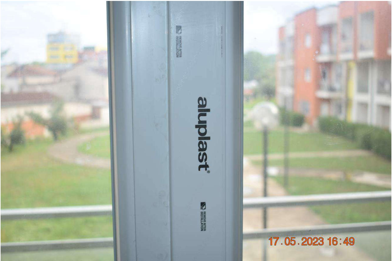
FOTO N.41: Particolare infisso esterno
