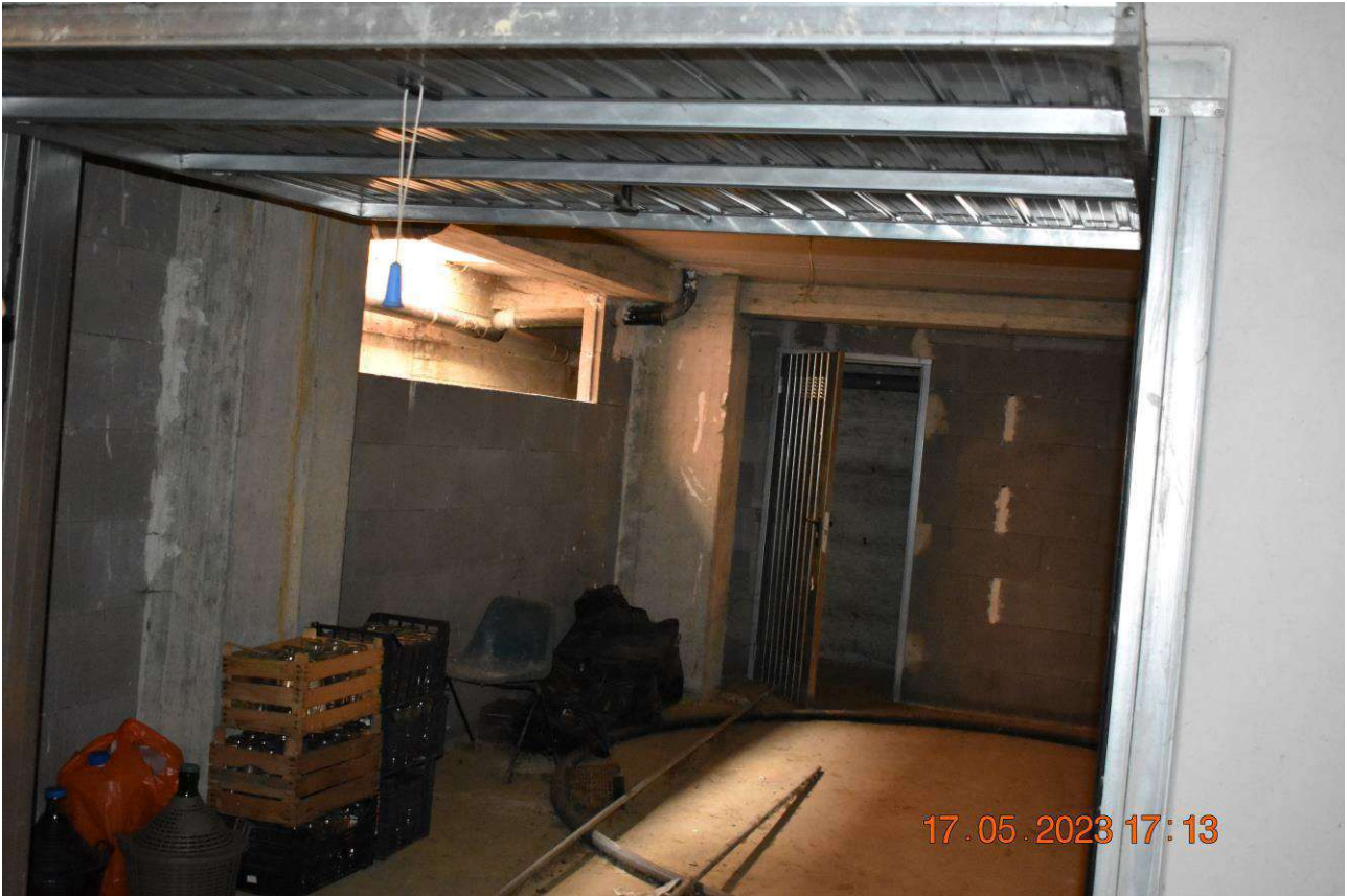
FOTO N.5: Interno box sub 8.
