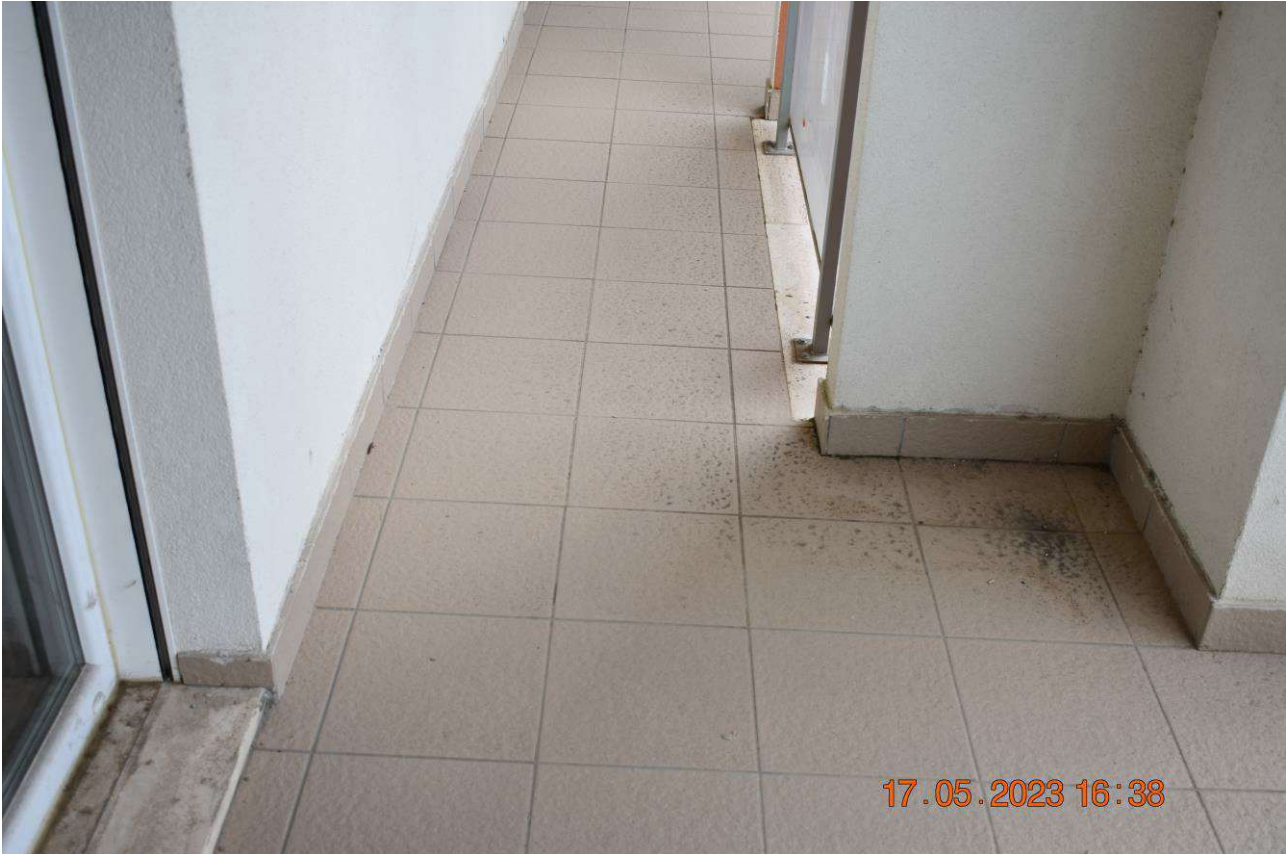
FOTO N.39: Balcone lato nord. Particolare pavimentazione e soglie
