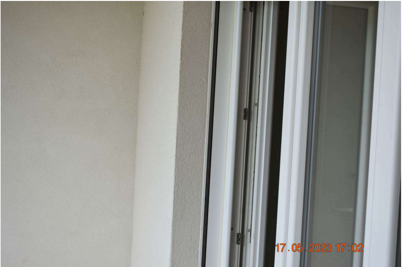
FOTO N.23: Particolare infisso esterno
