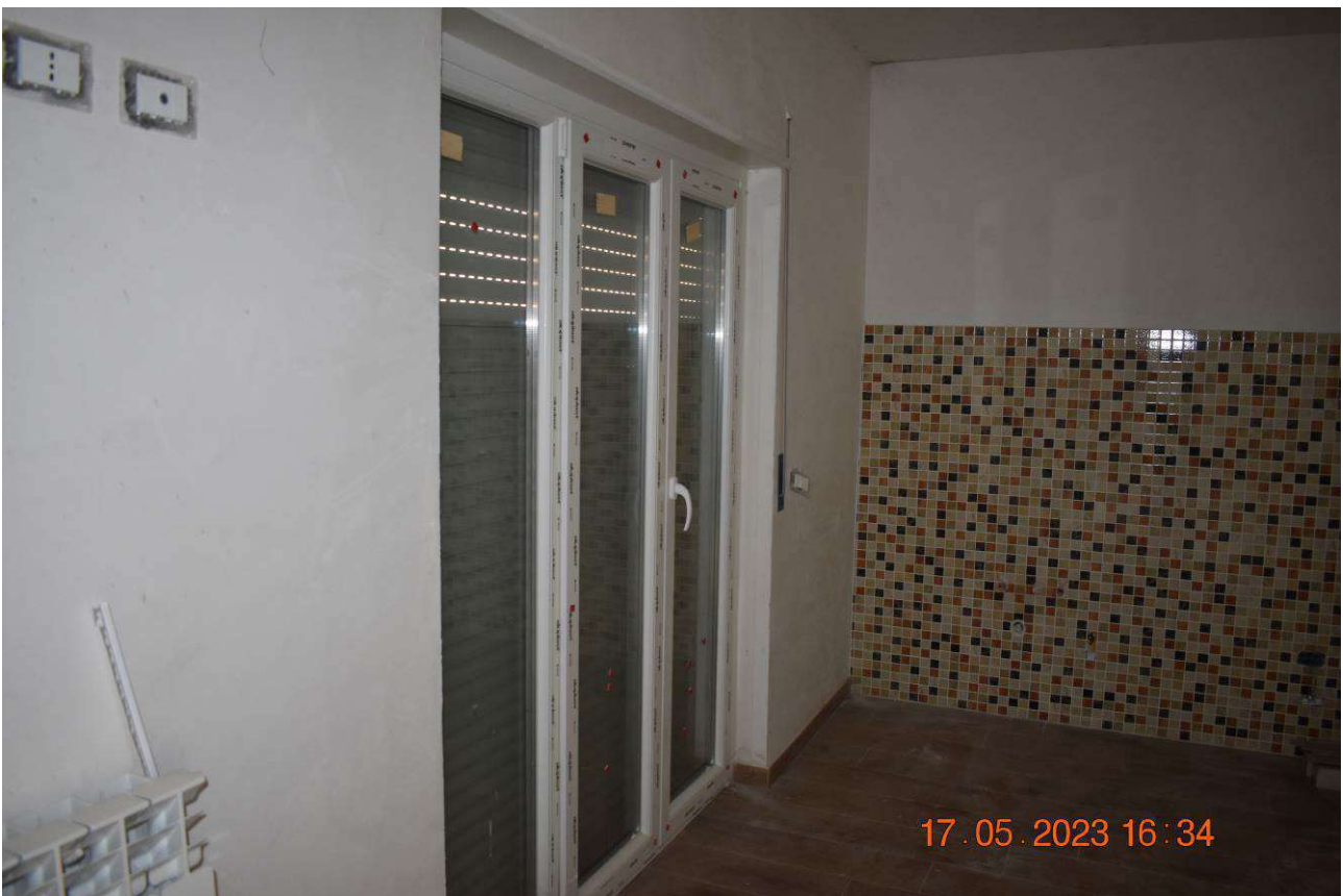
FOTO N.14: Cucina. Si nota il rivestimento maiolicato, gli infissi esterni in PVC ed il termosifone in alluminio.
