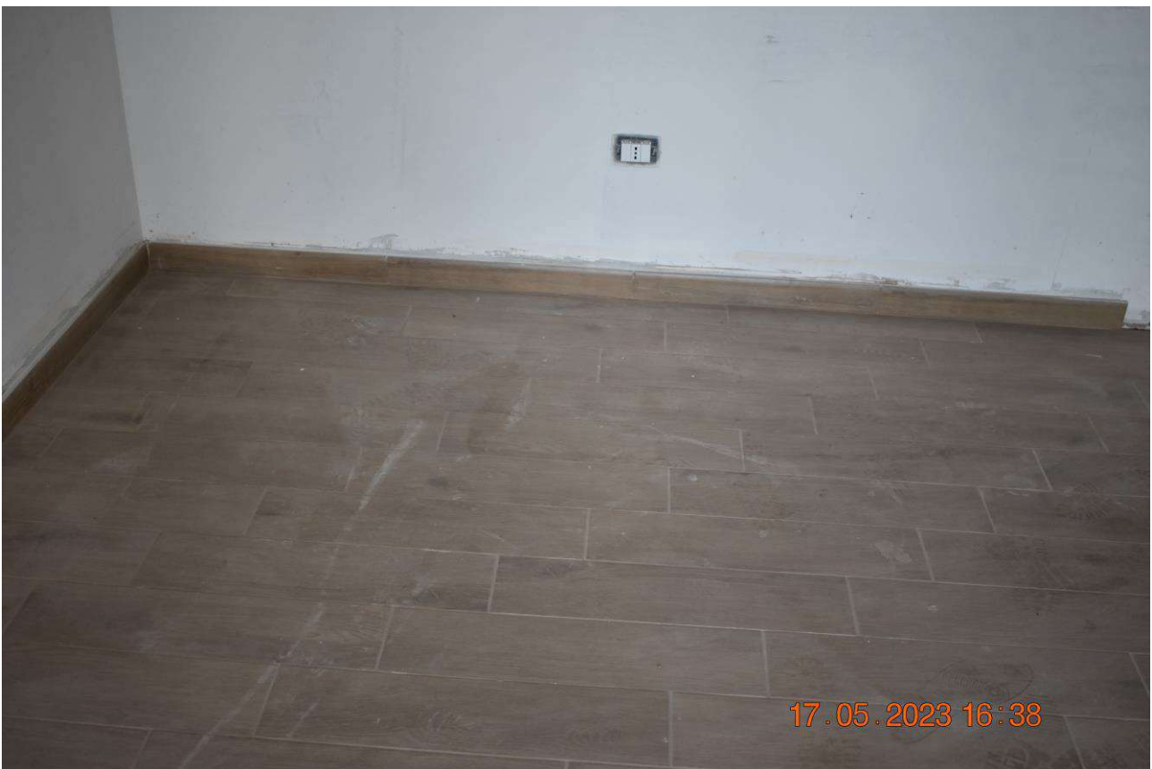
FOTO N.40: Particolare pavimento appartamento
