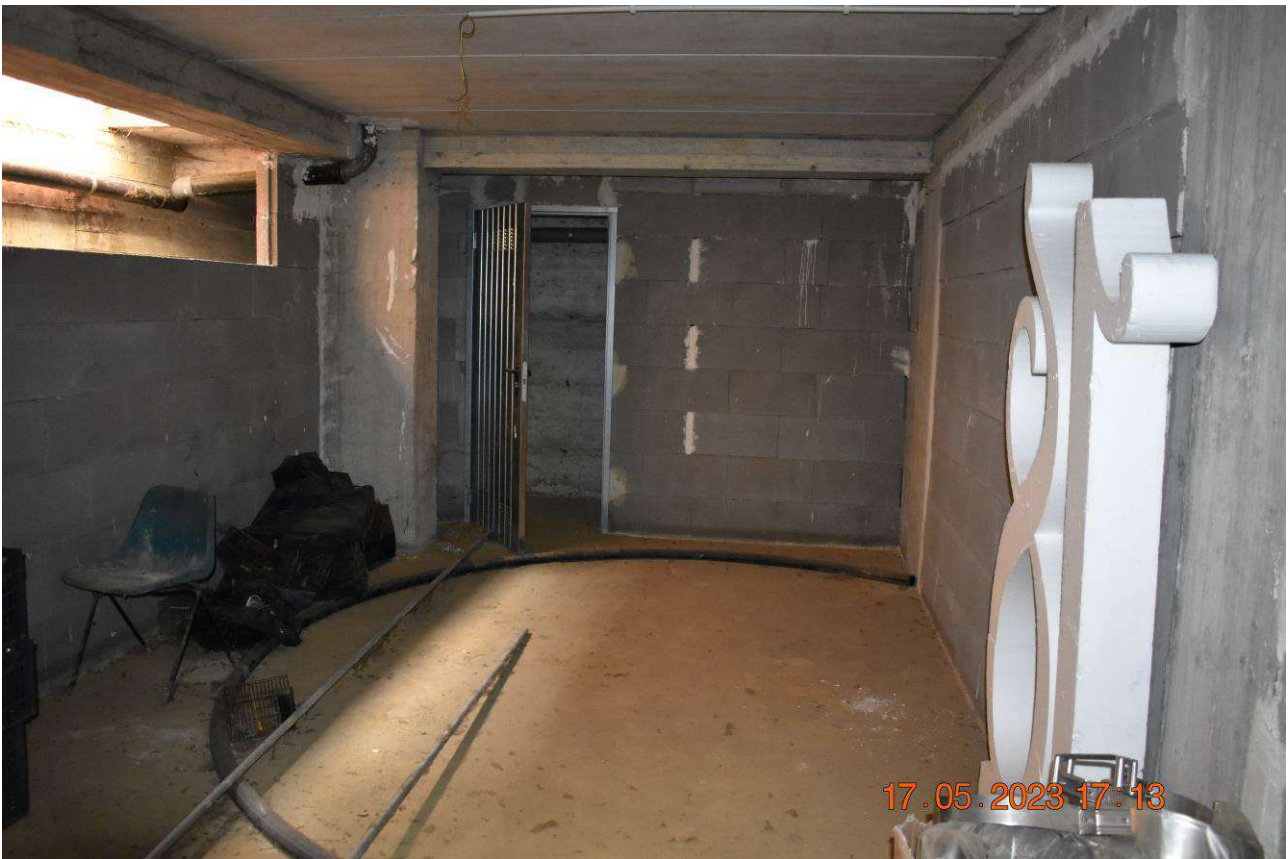
FOTO N.6: Interno box sub 8.
