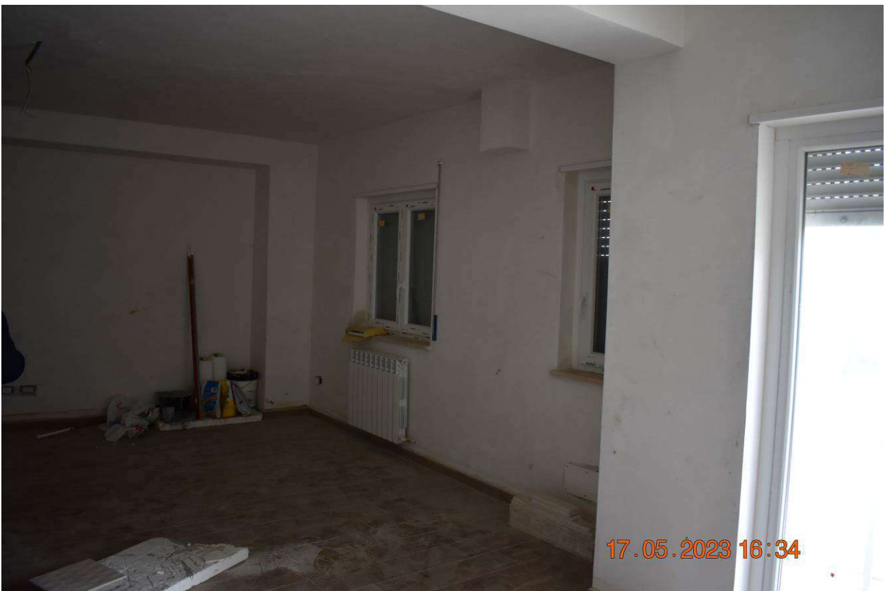
FOTO N.10: Ingresso soggiorno. Si notano gli infissi esterni in PVC.
