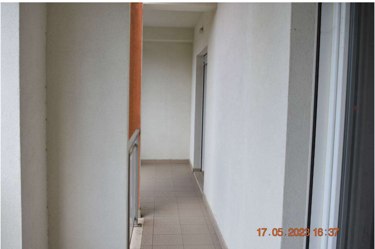
FOTO N.38: Balcone lato nord
