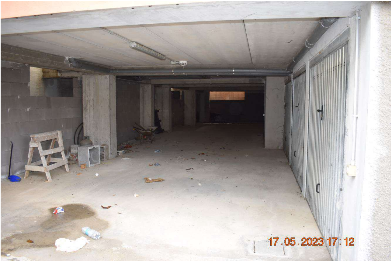
FOTO N.3: Area interna di accesso ai box
