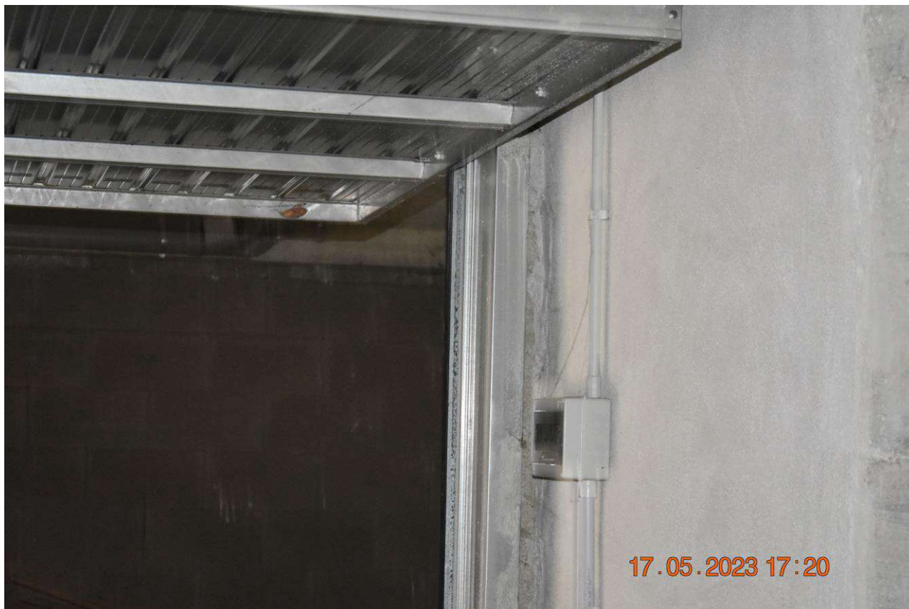
FOTO N.12: Interno box sub 10.
