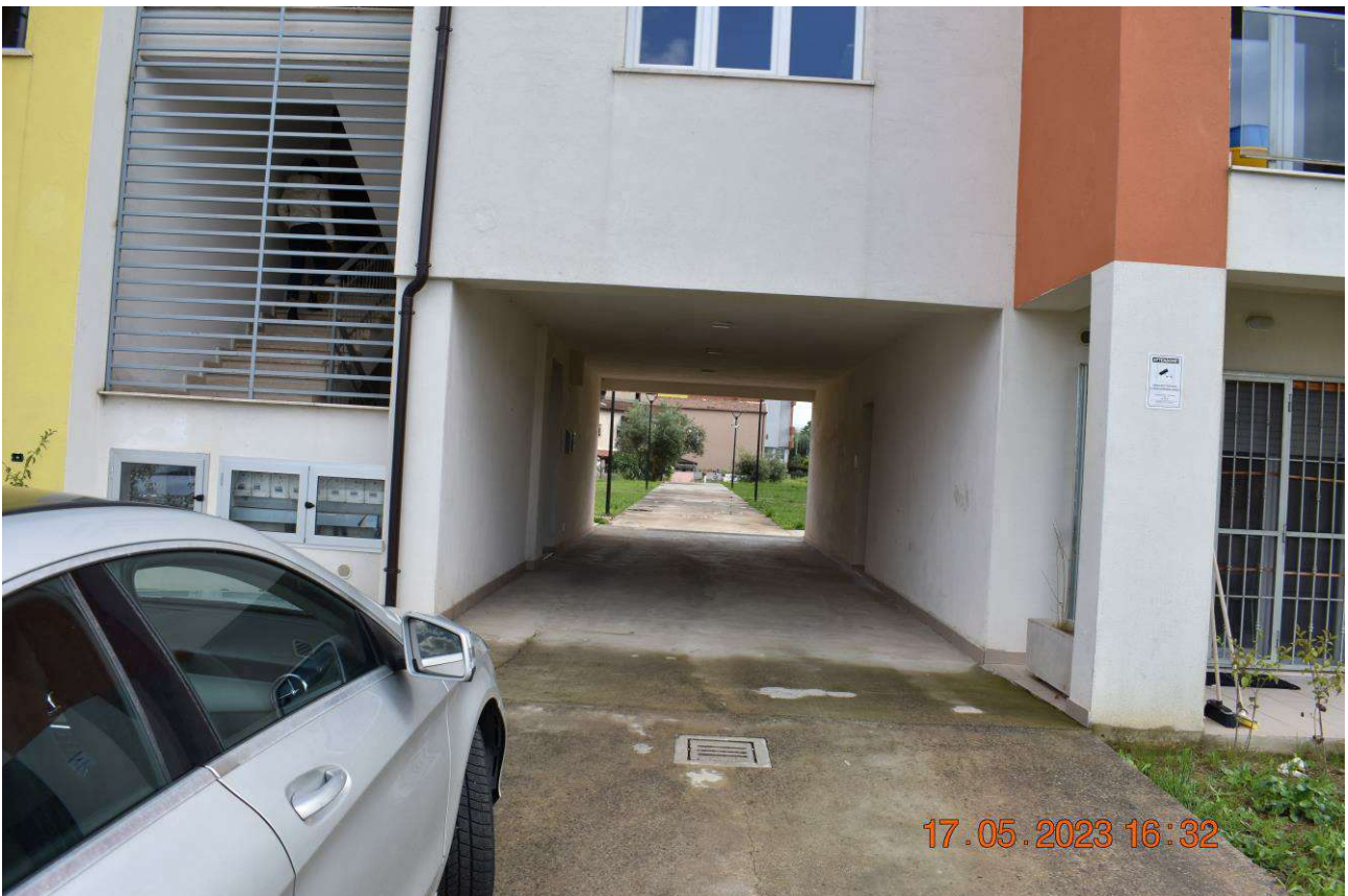
FOTO N.4: Fabbricato Via Ettore Majorana SNC - Rende: Prospetto Principale Nord. Sottoportico ingresso agli appartamenti pignorati.
