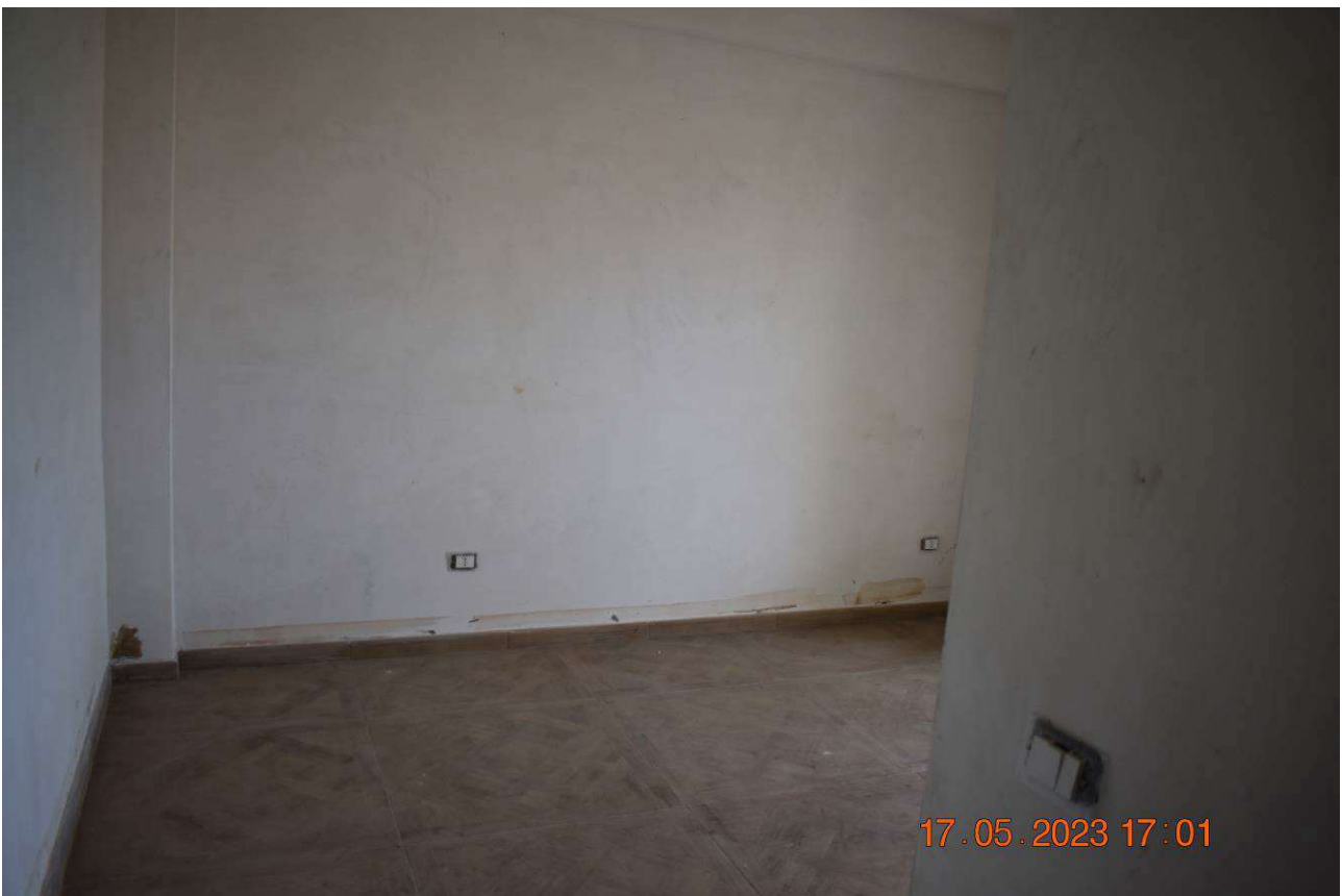
FOTO N.18: Particolare pavimento dell'appartamento.
