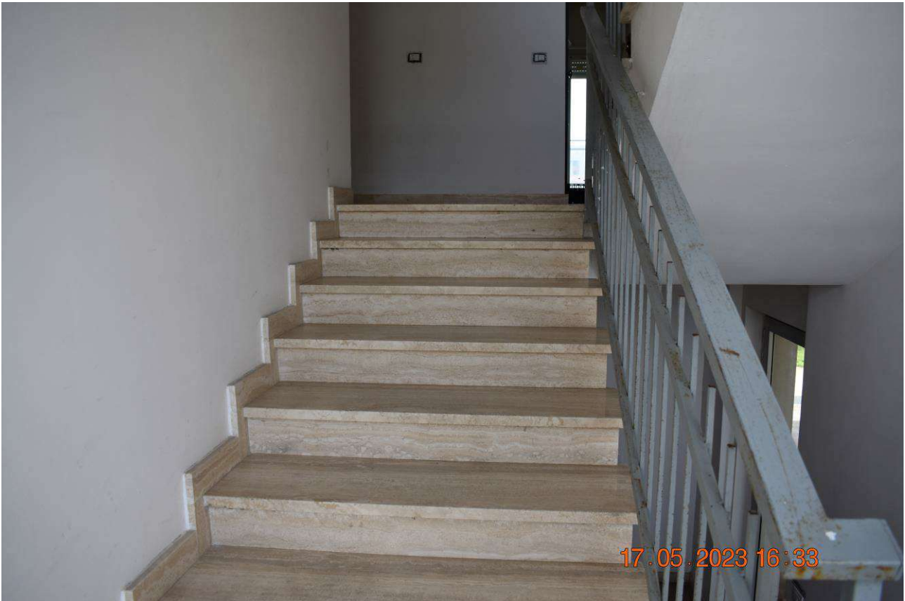
FOTO N.7: Seconda rampa di scala che conduce all'appartamento del primo piano.
