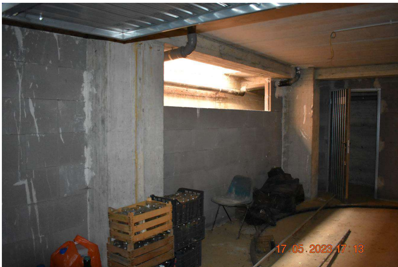
FOTO N.7: Interno box sub 8.
