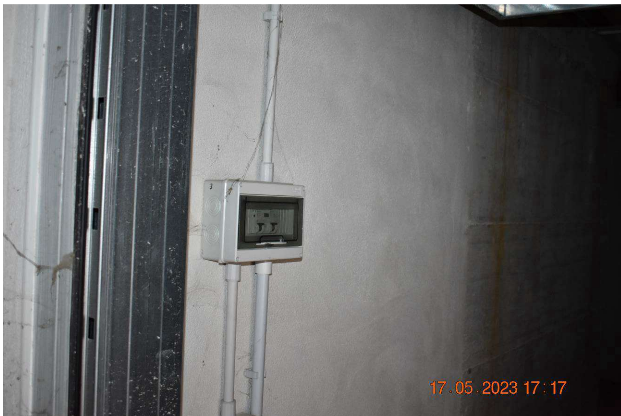
FOTO N.11: Interno box sub 10.
