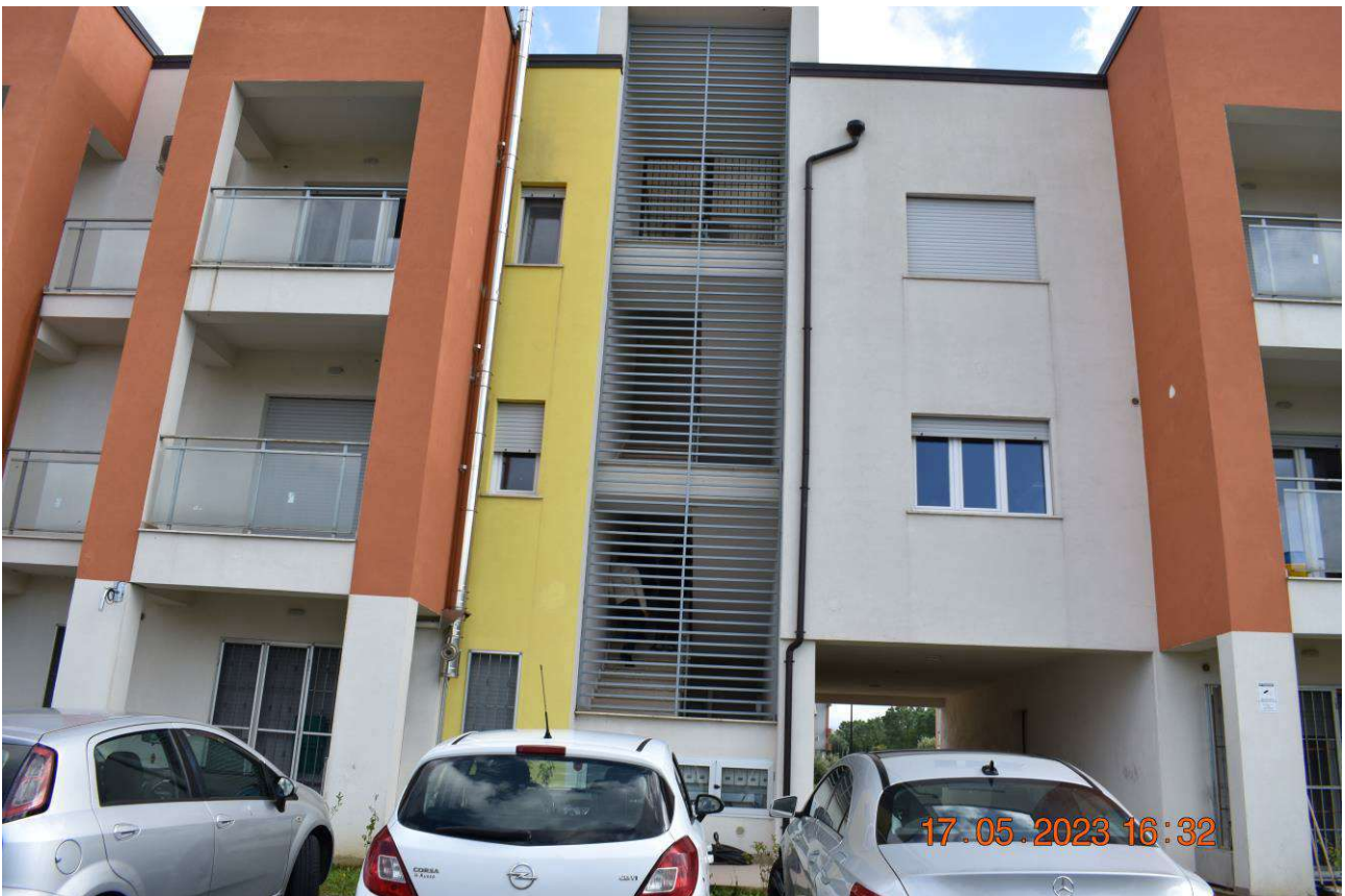
FOTO N.2: Fabbricato Via Ettore Majorana SNC - Rende: Prospetto Principale Nord. Al 1° e 2° piano gli immobili pignorati.
