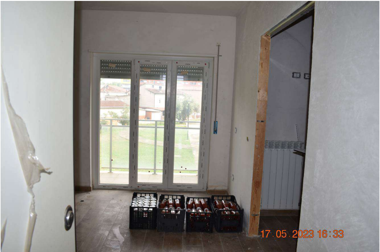
FOTO N.9: Ingresso soggiorno. Si notano gli infissi esterni in PVC.
