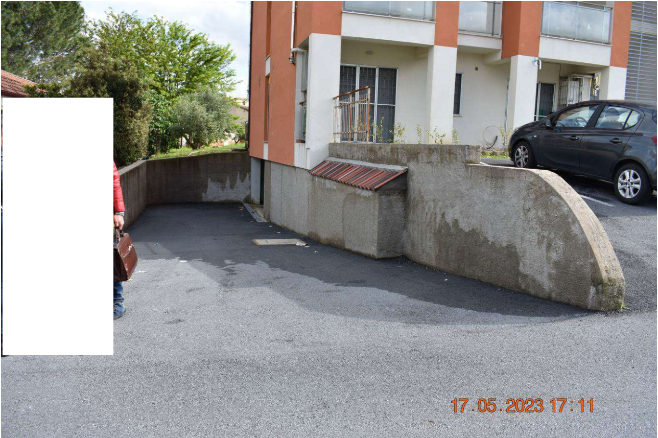
FOTO N.1: Fabbricato Via Ettore Majorana – Strada di accesso ai box primo piano sotto strada.
