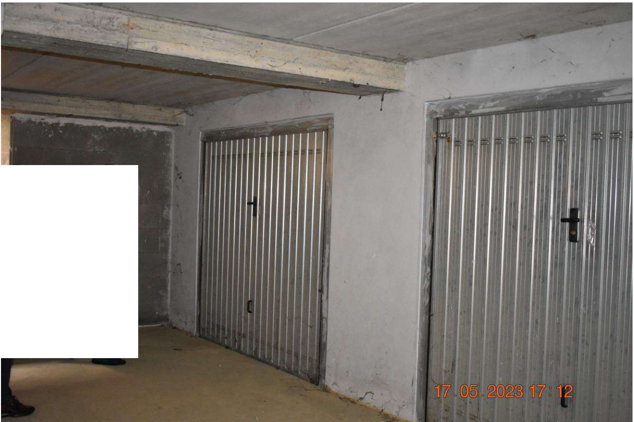
FOTO N.4: Porta di ingresso al box sub 8.
