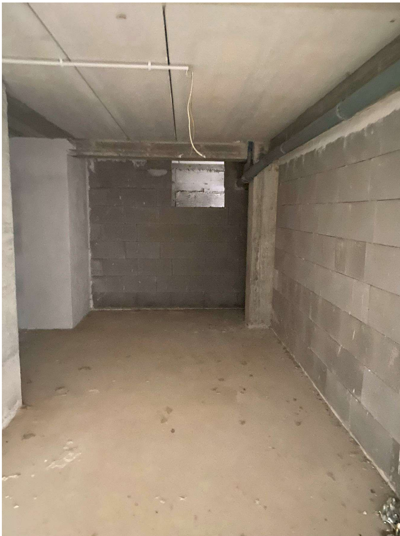
FOTO N.13: Interno Box sub 10
