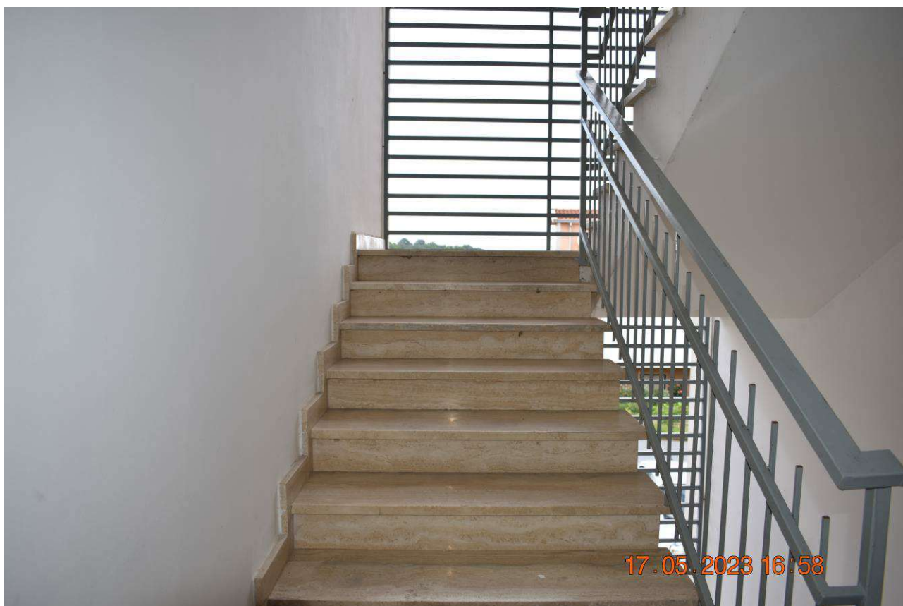
FOTO N.1: Prima rampa di scala dal primo piano (sub 5) al secondo piano (sub 6).
