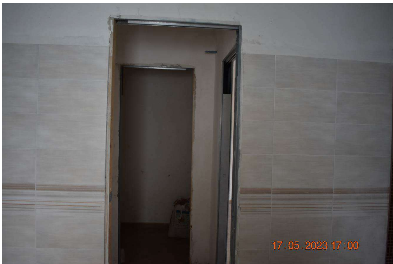
FOTO N.16: Dal bagno verso il ripostiglio
