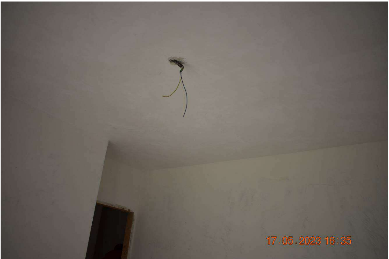
FOTO N.24: Ingresso verso disimpegno camera da letto 2 e ripostiglio
