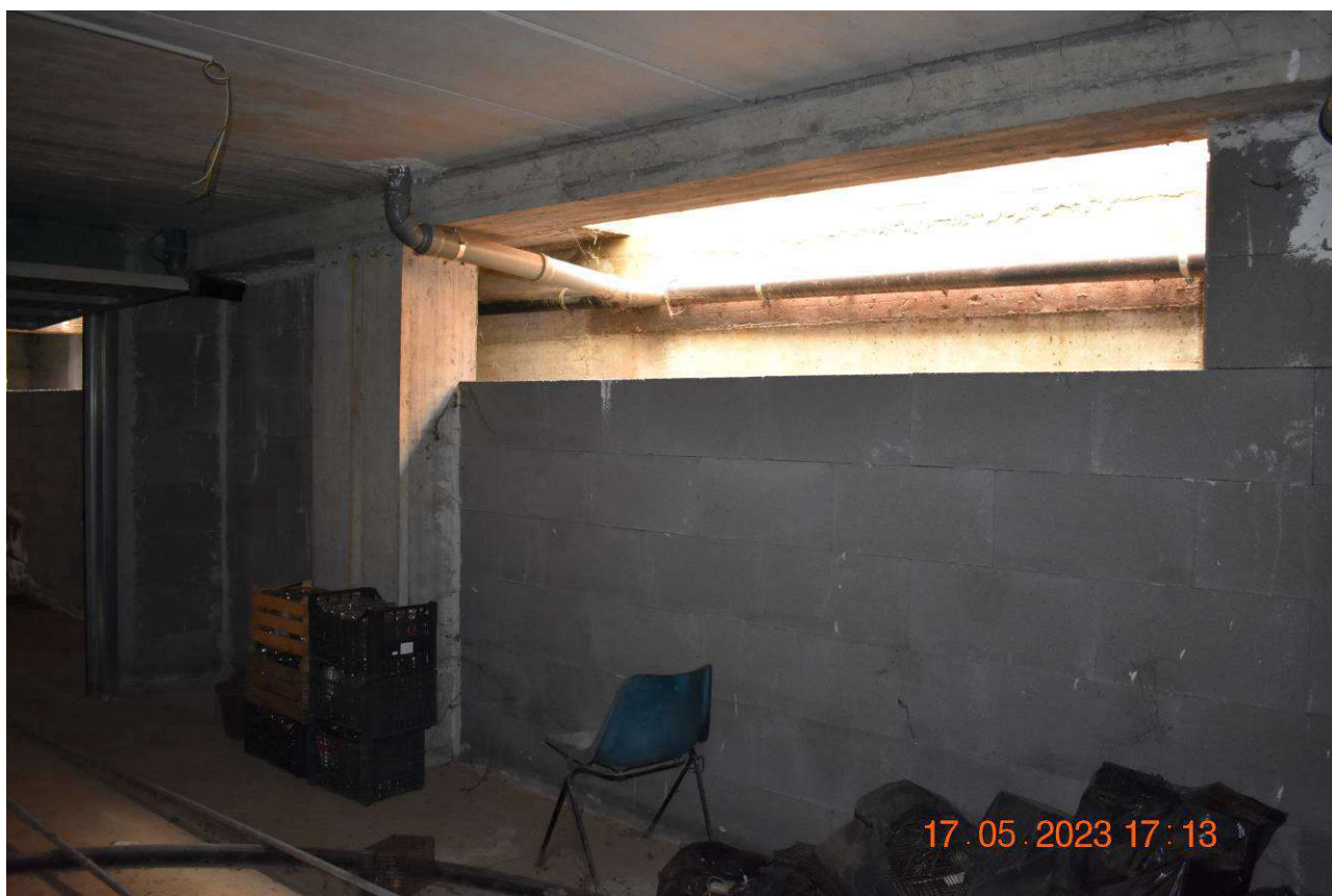
FOTO N.8: Interno box sub 8.
