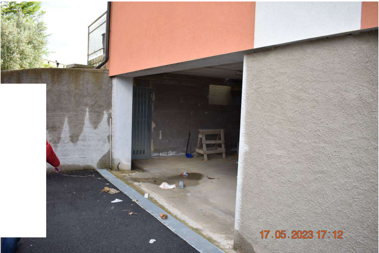
FOTO N.2: Porta di accesso ai box primo piano sotto strada.
