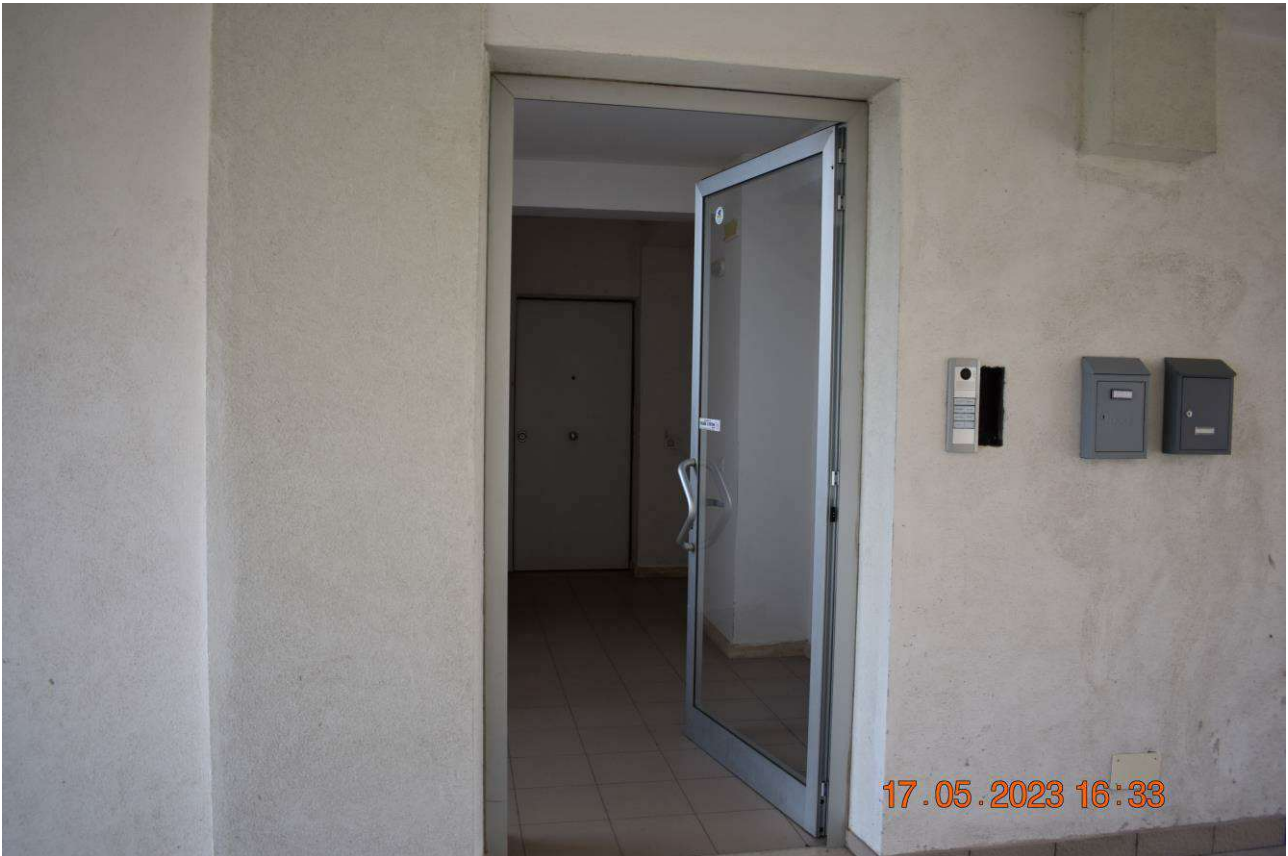
FOTO N.5: Portone di ingresso al fabbricato.
