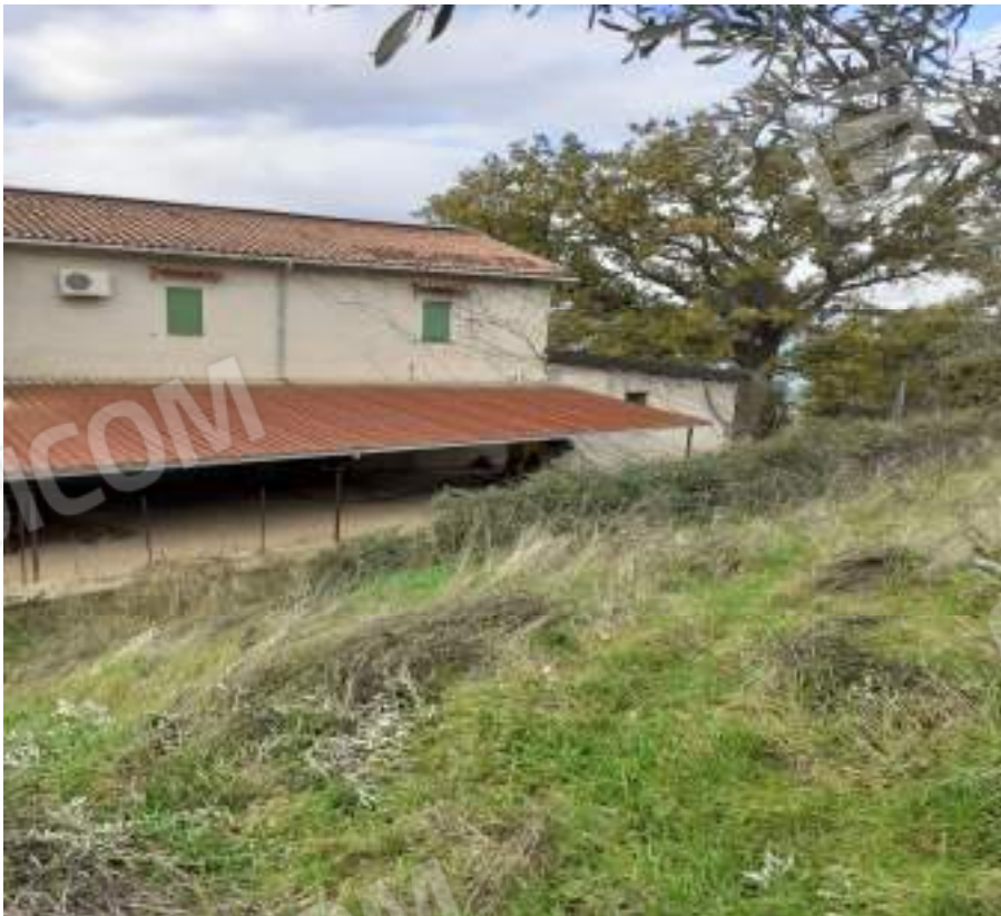
PART 458 VISTA LATO EST TETTOIA
