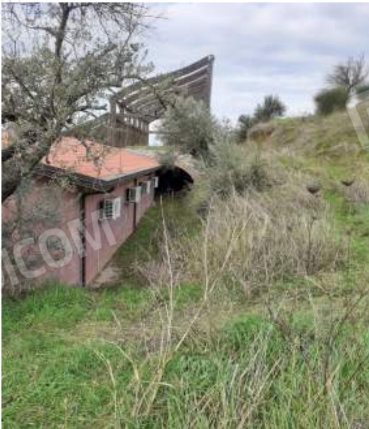
VISTA PART 752 ESTERNO LATO EST E TETTOIE PART 751
