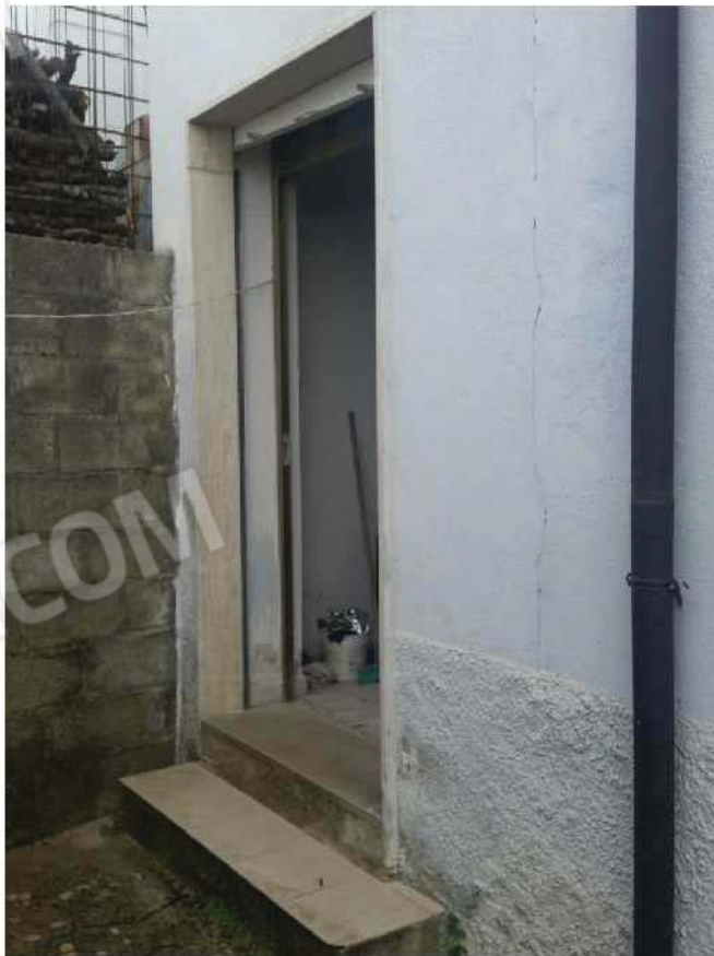
Foto 10 – Ingresso Locale Deposito
