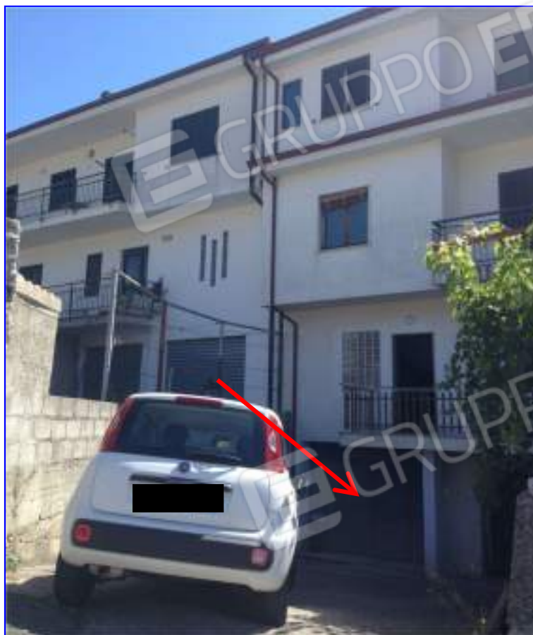
Foto 1 – Vista rampa di accesso e porta d'ingresso
