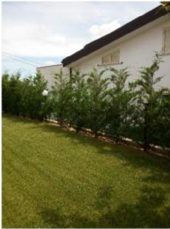
Foto n. 65 - Piano Terra - Corte immobile
