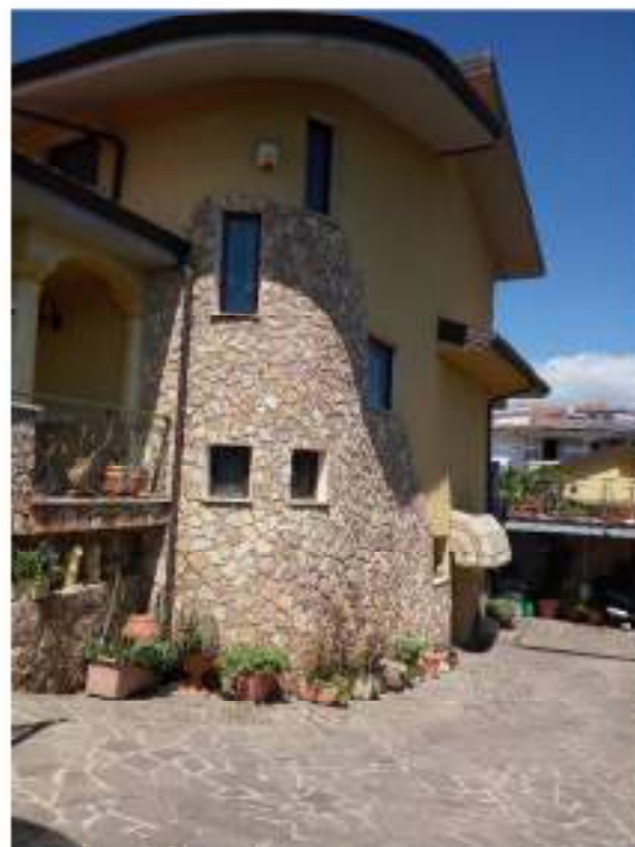
Foto n.16 Ingresso Carrabile Piano seminterrato
