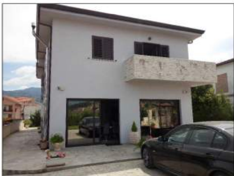
Foto n. 67 - Piano Terra - Prospetto Ovest
