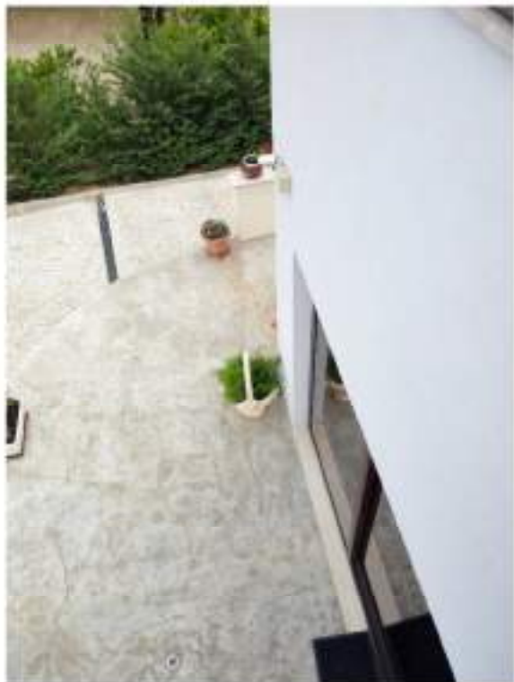
Foto n. 61 - Piano Terra - Corte immobile
