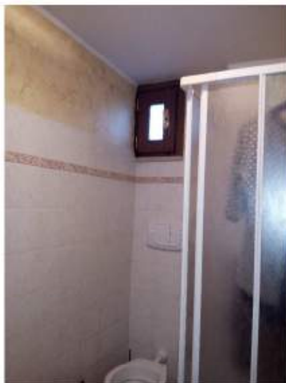
Foto n.29 Piano Seminterrato - Servizio Igienico
