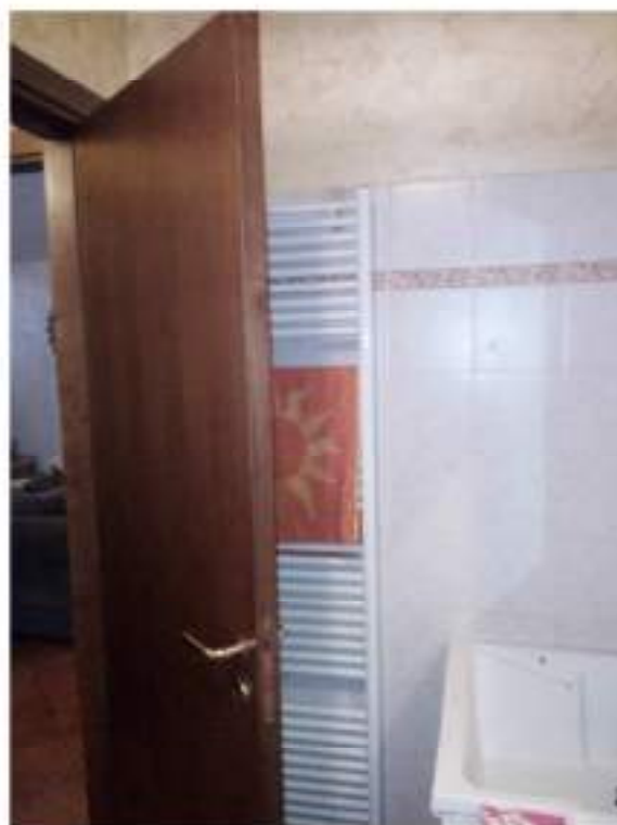
Foto n.30 Piano Seminterrato - Servizio Igienico
