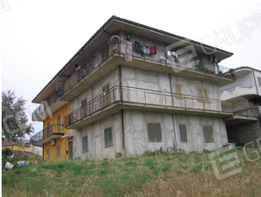
Foto n° 2 - Fabbricato (spigolo sud-est)
