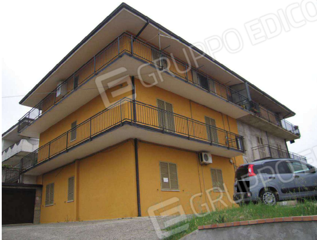
Foto n° 1 - Fabbricato (spigolo sud-ovest)
