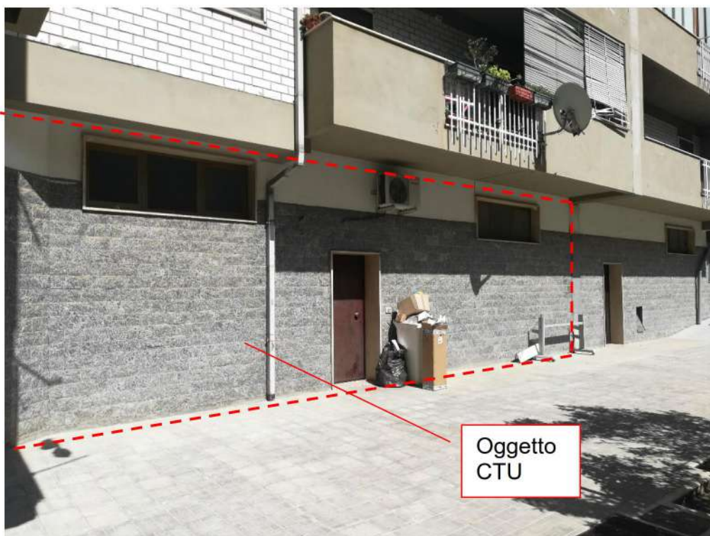
VISTA DALLA CORTE NON ESCLUSIVA
