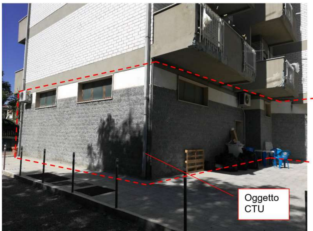
VISTA DALLA CORTE NON ESCLUSIVA
