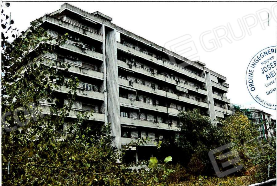
Fotografia 2 – Fabbricato foglio 3, particella 451 (lato Ovest)
