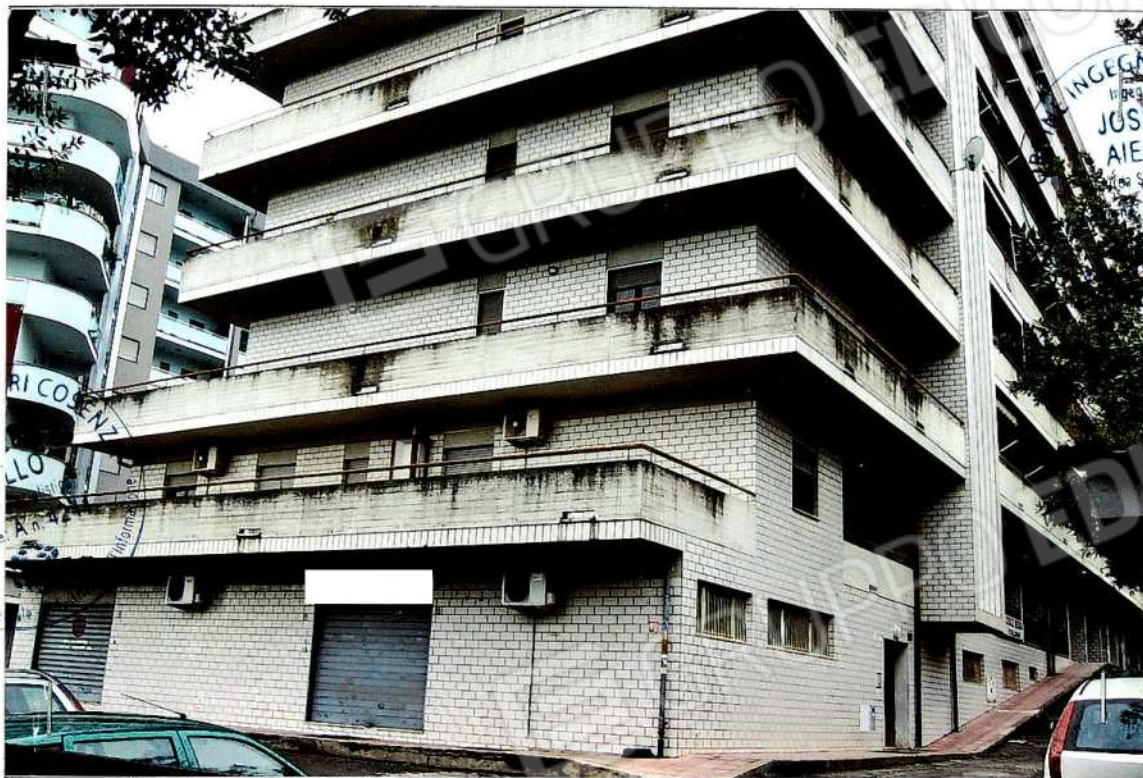
Fotografia 3 – Fabbricato foglio 3, particella 451 (lato Nord)
