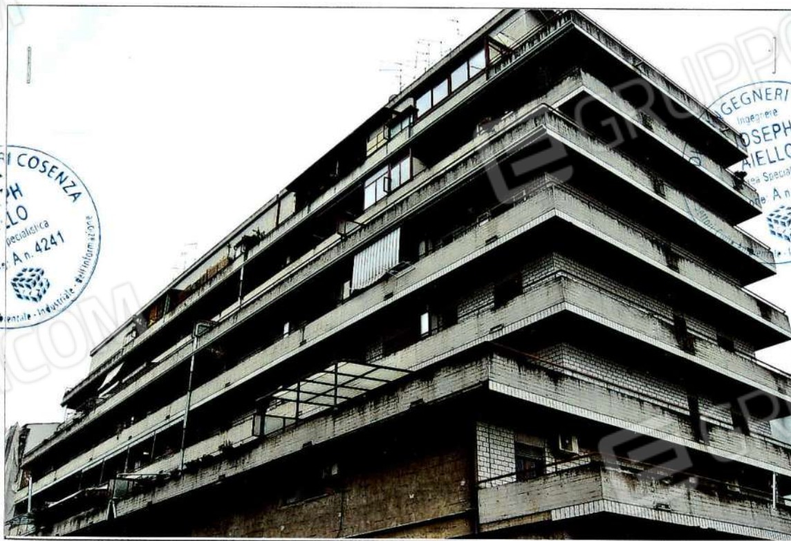
Fotografia 4 – Fabbricato foglio 3, particella 451 (lato Est)
