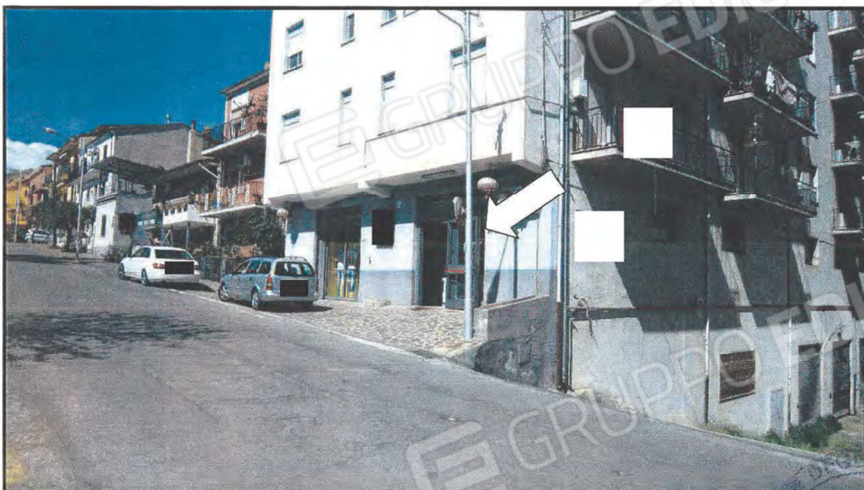
Foto 1 Fabbricato nel suo insieme in vista da Sud-Est
