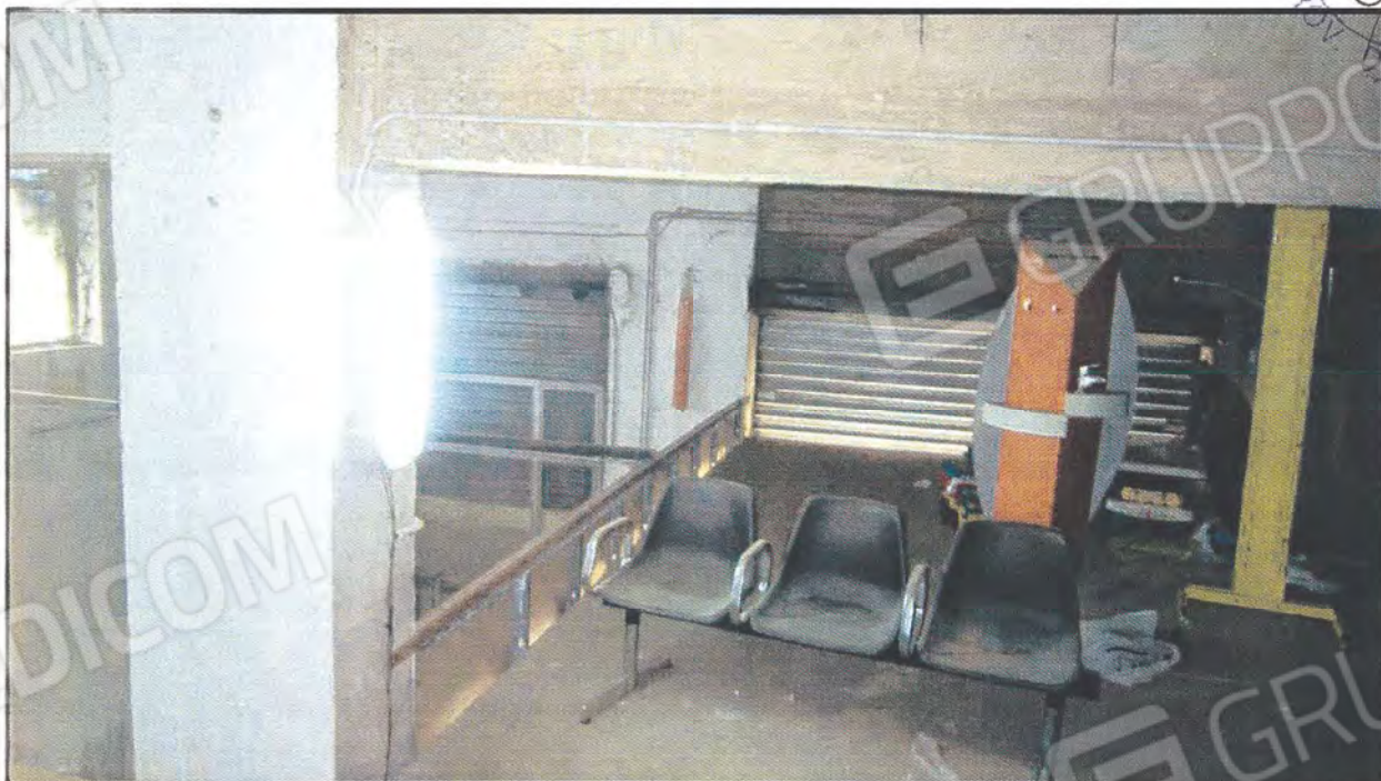
Foto 12 Interno del magazzino – Soppalco ed ingressi
