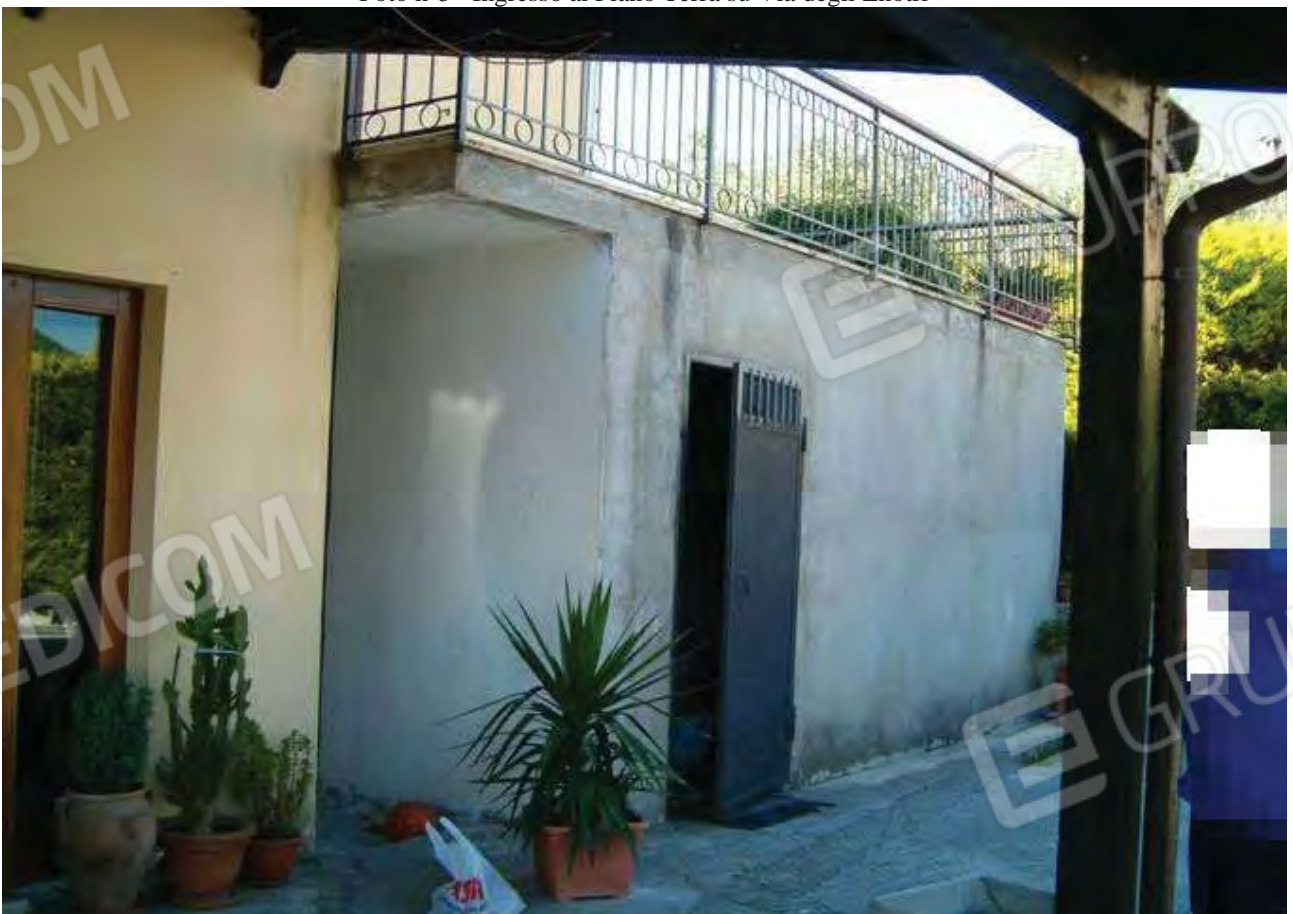
Foto n°6 –Chiusura in muratura dell'area sottostante il balcone
