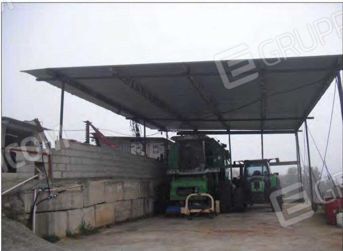
Foto n. 2 – Località Baullo ....Fg. 35 par.lla 652 sub 2 – Comune di Montalto Uffugo (CS)
