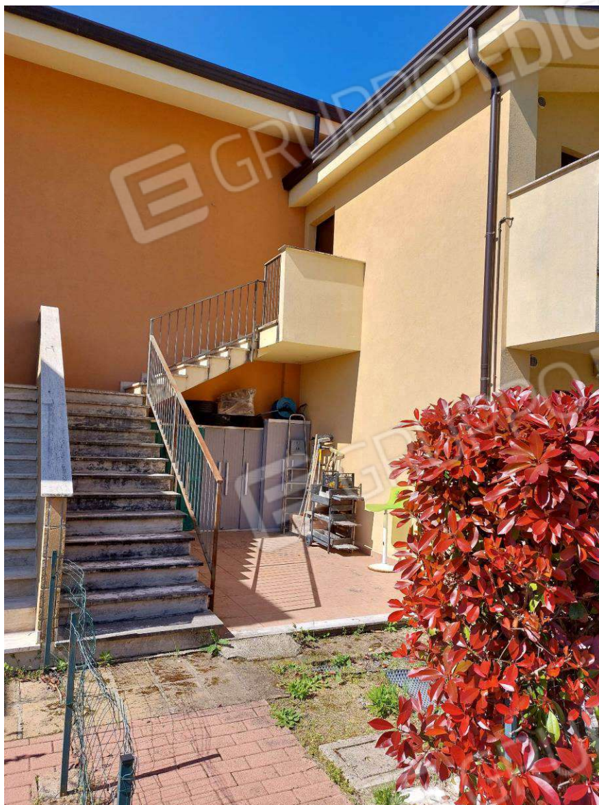
Foto N.9: Sub.4_ Prospetto fabbricato Est
