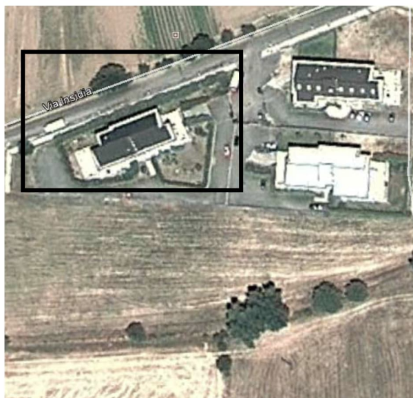
Figura 1 – Immagine aerea del fabbricato
