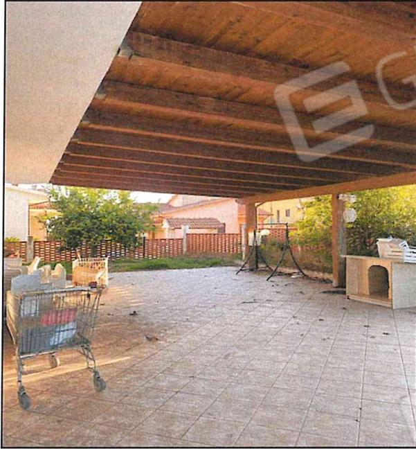
Foto n° 15 – Vista esterno fabbricato, portico in legno lamellare, provvisto di scossaline, grondaie e pluviali
