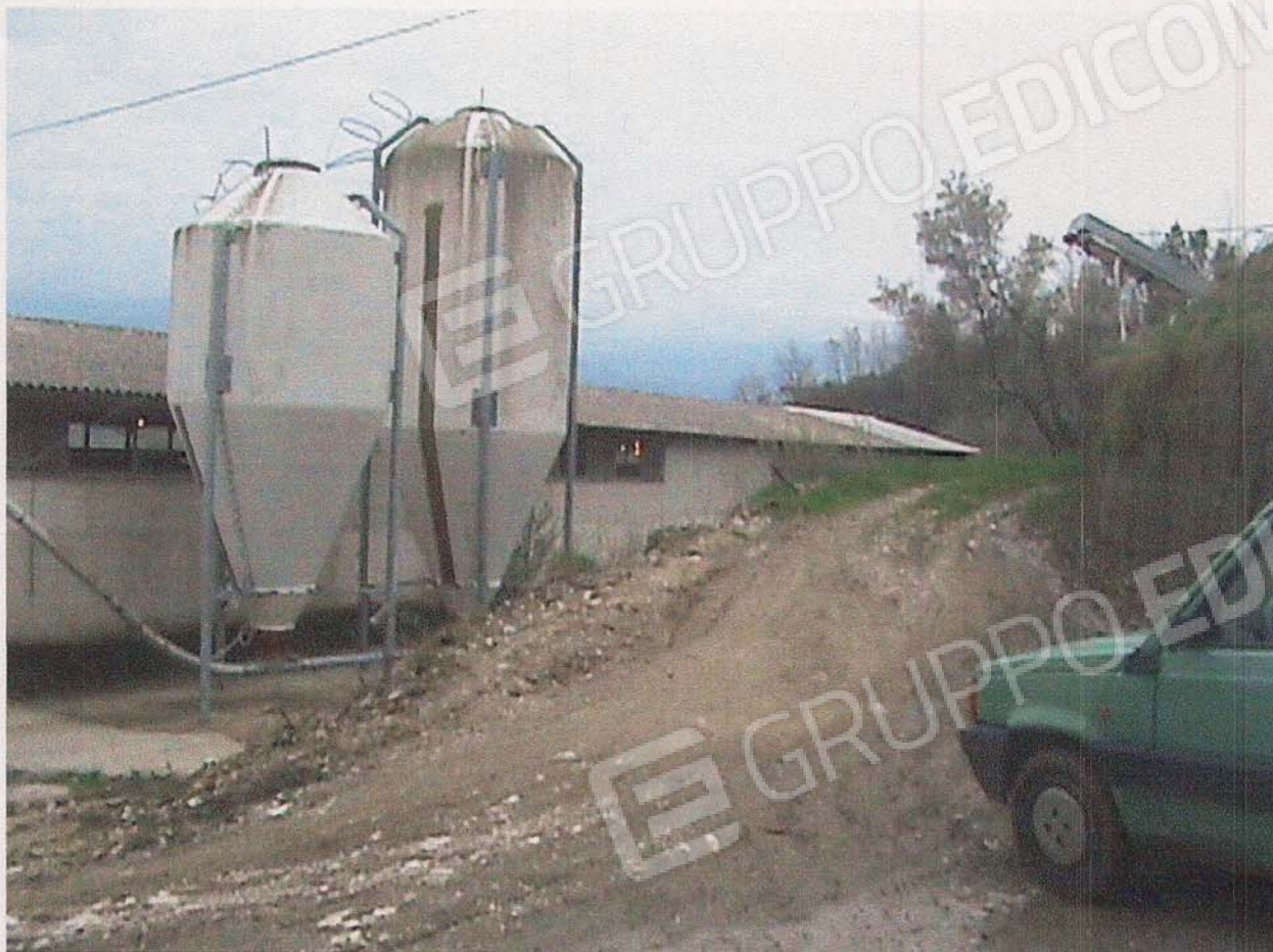
7. SILOS PER ALLEVAMENTO NEL CAPANNONE 392 FOGLIO 38
