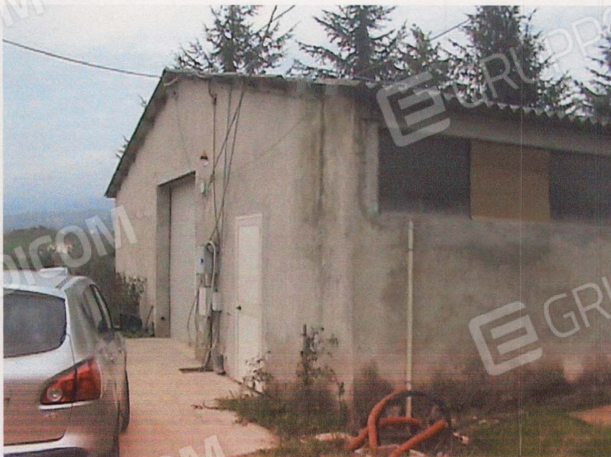
2. CAPANNONE AGRICOLO, FOGLIO 38, PART. 387 LATO NORD OVEST
