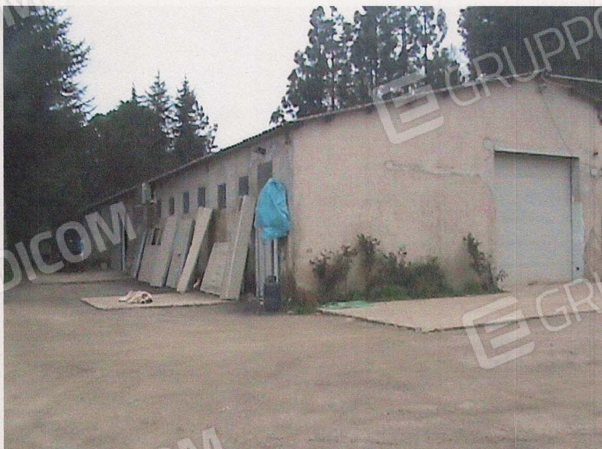
4. CAPANNONE AGRICOLO FOGLIO 38 PART. 387 LATO NORD EST
