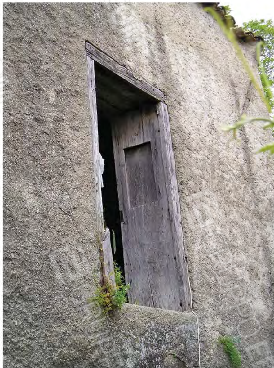
Foto n. 14: Particolare infissi in legno
