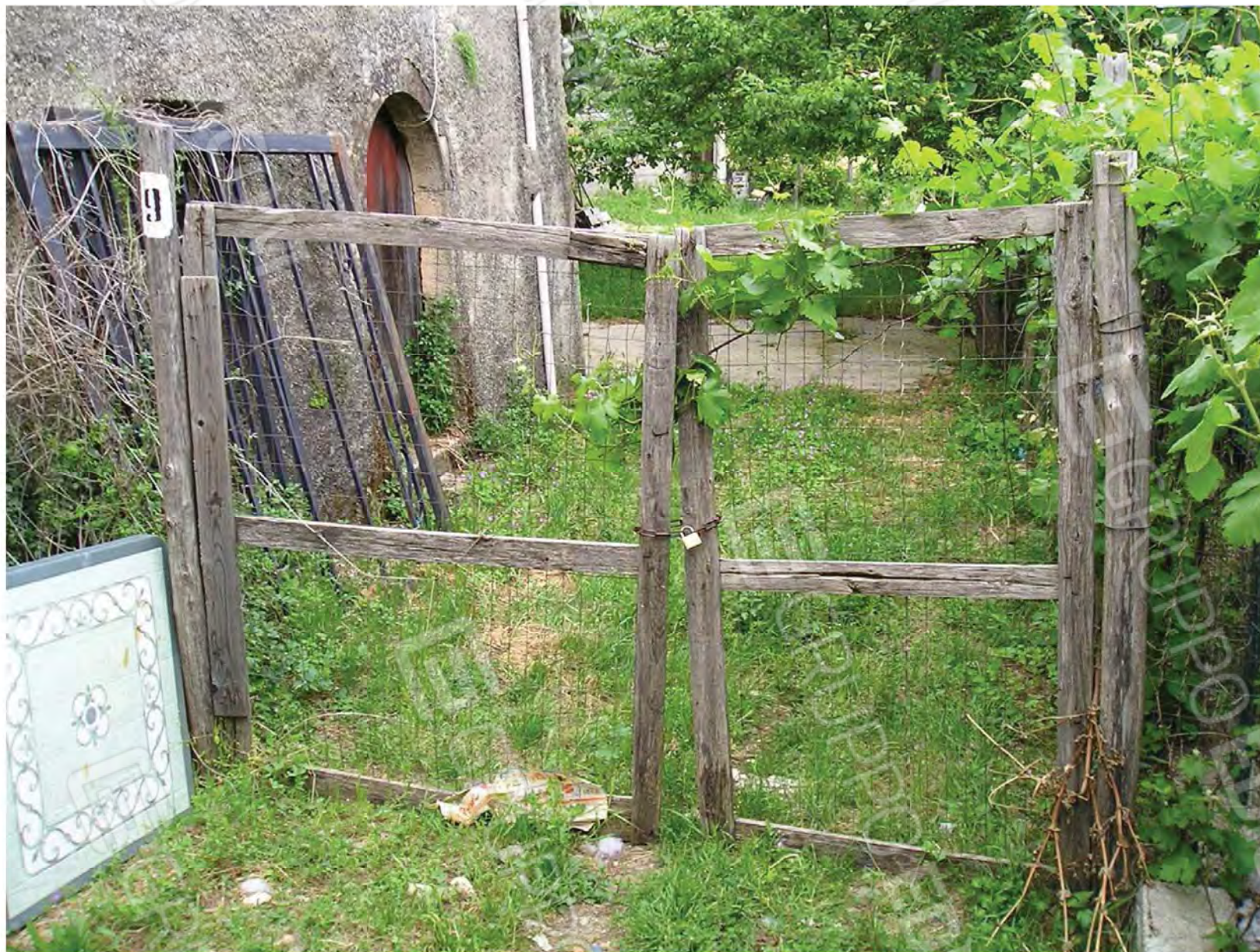
Foto n. 7: Accesso al piano terra
