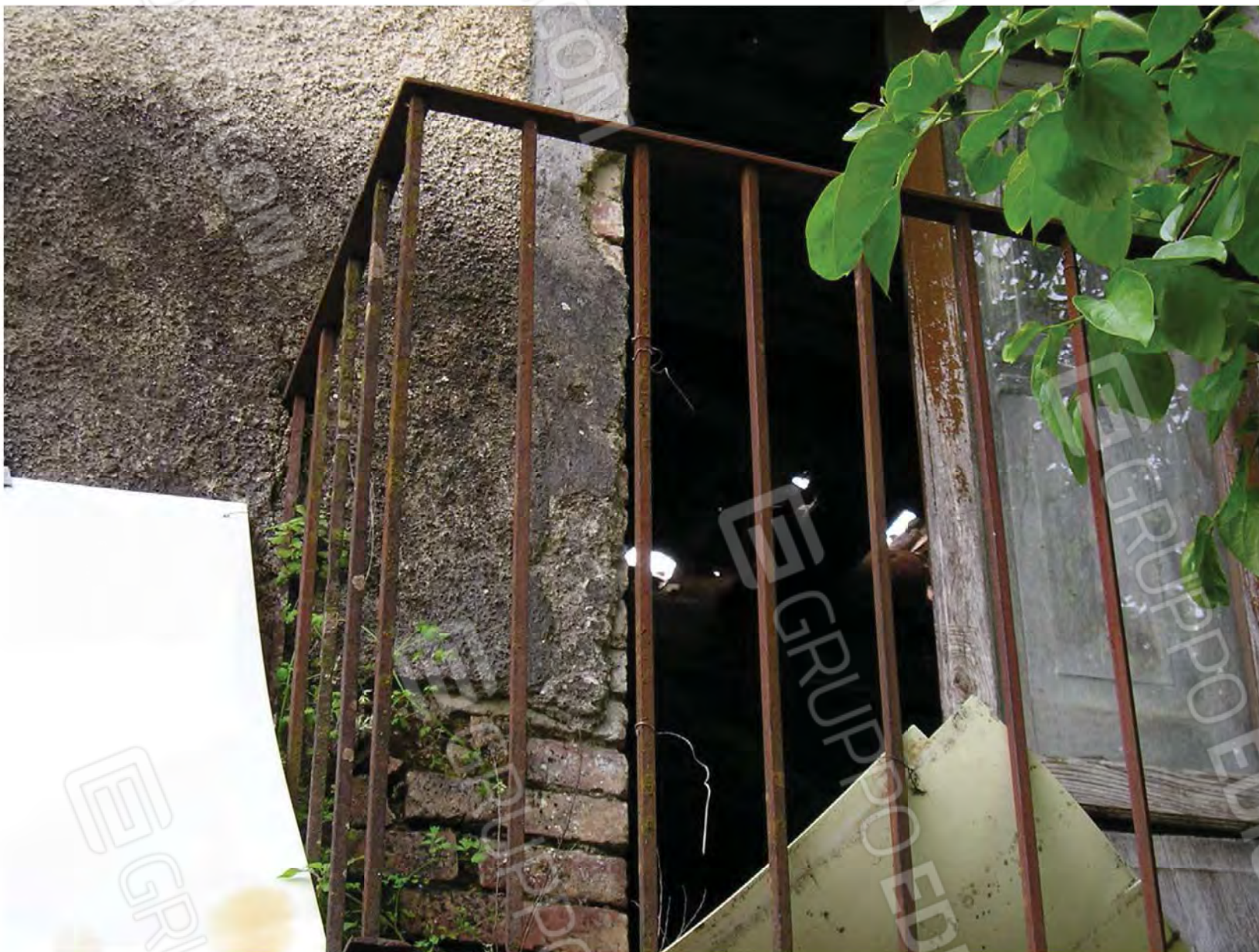
Foto n. 13: Balcone posto al piano primo
