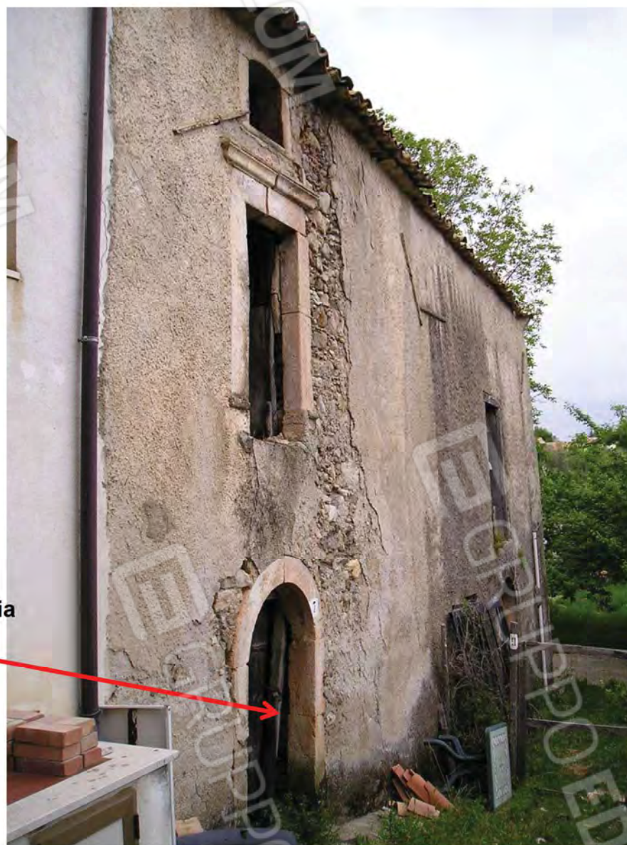
Foto n. 6: Fabbricato pignorato disposto su tre livelli
