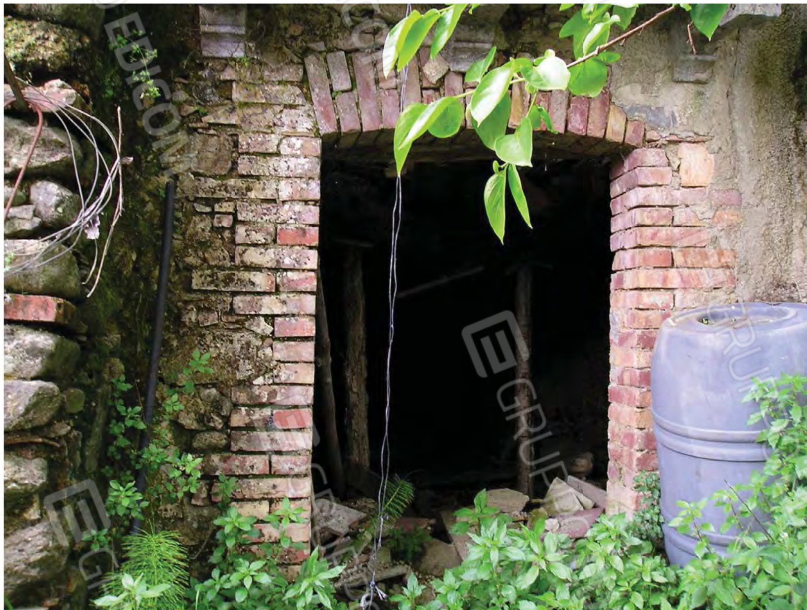
Foto n. 9: Esterno del fabbricato - particolare
