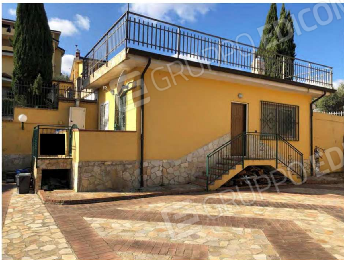
Foto 57 - Fabbricato, Mendicino, fg.12, p.IIa 1432, sub.2.
