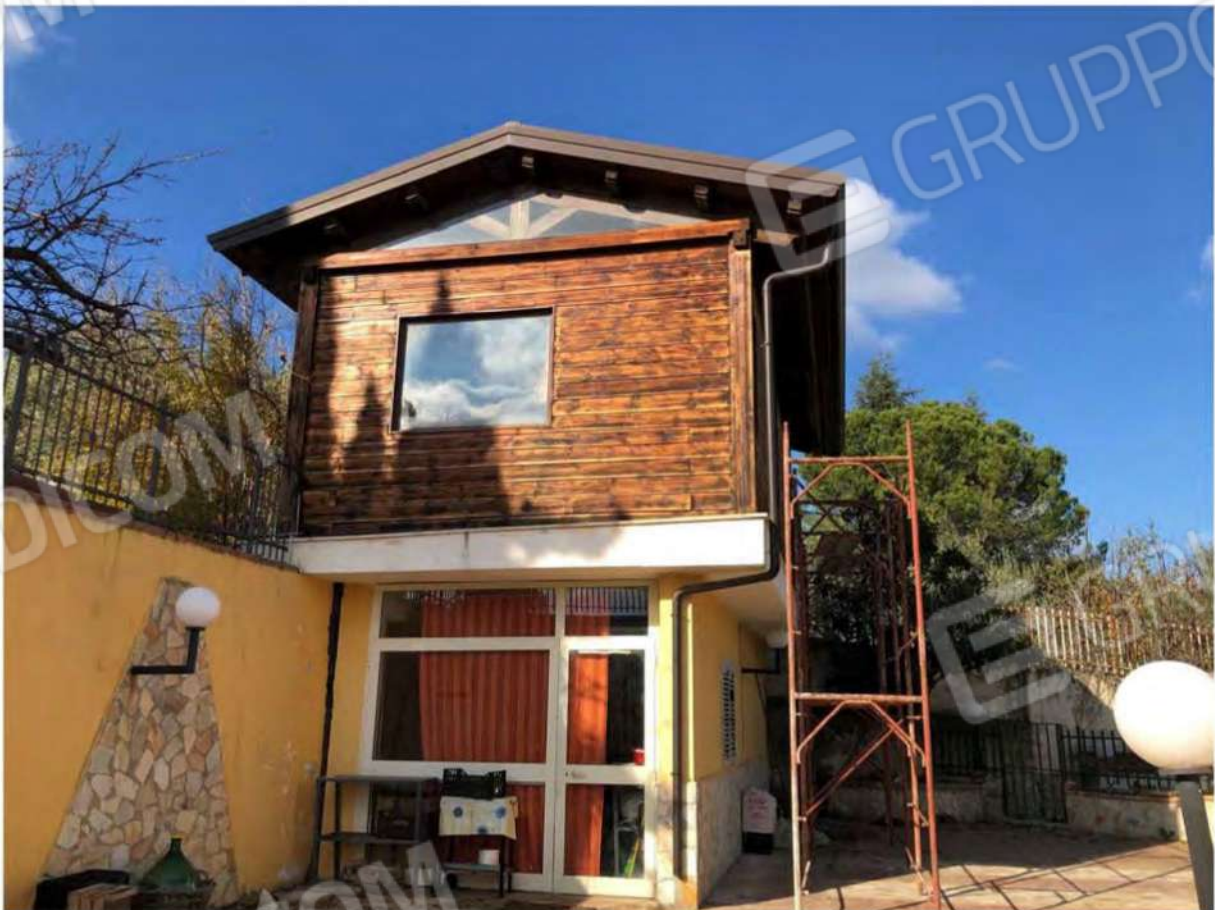
Foto 46 - Fabbricato Mendicino, fg.12, p.la 1431, sub.2.
