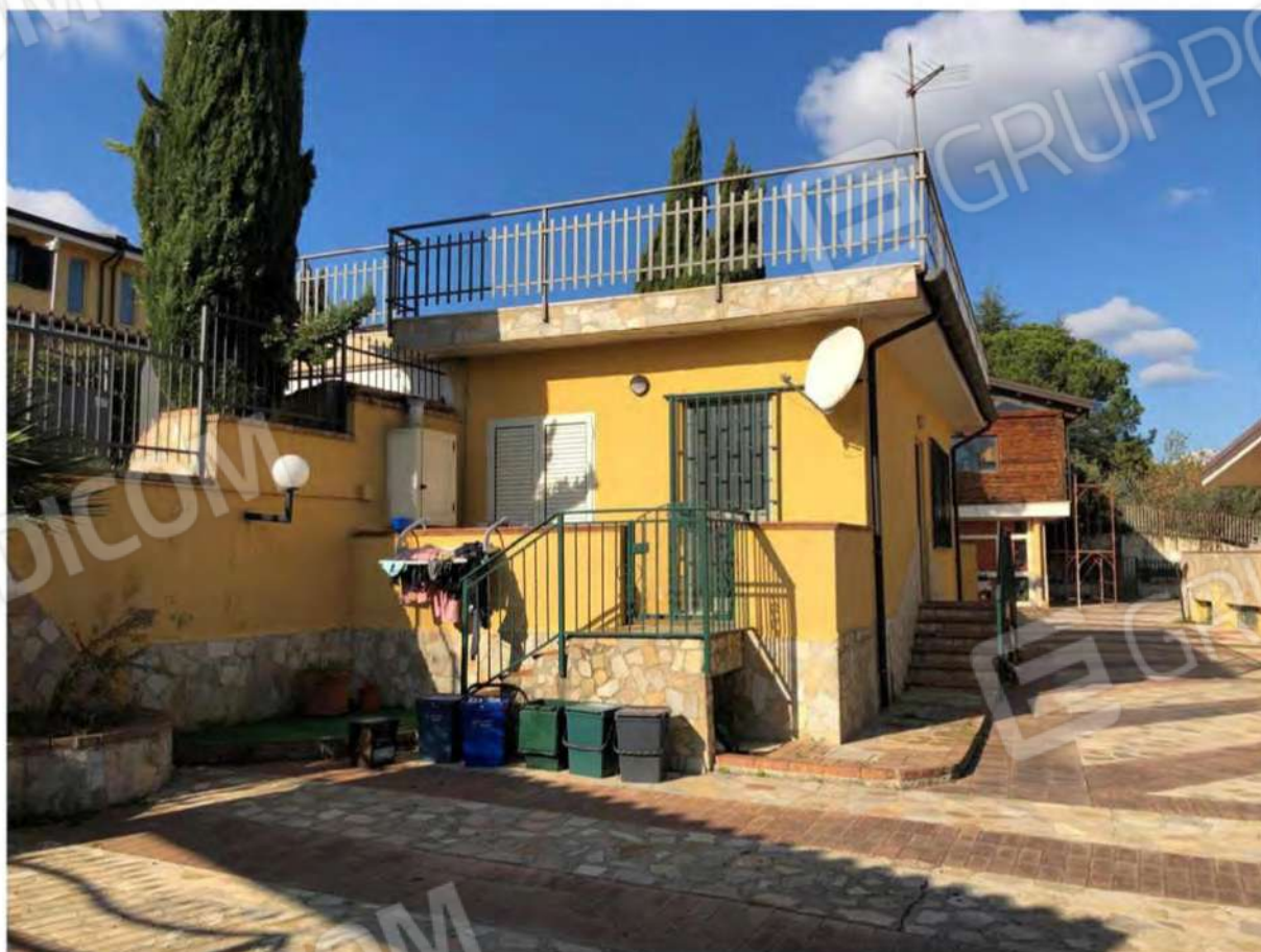
Foto 58 - Fabbricato, Mendicino, fg.12, p.IIa 1432, sub.2.
