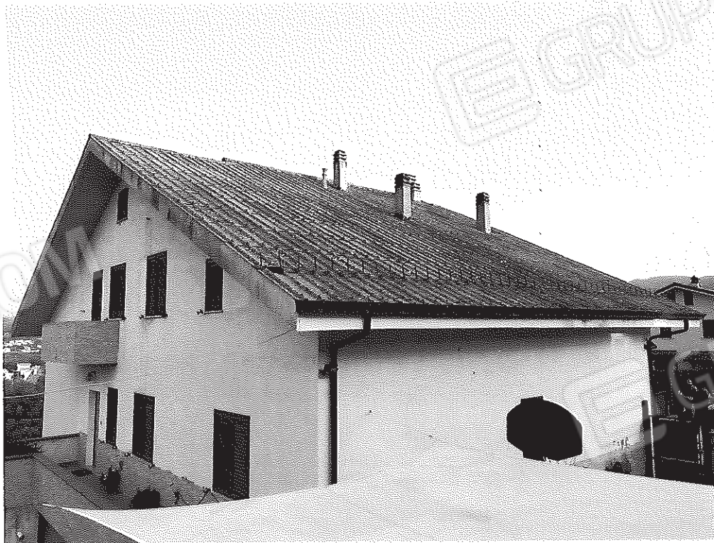
Vista da Nord-Ovest ('retro')
