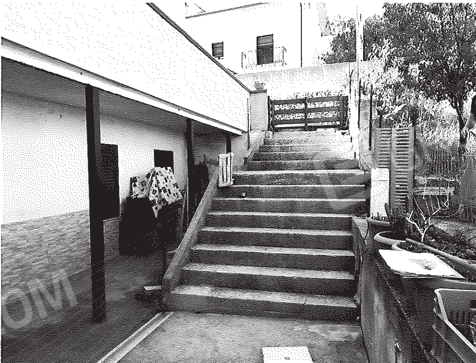
Scala in c.a. vista da sotto.
