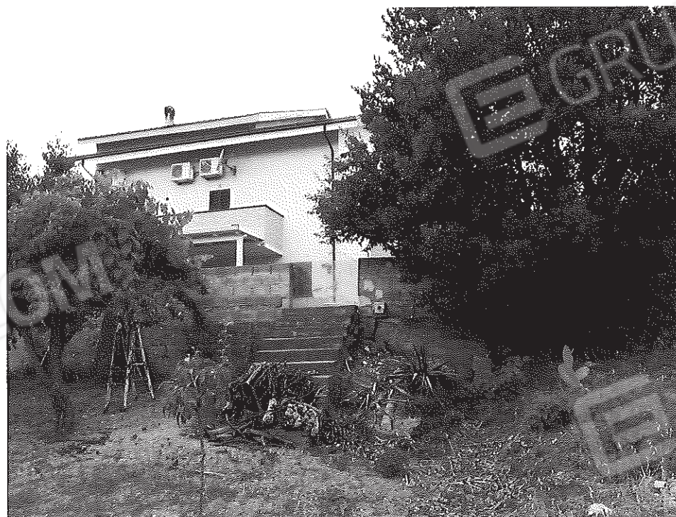
Vista del fabbricato dalla parte adibita ad "area verde". Da notare: muretto di recinzione e scala in c.a. (opere abusive).
