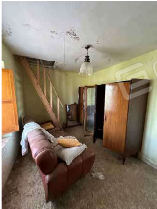
Foto 12: Locali al piano primo - scala di accesso al sottotetto.
