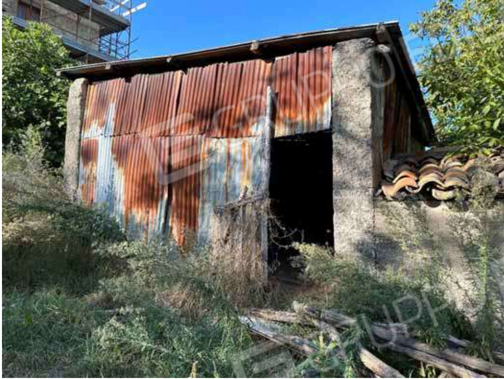
Foto 3: Tettoia Fg. 4 P.IIa 433 sub 2.
