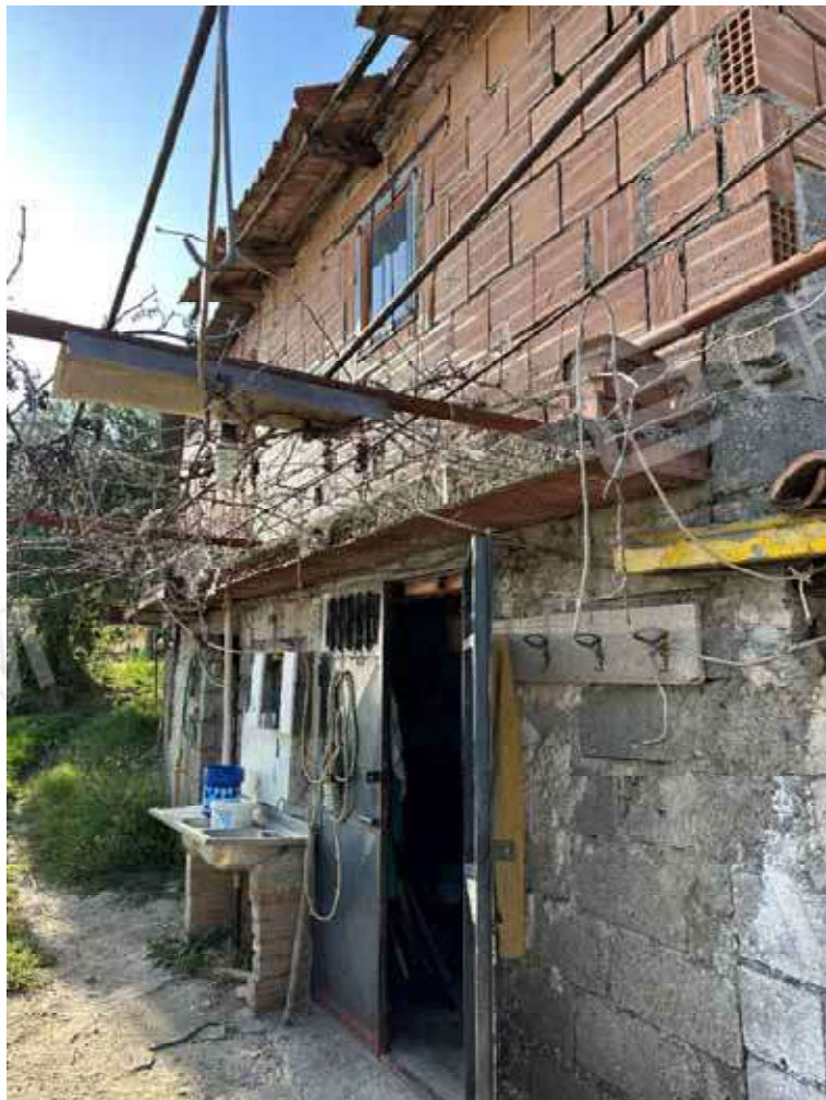
Foto 26: vista esterna fg. 4 p.lla 364 sub 2
