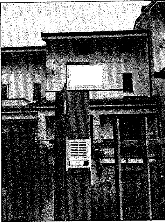
Foto N° 1 Particolare ingresso piano terra
