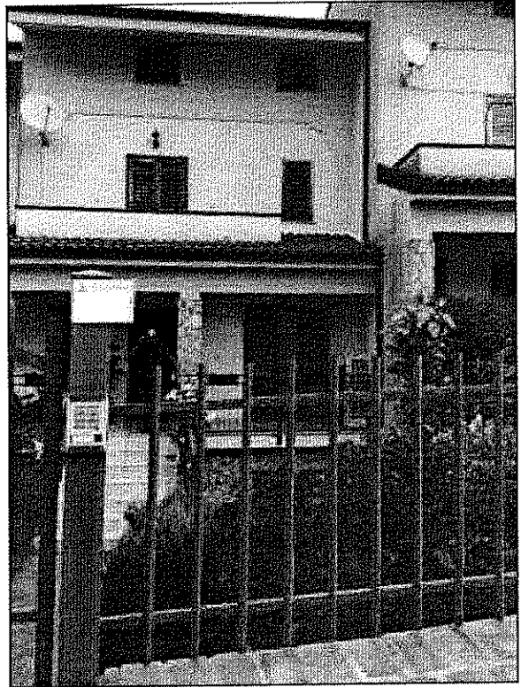
Foto N° 2 Prospetto lato sud-ovest
