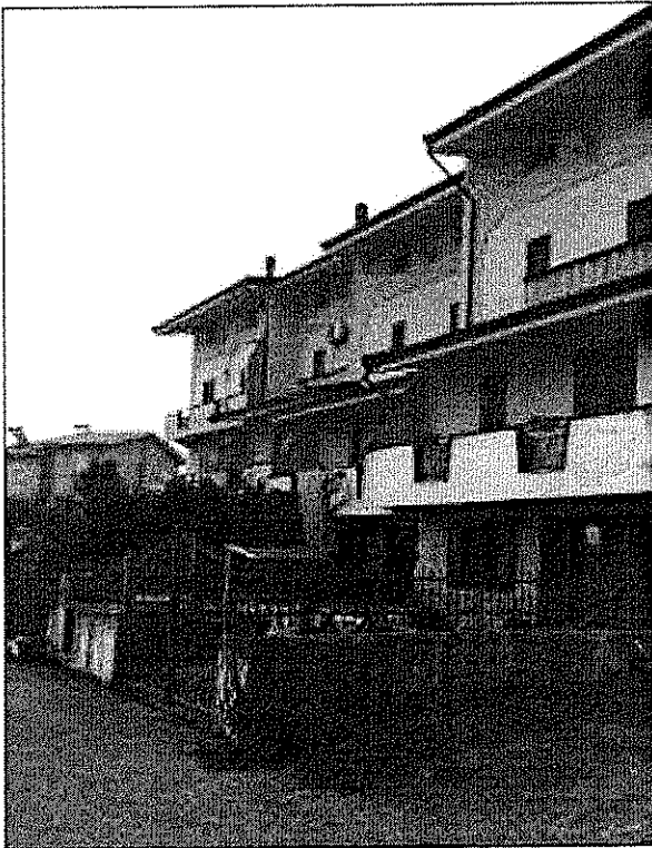
Foto N° 3 Prospetto lato nord-est
