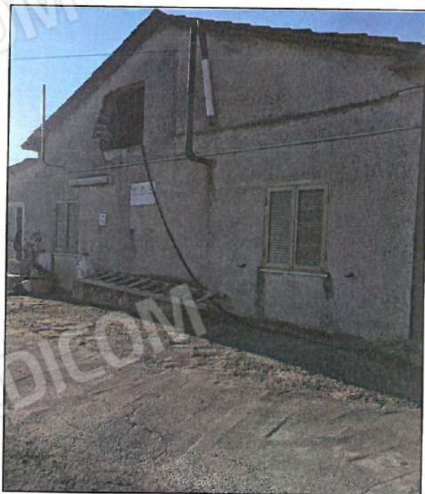
Foto n° 10 – Vista laterale fabbricato.
