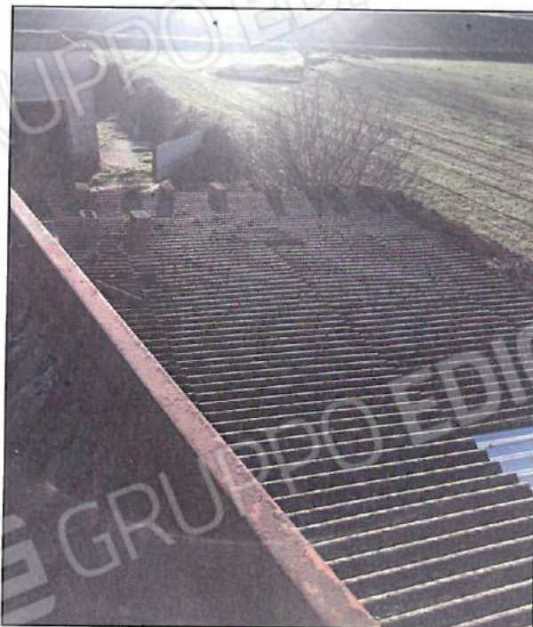
Foto n° 25 – Vista fabbricato, F) particolare copertura, in condizioni sufficientemente a riguardo della sicurezza, mentre la parte a dx è fatiscente.
