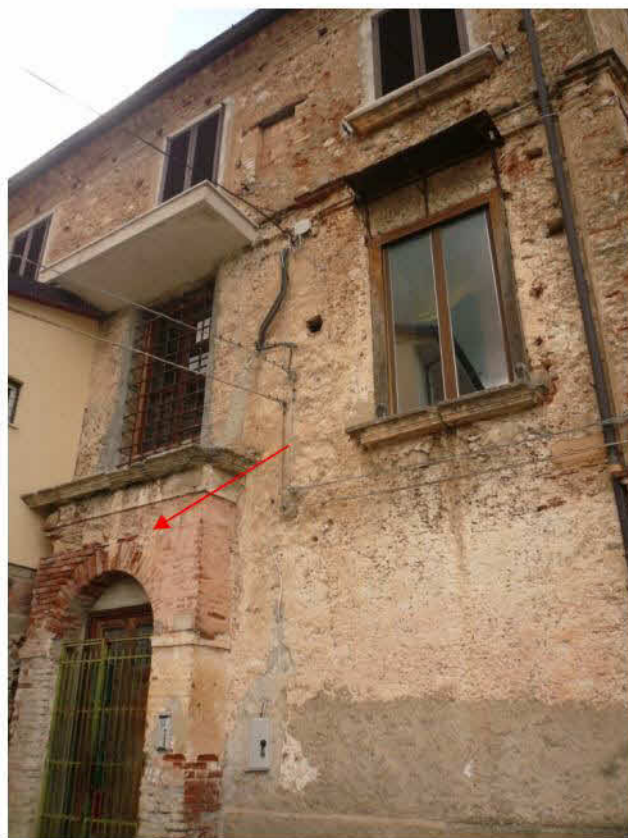
Foto 4 - Ingresso (esterno) Fabbricato
