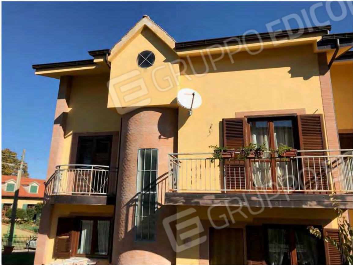
Foto 1: Vista lato ingresso
