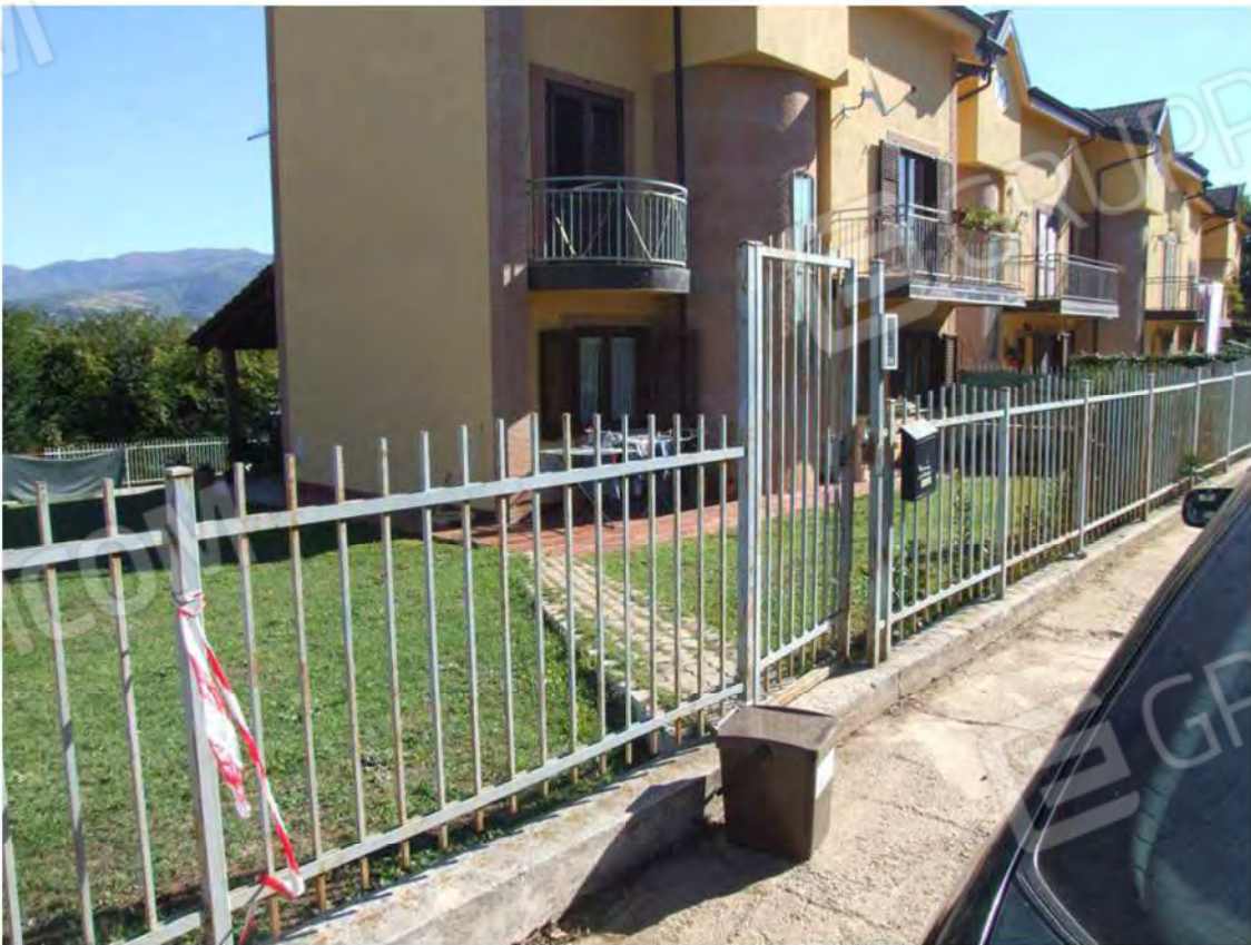
Foto 4: Vista ingresso pedonale con recinzione metallica
