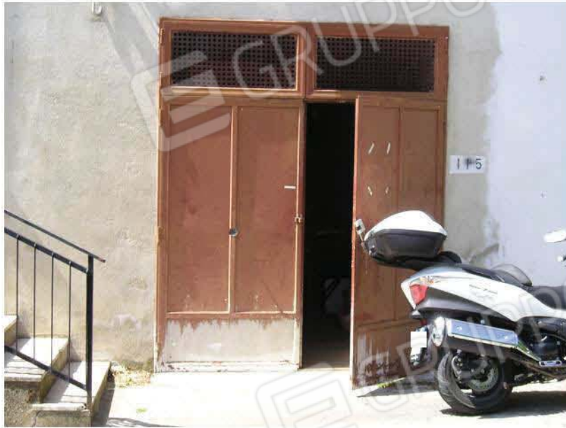
Foto n. 11: locale adibito a legnaia – lotto I
