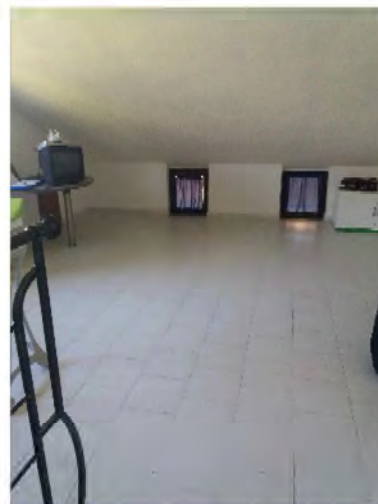
Foto 4: Locale sottotetto - lato Est
