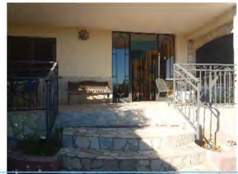
Foto 7: Ingresso al piano seminterrato dalla corte
