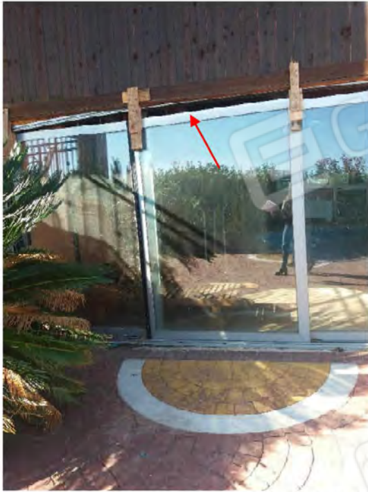
Foto 17: Struttura in legno lamellare lato Nord. Lesioni evidenti alla struttura
