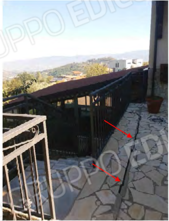
Foto 18: Corte d'ingresso lato Ovest. Lesioni alla pavimentazione
