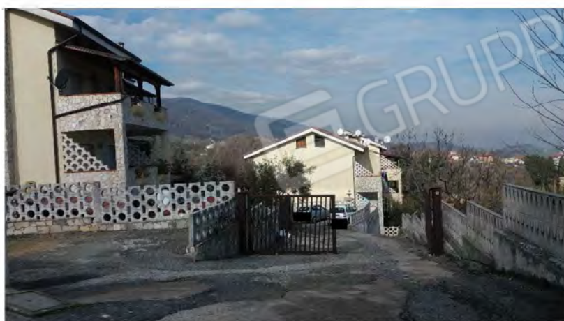
Foto 2: Ingresso al complesso immobiliare da Via Fontanelle
